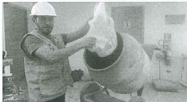
Figura N° 20: Realizando la mezcla de concreto.
