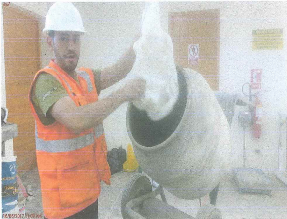
Fotografía N° 23: Realizando la mezcla de concreto.
