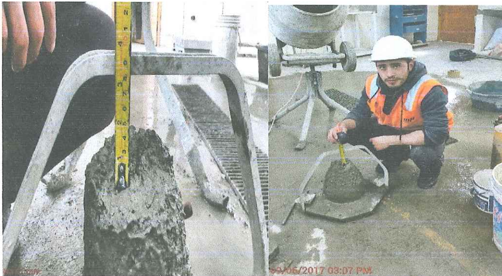
Fotografía N° 27: Verificando que el slump está cumpliendo con el diseño de mezcla
