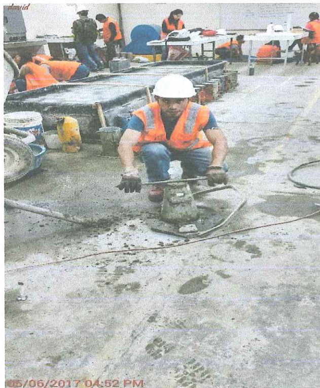
Fotografía N° 26: Realizando el ensayo de slump.
