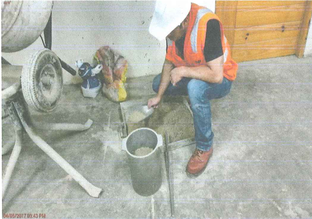
Fotografía N° 9: Agregando material al molde para luego ser compactadas con una varilla de 5/8"
