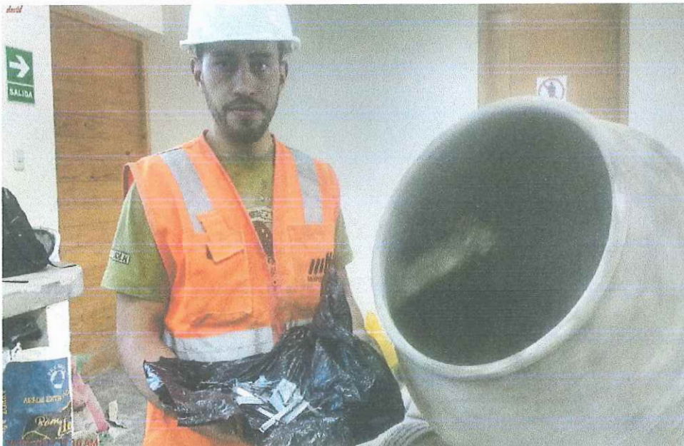
Fotografía N° 24: Colocando las fibras de acero en la mezcla de concreto.
