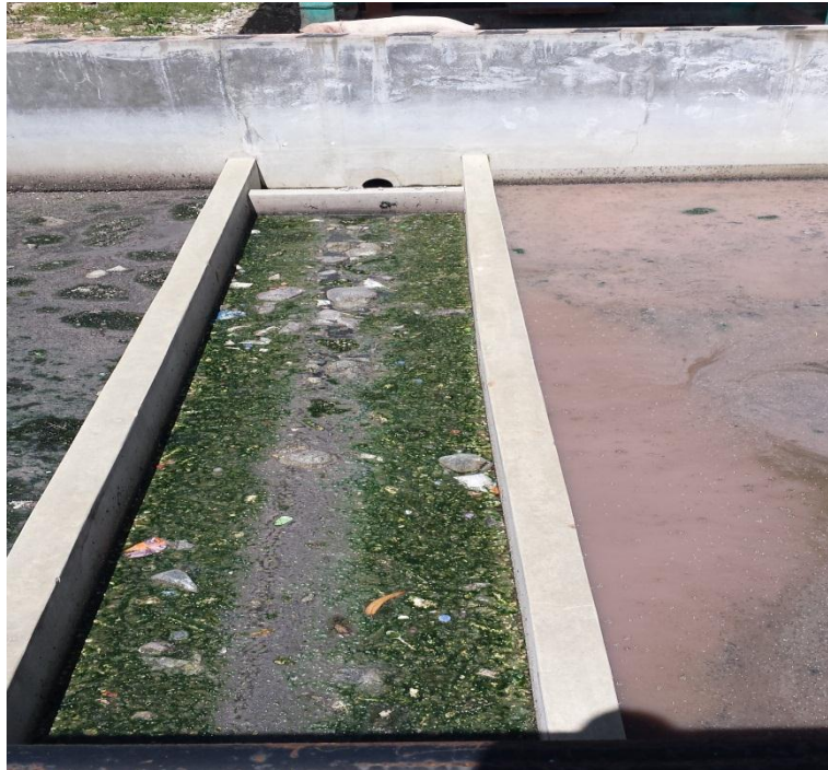
FOTOGRAFÍA N° 67: Área De Sedimentador
