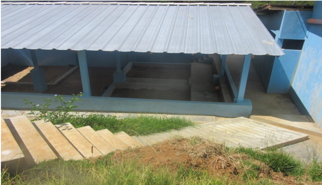
FOTOGRAFÍA N° 13: Techo de lecho de secado
