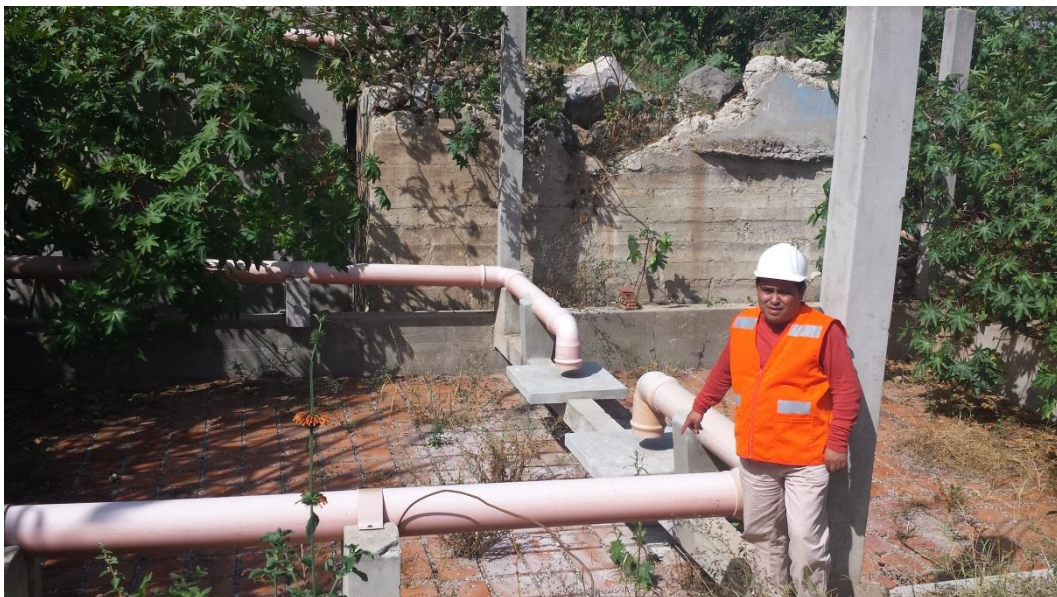
FOTOGRAFÍA N° 52: Área De lecho de Secado
