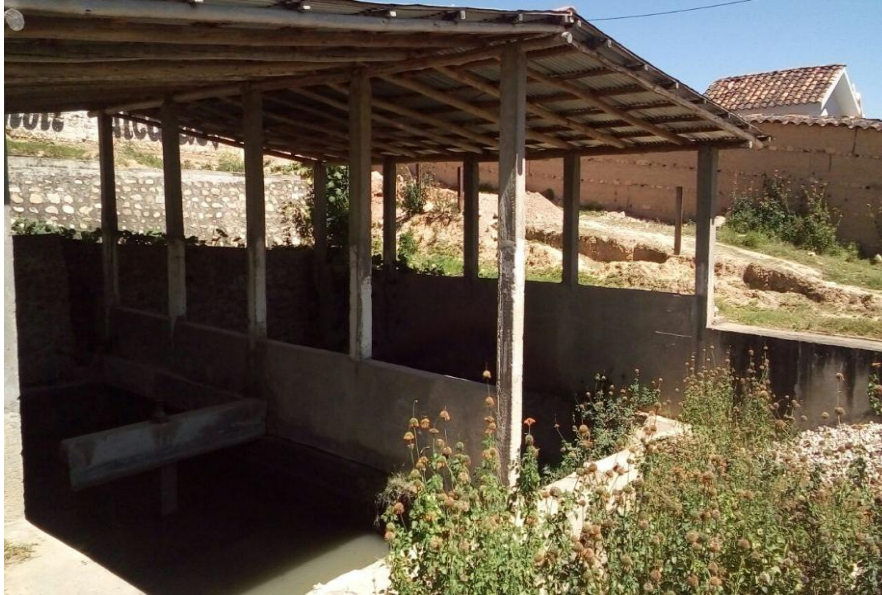
FOTOGRAFÍA N° 3: Infraestructura de tanque Imhoff
