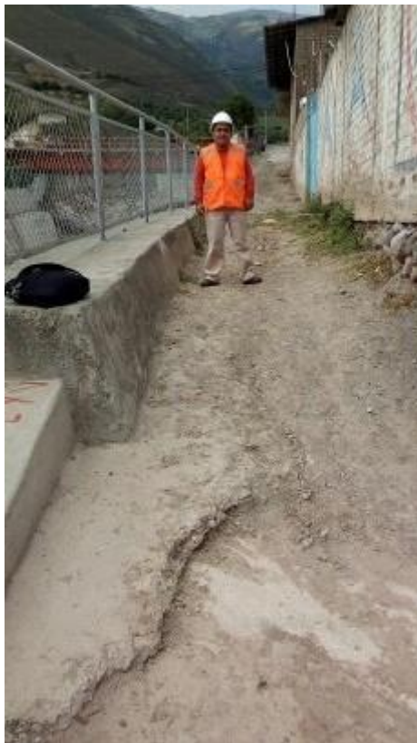
FOTOGRAFÍA N° 42: Orientación Al Tanque Imhoff
