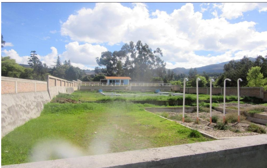
FOTOGRAFÍA N° 27: Infraestructura de tanque Imhoff
