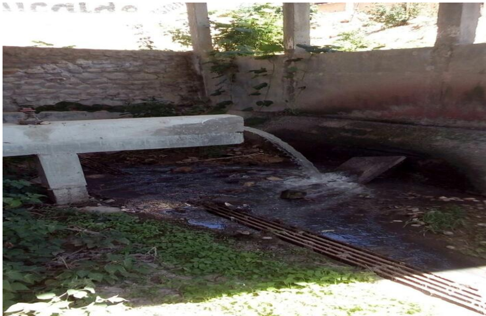
FOTOGRAFÍA N° 6: Drenaje de aguas residuales
