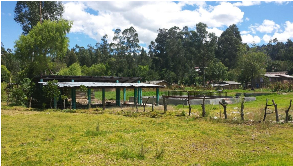
FOTOGRAFÍA N° 64: Accesibilidad Del Tanque Imhoff
