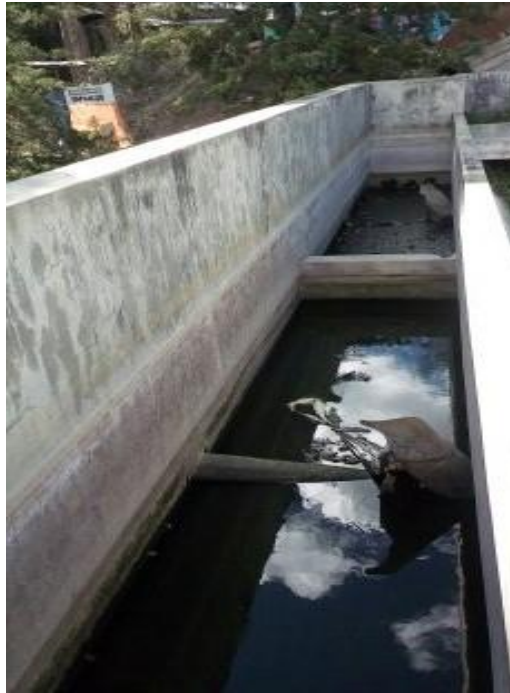
FOTOGRAFÍA N° 37: cámara de digestión
