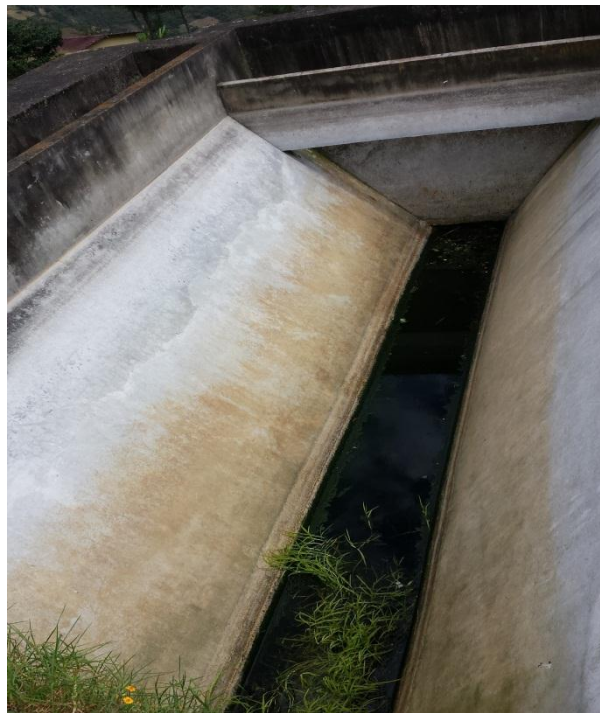
FOTOGRAFÍA N° 58: Estructura De Sedimentador
