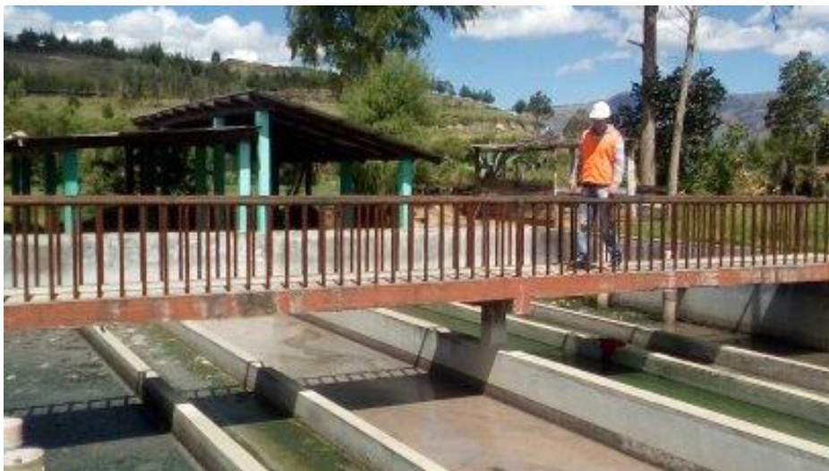
FOTOGRAFÍA N° 66: Evaluación De Infraestructura
