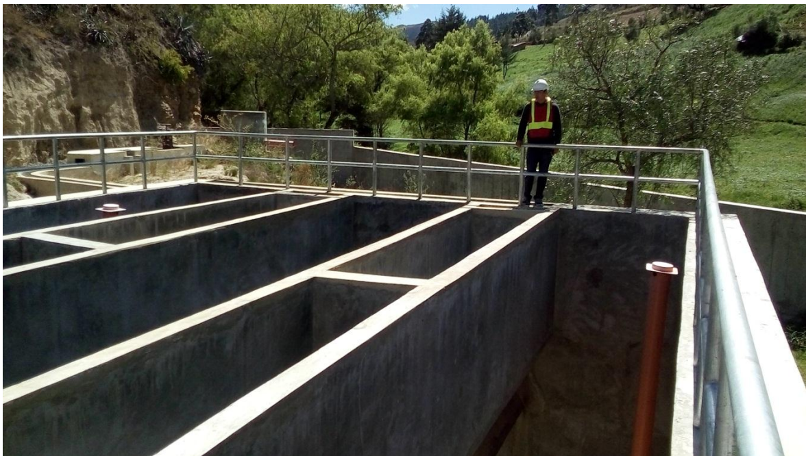
FOTOGRAFÍA N° 78: sedimentadores
