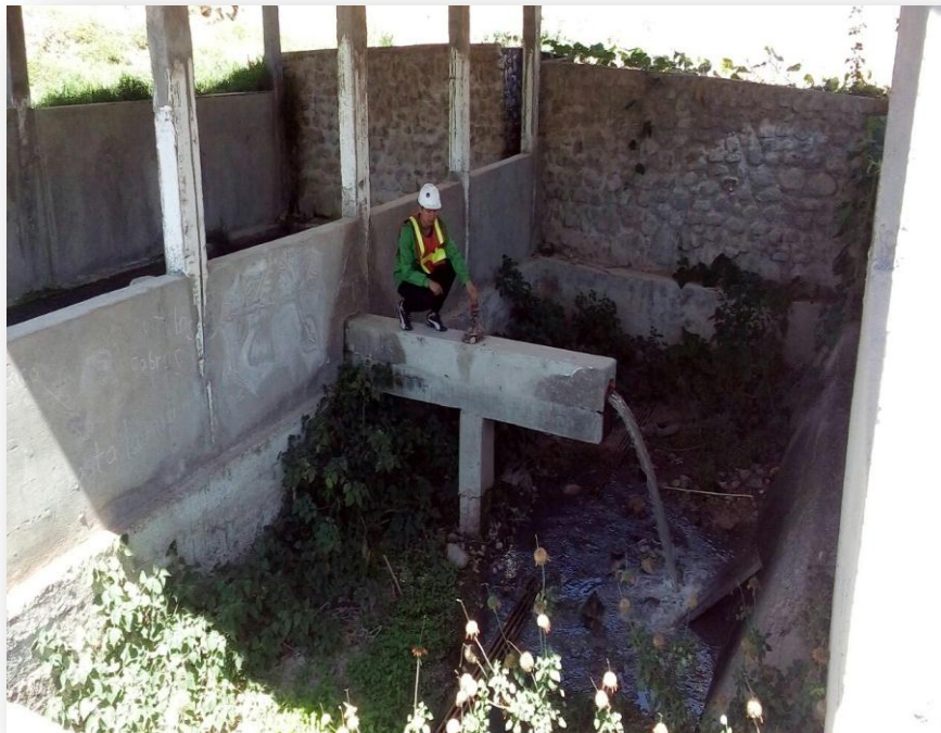
FOTOGRAFÍA N° 4: Evaluación de tanque Imhoff
