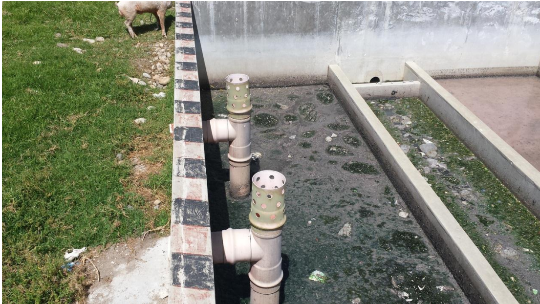
FOTOGRAFÍA N° 69: Cámara De Digestión
