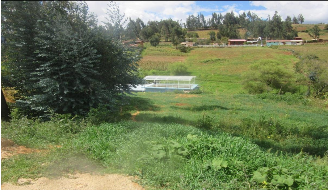
FOTOGRAFÍA N° 11: Accesibilidad a tanque Imhoff
