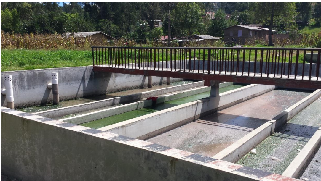
FOTOGRAFÍA N° 70: Infraestructura De Tanque Imhoff
