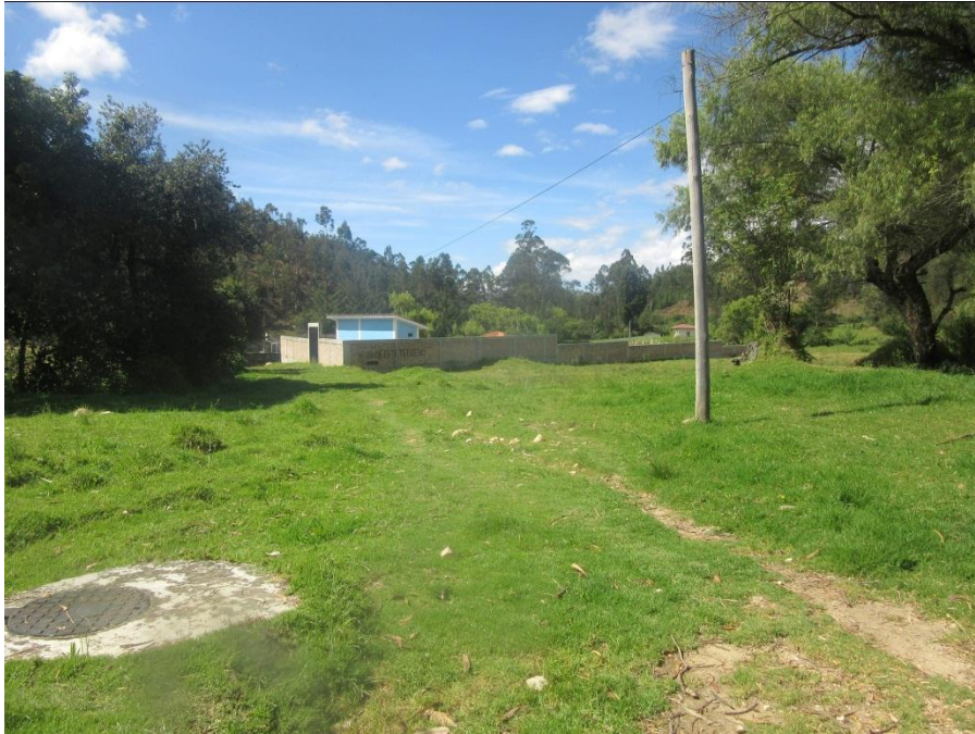
FOTOGRAFÍA N° 26: Accesibilidad al tanque Imhoff
