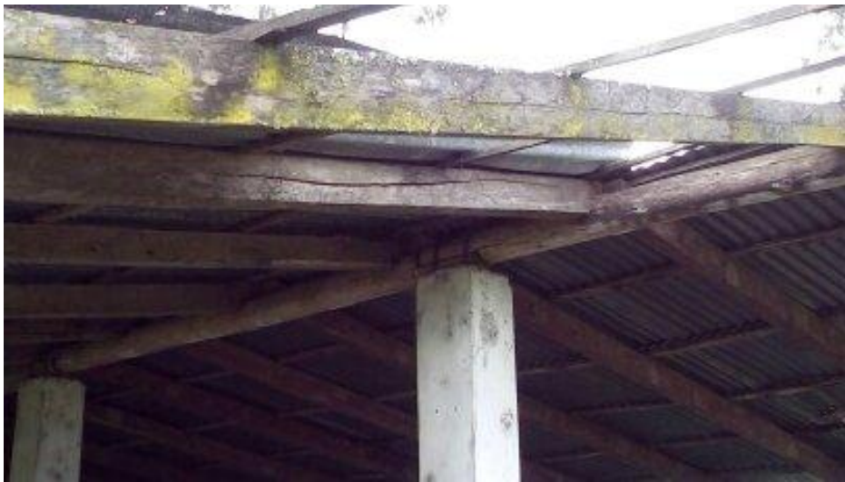
FOTOGRAFÍA N° 62: Estructura Techo De Área De Secado
