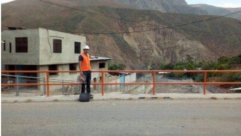
FOTOGRAFÍA N° 41: Orientación Al Tanque Imhoff
