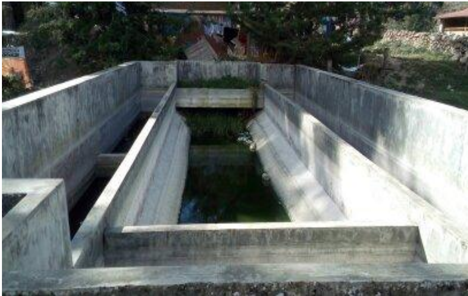
FOTOGRAFÍA N° 34: Evaluación del tanque Imhoff
