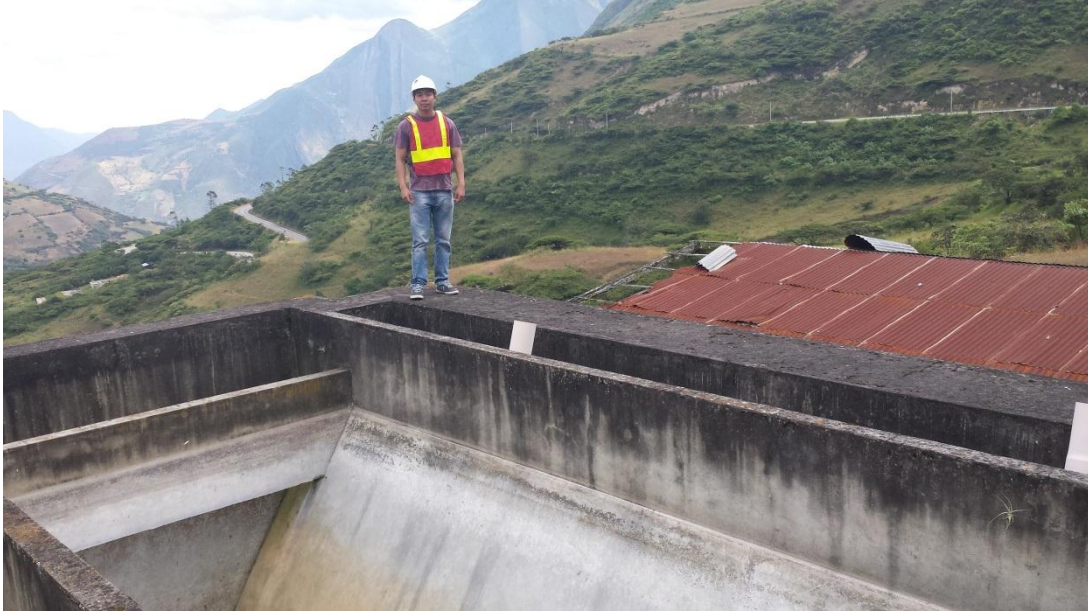
FOTOGRAFÍA N° 57: Evaluación De Tanque Imhoff
