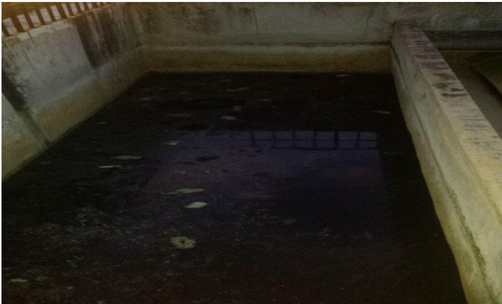
FOTOGRAFÍA N° 20: Área de sedimentador
