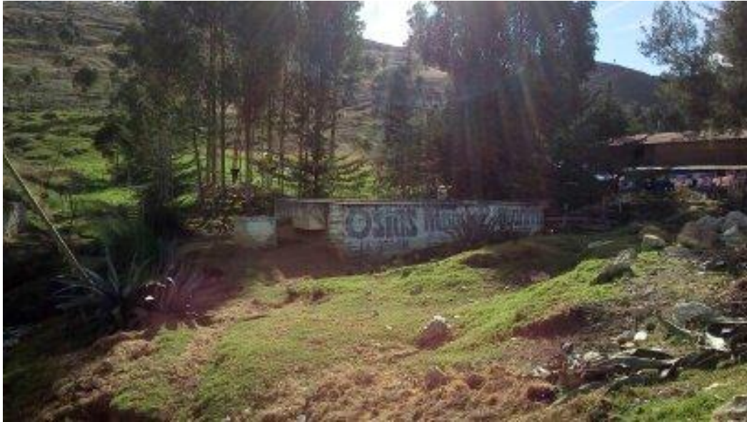
FOTOGRAFÍA N° 33: Accesibilidad del tanque Imhoff
