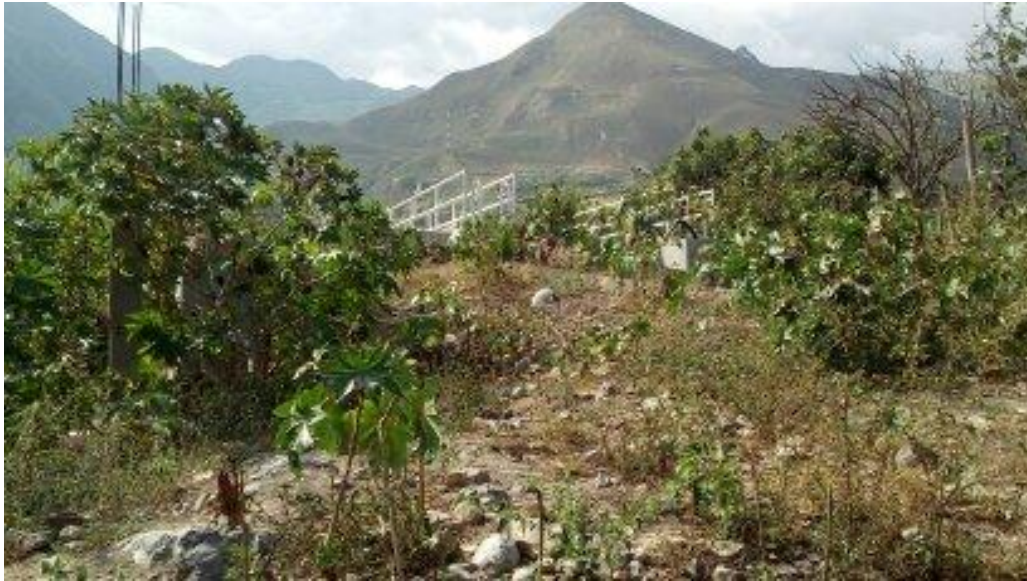
FOTOGRAFÍA N° 43: Accesibilidad del Tanque Imhoff
