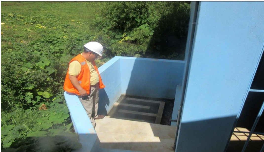
FOTOGRAFÍA N° 14: Evaluación de tanque Imhoff
