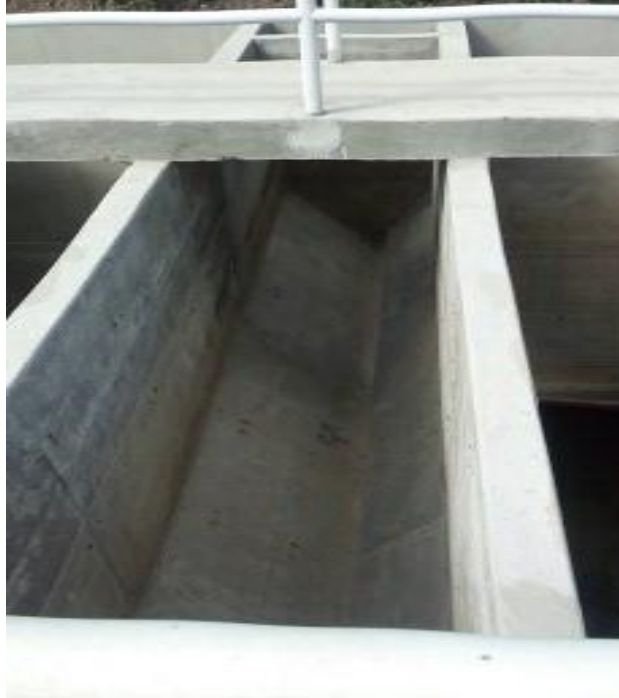
FOTOGRAFÍA N° 47: Estructura De Sedimentador
