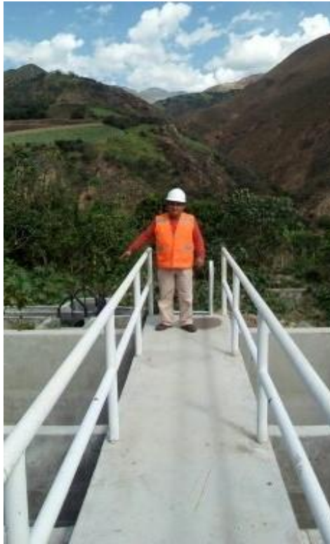
FOTOGRAFÍA N° 45: Evaluación Del Tanque Imhoff
