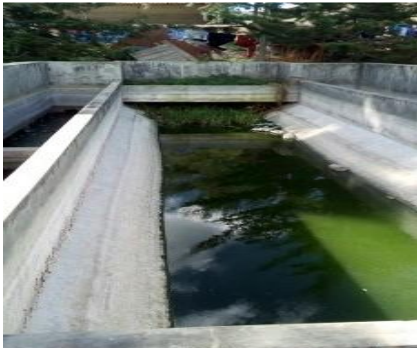
FOTOGRAFÍA N° 38: Área de sedimentador
