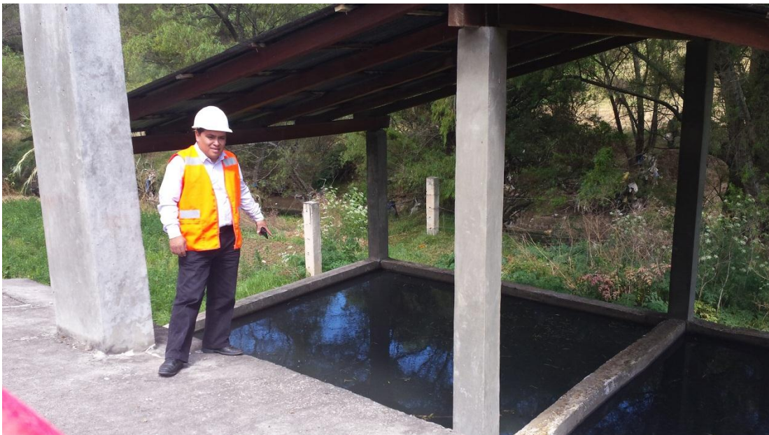
FOTOGRAFÍA N° 82: evaluando el tanque Imhoff
