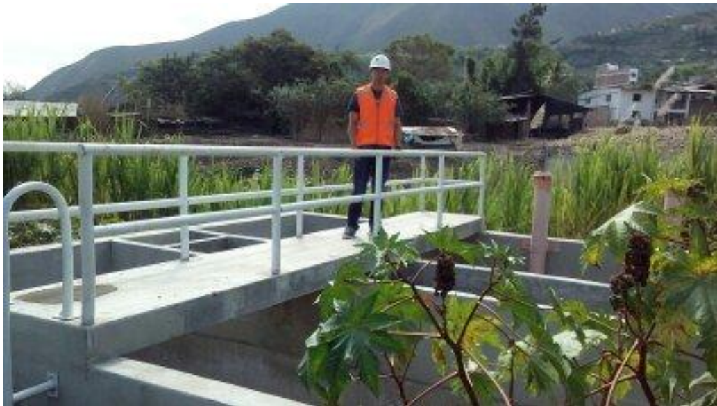
FOTOGRAFÍA N° 44: Evaluación Del Tanque Imhoff
