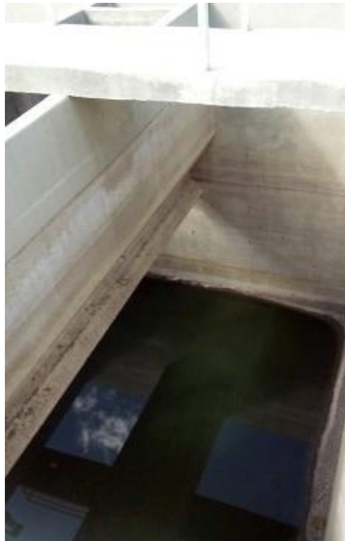
FOTOGRAFÍA N° 54: cámara de digestión
