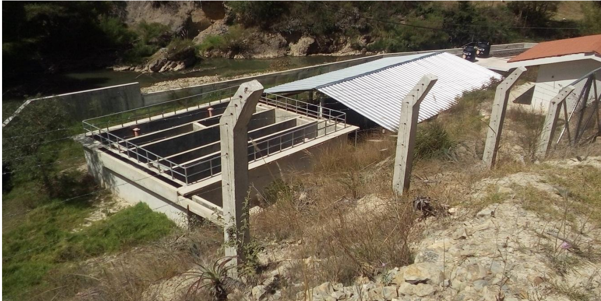
FOTOGRAFÍA N° 75: infraestructura del tanque Imhoff
