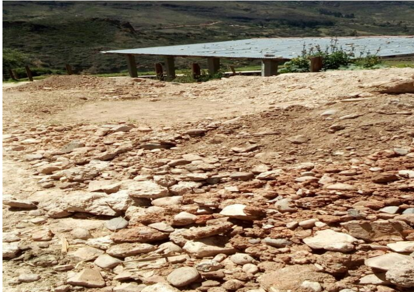
FOTOGRAFÍA N° 1: accesibilidad al tanque Imhoff
