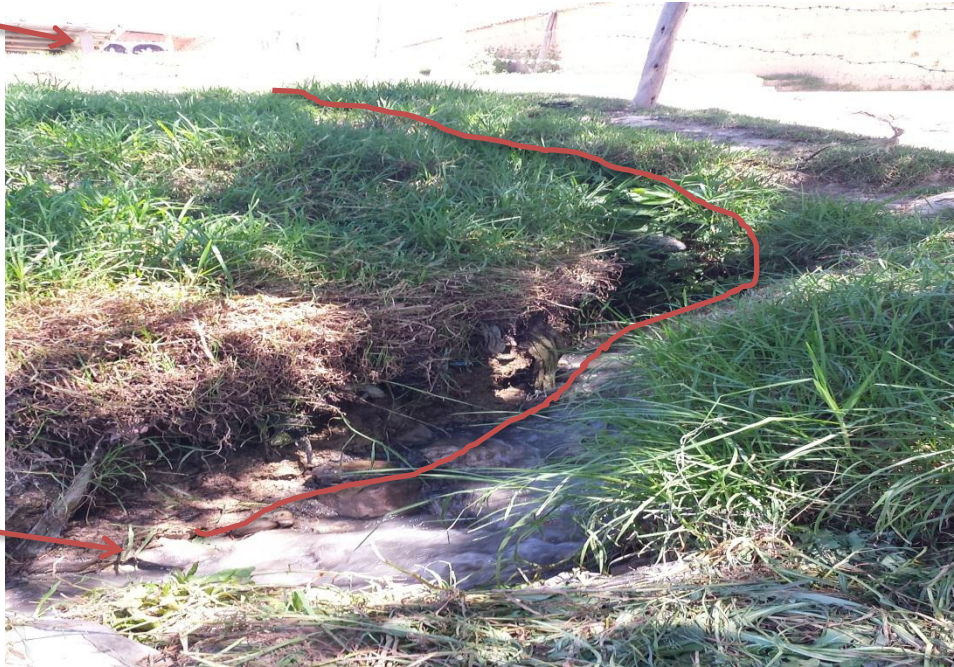
FOTOGRAFÍA N° 7: Salida de aguas residuales del tanque Imhoff
