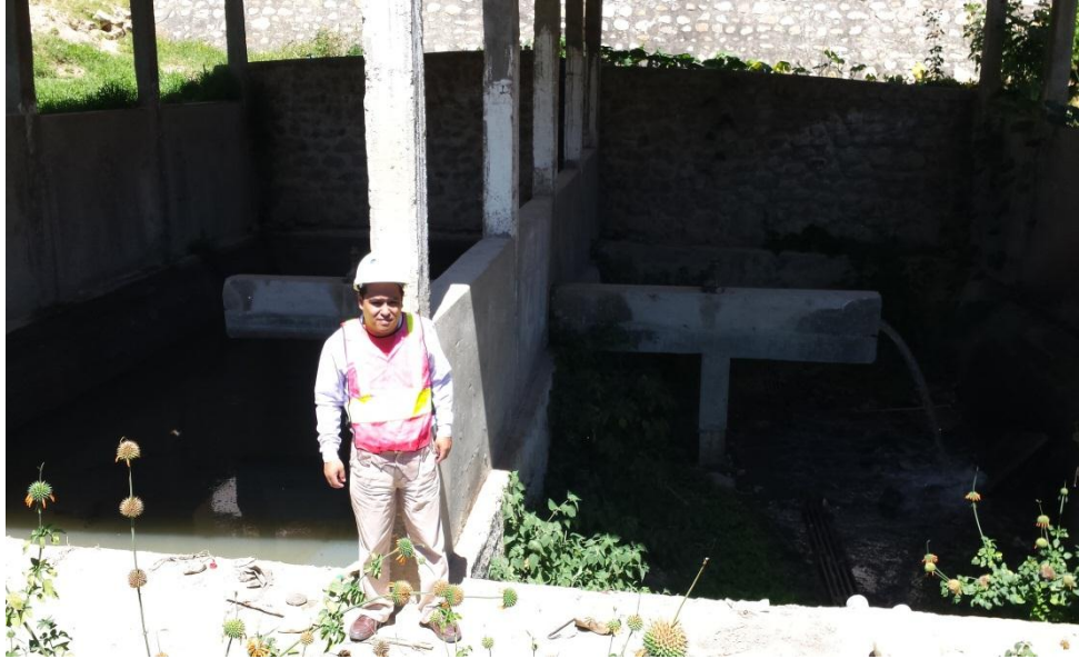
FOTOGRAFÍA N° 5: Evaluación de tanque Imhoff
