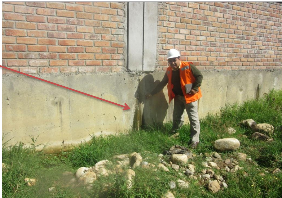
FOTOGRAFÍA N° 29: Falla por saturación de aguas residuales
