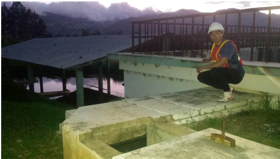
FOTOGRAFÍA N° 18: Evaluación del tanque Imhoff
