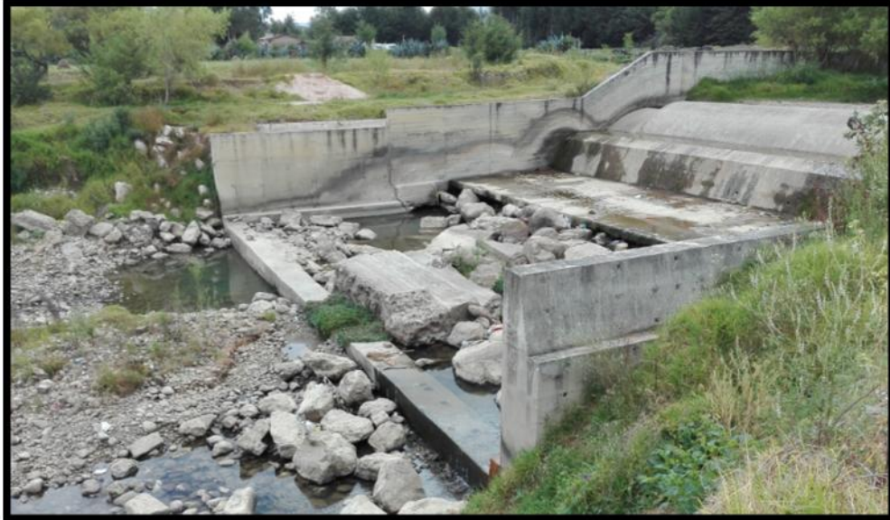
Fotografía 10. Séptimo vertedero visitado – Salto Sky
