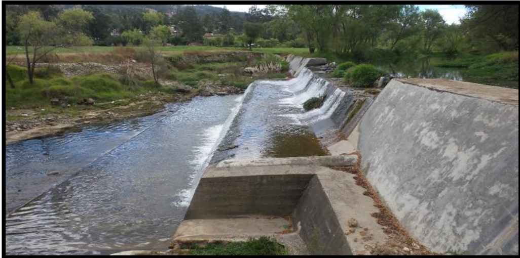
Fotografía 3. Segundo vertedero de perfil
