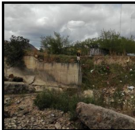
Fotografía 19. Orientación E1- V7- muro de encausamiento
