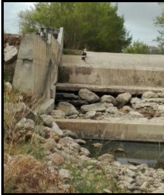
Fotografía 26. Puntos tomados para determinar la forma de la cresta del vertedero
