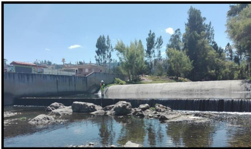
Fotografía 6. Tercer vertedero vista frontal
