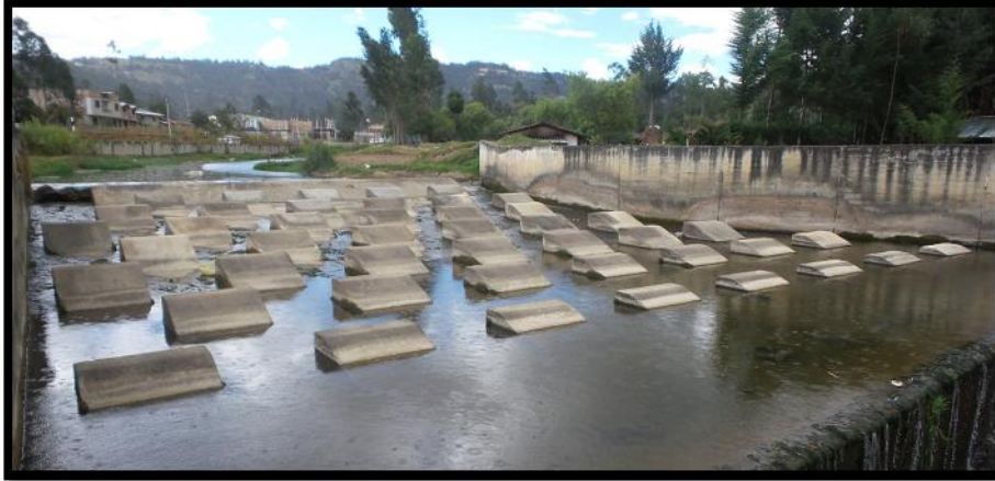
Fotografía 7. Cuarto vertedero visitado
