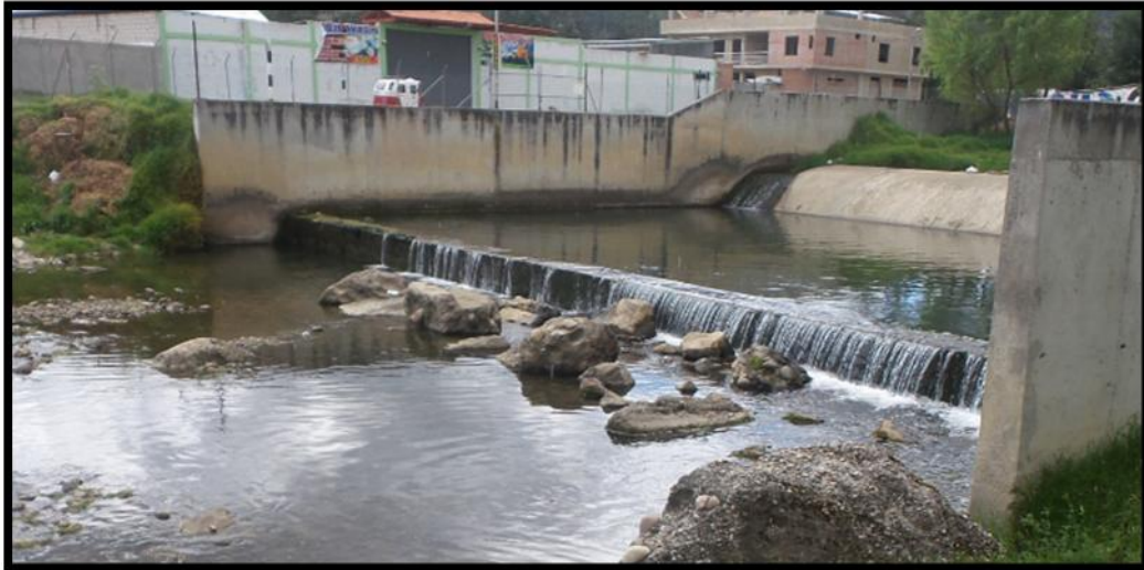
Fotografía 5. Tercer vertedero vista isométrica
