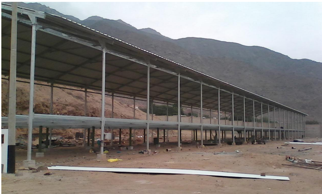
Figura N° 63: Construcción de nuevos galpones
