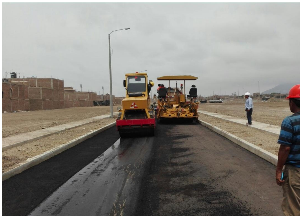
Figura No. 3: Instalación de Carpeta Asfáltica en la Obra: Habilitación urbana del ex Fundo el Prisma.
