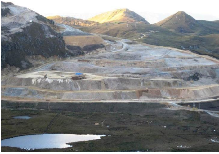
Depósito de Material Estéril
