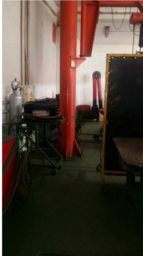
Figura n.º 40: Maquina soldadora y gases ordenados atrás de la grúa puente Fuente: Esco Peru S.R.L.
