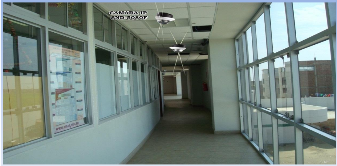
Figura N° 98: Pasadizo 2Piso Fuente:[CSJLL]
