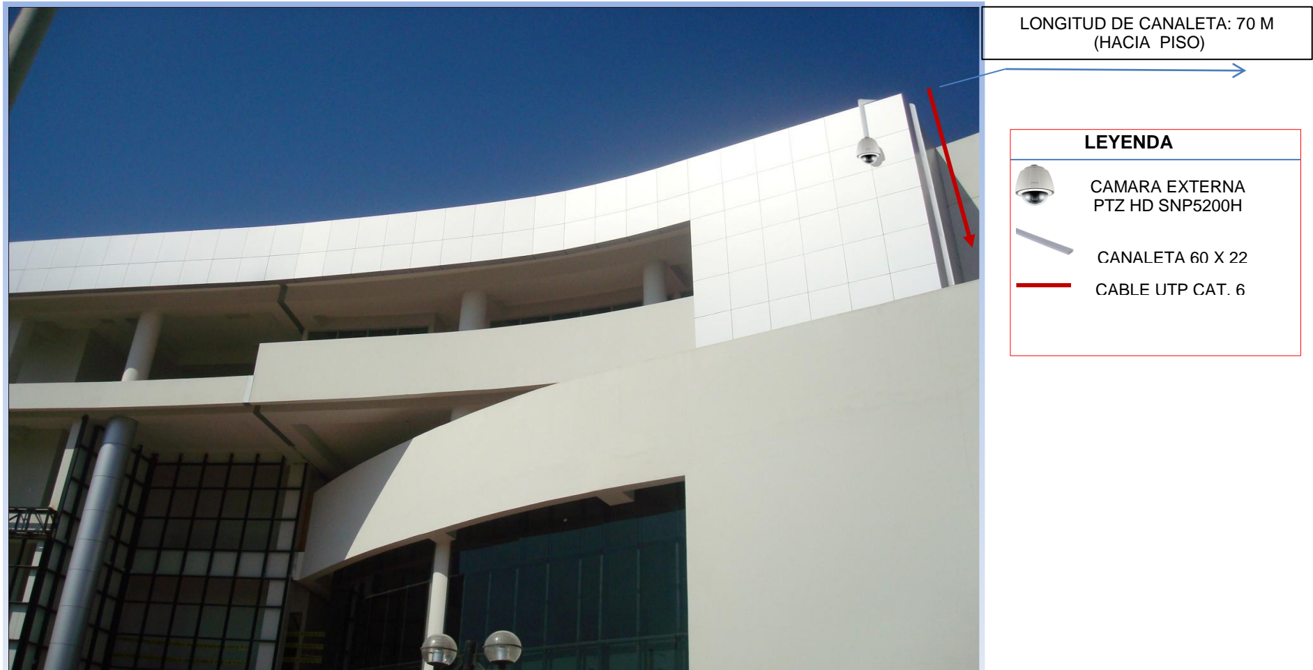
Figura N° 104: Cableado Cat. 6 de la Red Actual - Azotea Fuente: [Elaboración propia]
