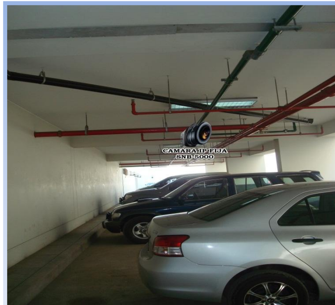
Figura N° 38: Bloque C - Sótano Fuente: [CSJLL]
