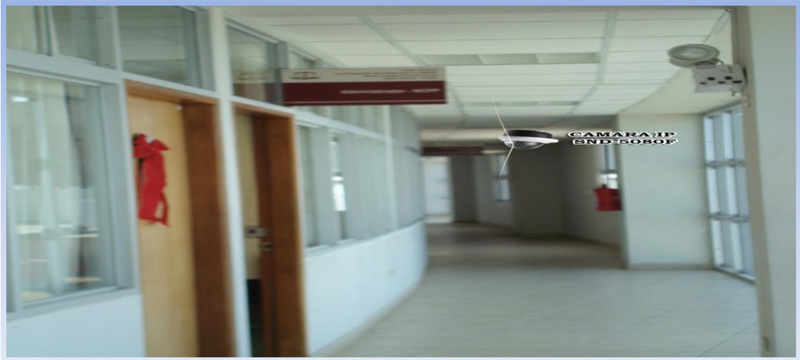
Figura N° 100: Pasadizos A - 3Piso Fuente: [CSJLL]
