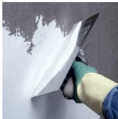
Figura N° 8: Uso de yeso grueso en revestimiento de muros.
