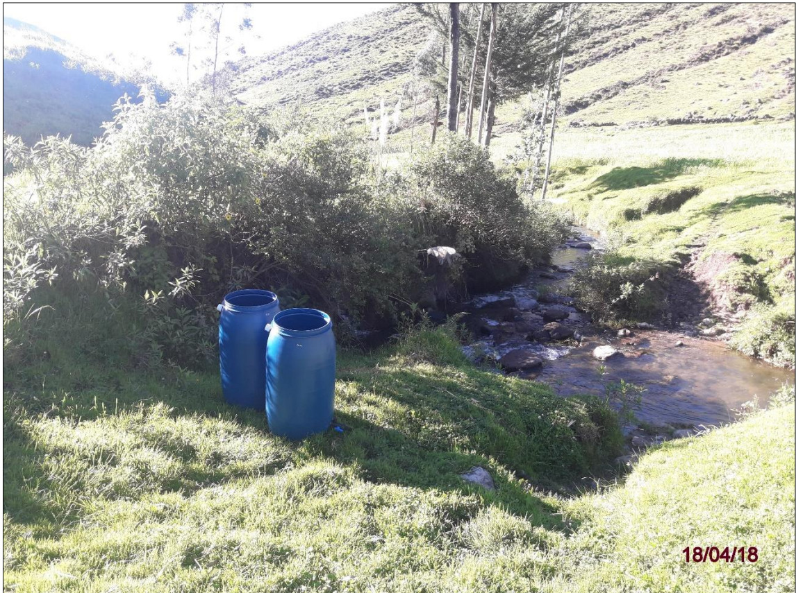
Fotografía N° 1: Ubicación de Filtro Río Cumbe – Caserío Tomacucho
