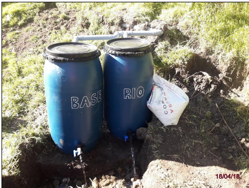
Fotografía N° 30: Filtros Terminados filtrando agua del río cumbe
