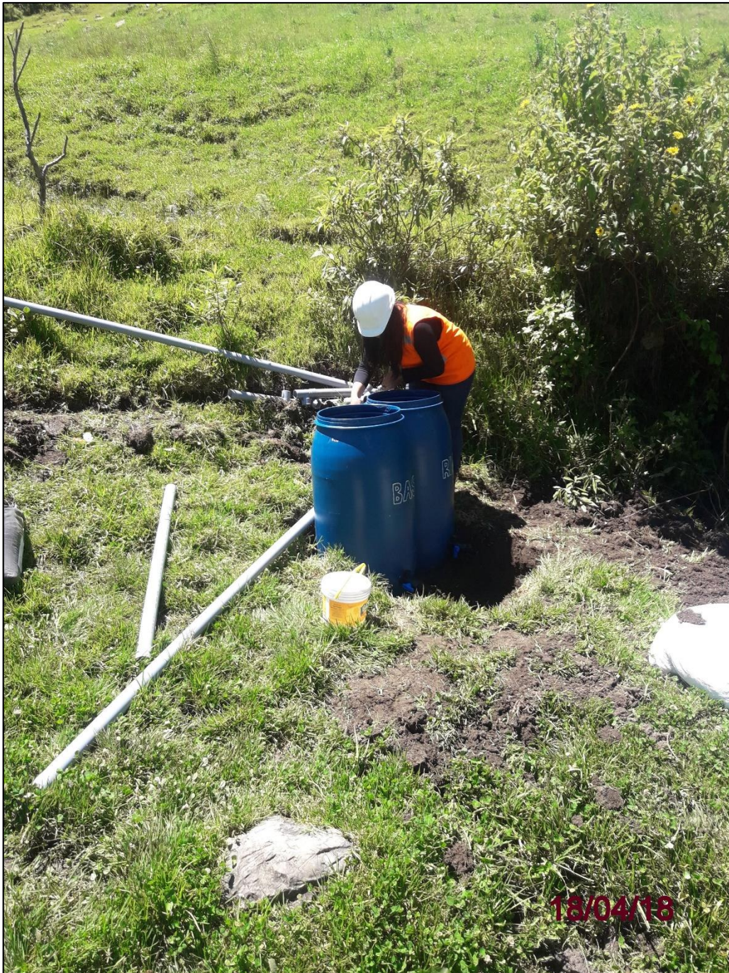
Fotografía N° 10: Ensamblado de entrada de Filtro
