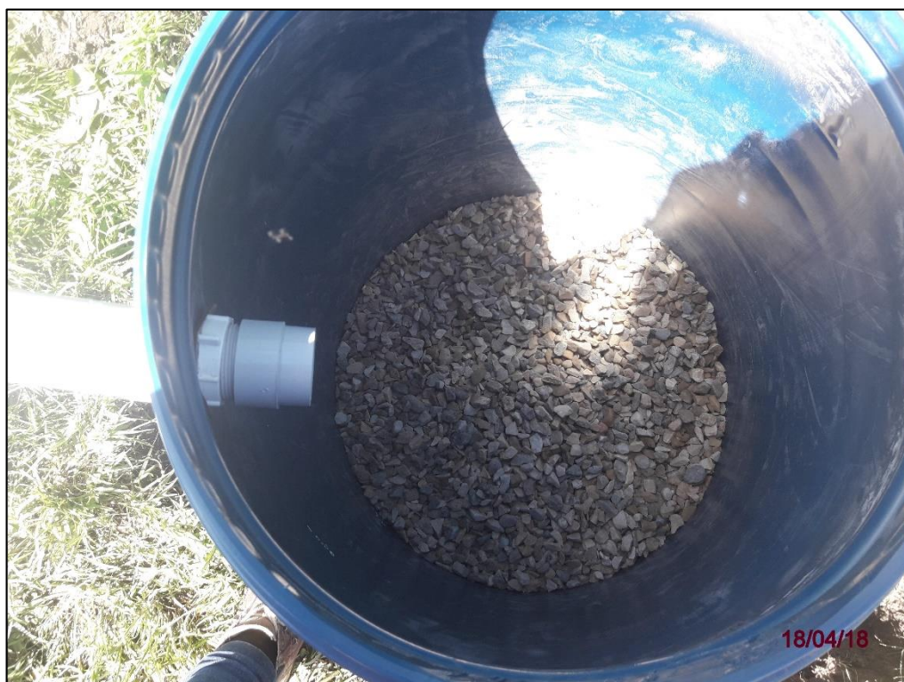
Fotografía N° 16: Colocación segunda capa Filtro A-Base - Gravilla
