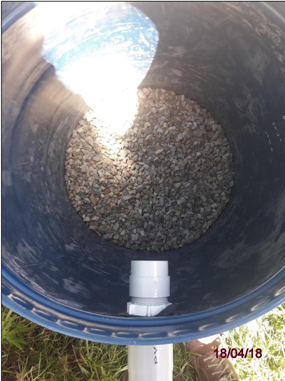
Fotografía N° 17: Colocación segunda capa Filtro B-Río - Gravilla
