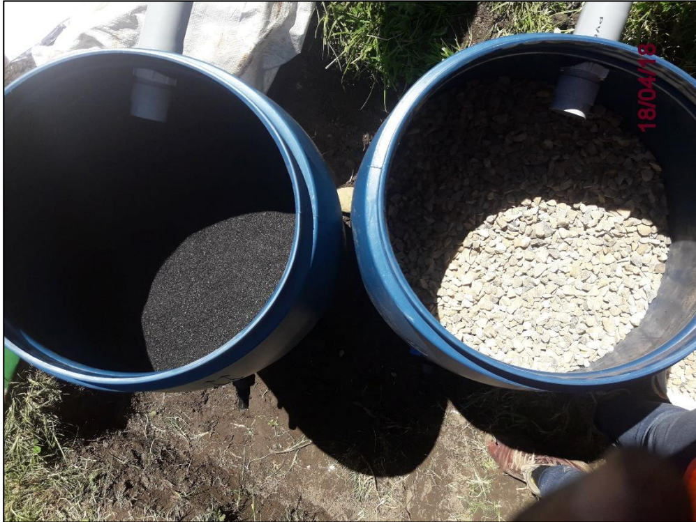
Fotografía N° 22: Filtro A (Capa de carbón activado) - Filtro B (Gravilla)
