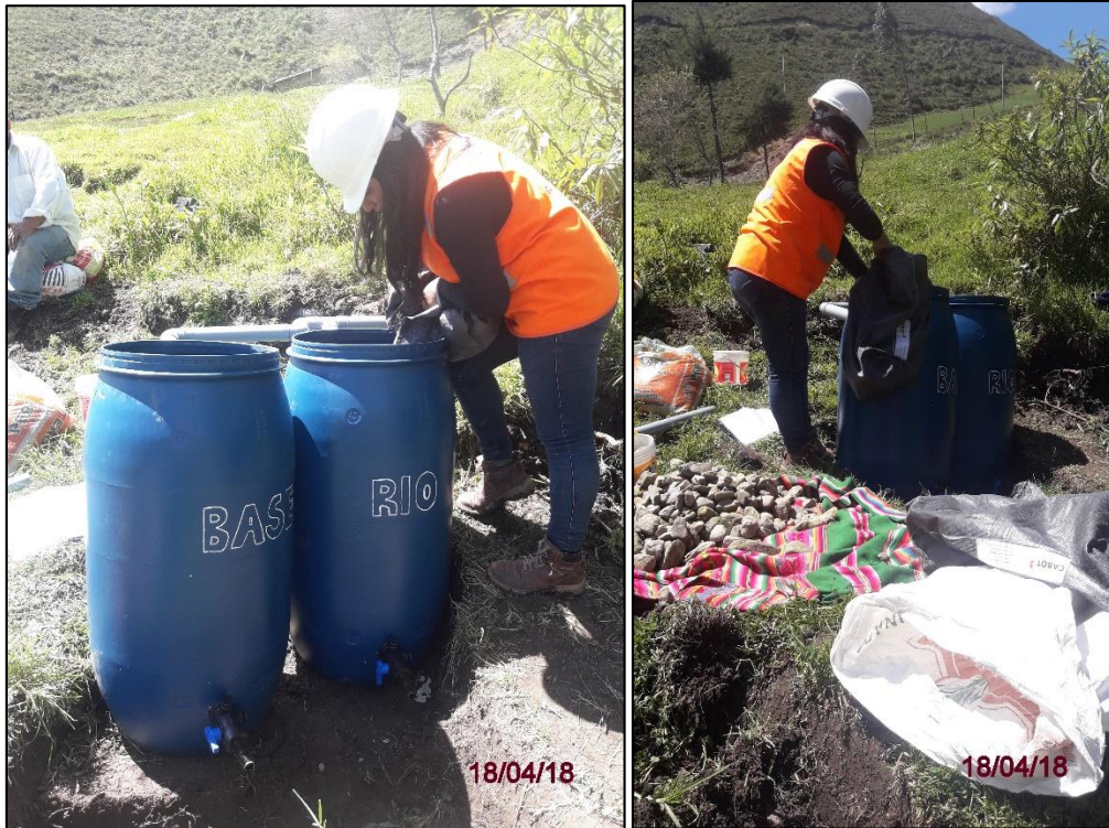
Fotografía N° 18: Colocacion de Carbón Activado a Filtro A
