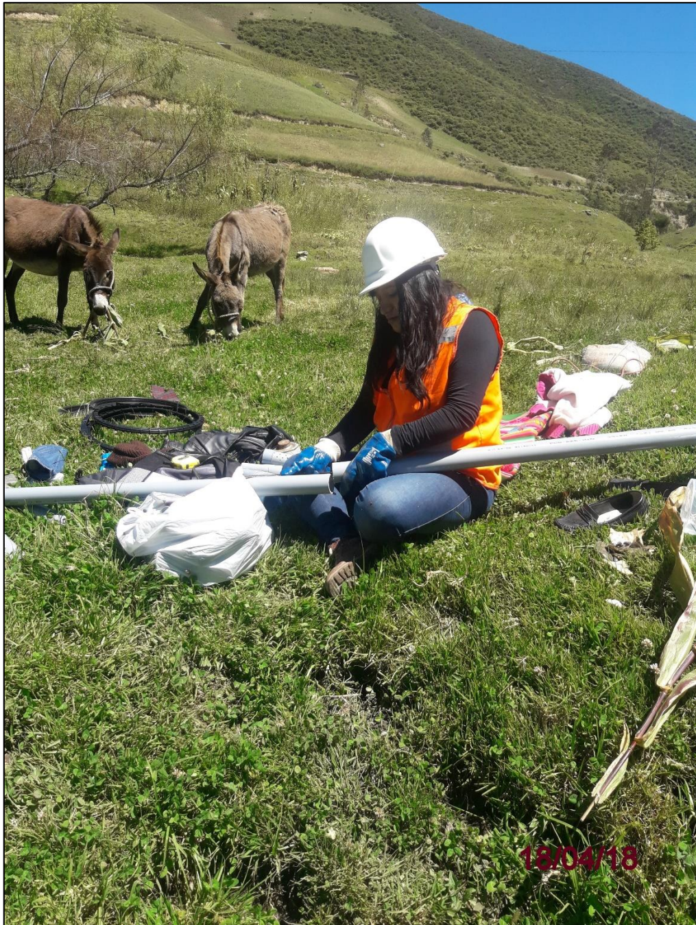
Fotografía N° 8: Ensamblado de Tubería
