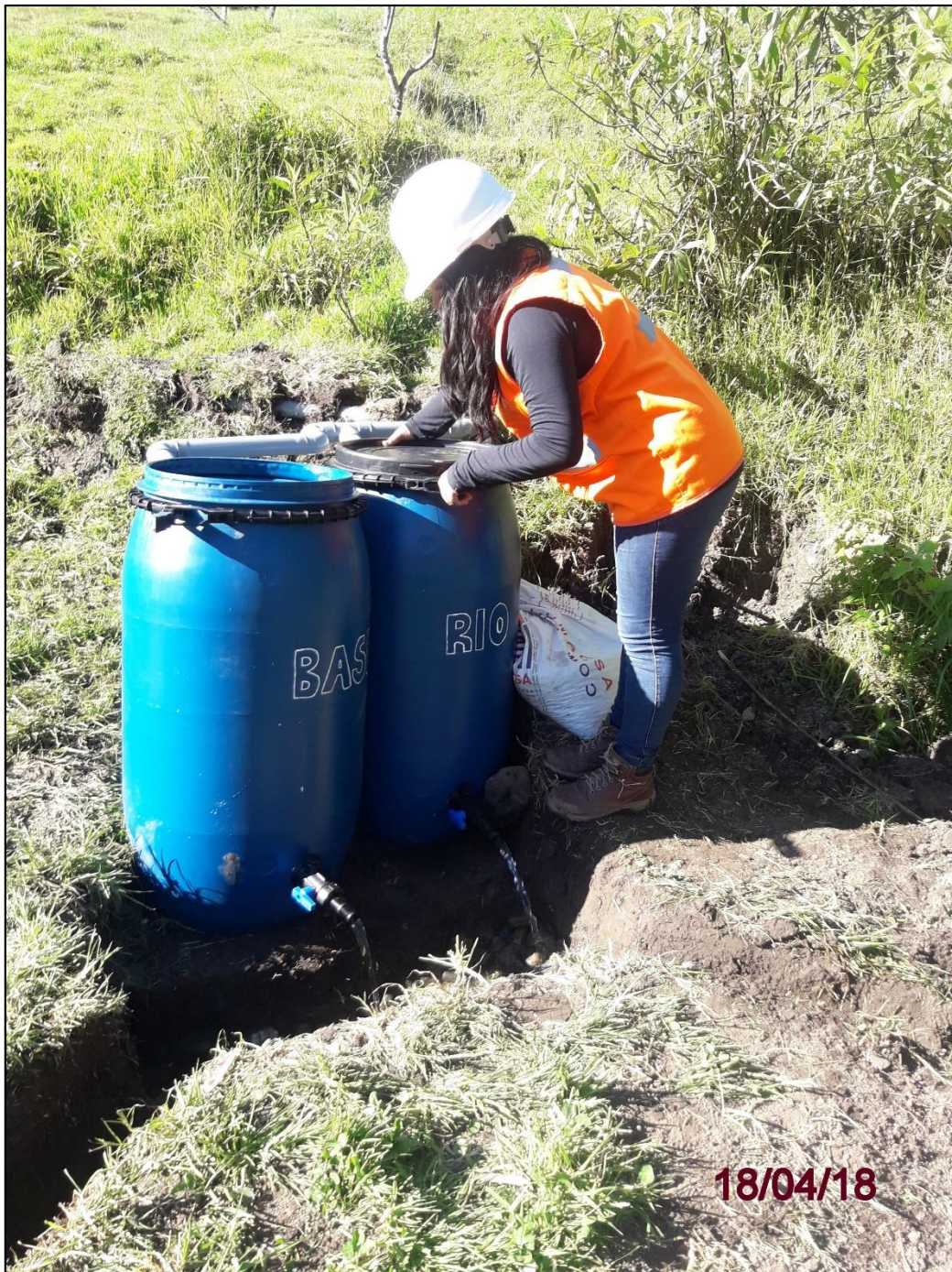
Fotografía N° 28: Sellado de Filtros
