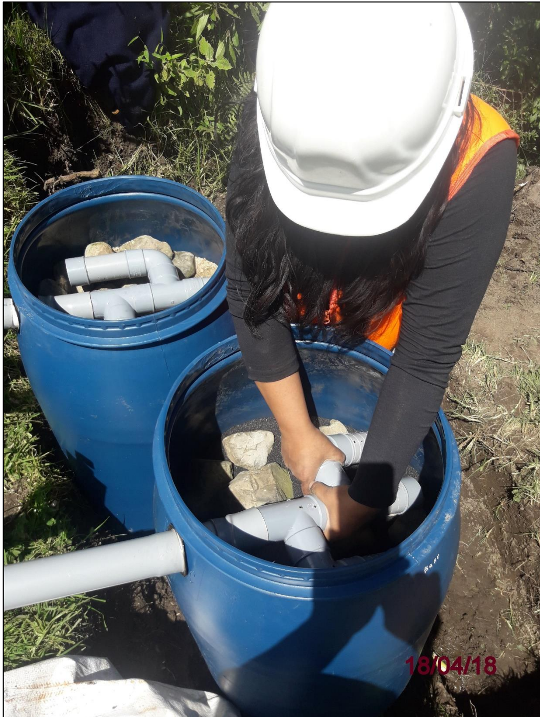
Fotografía N° 24: Colocación de piedra grande y tubería agujereada para caída de agua
