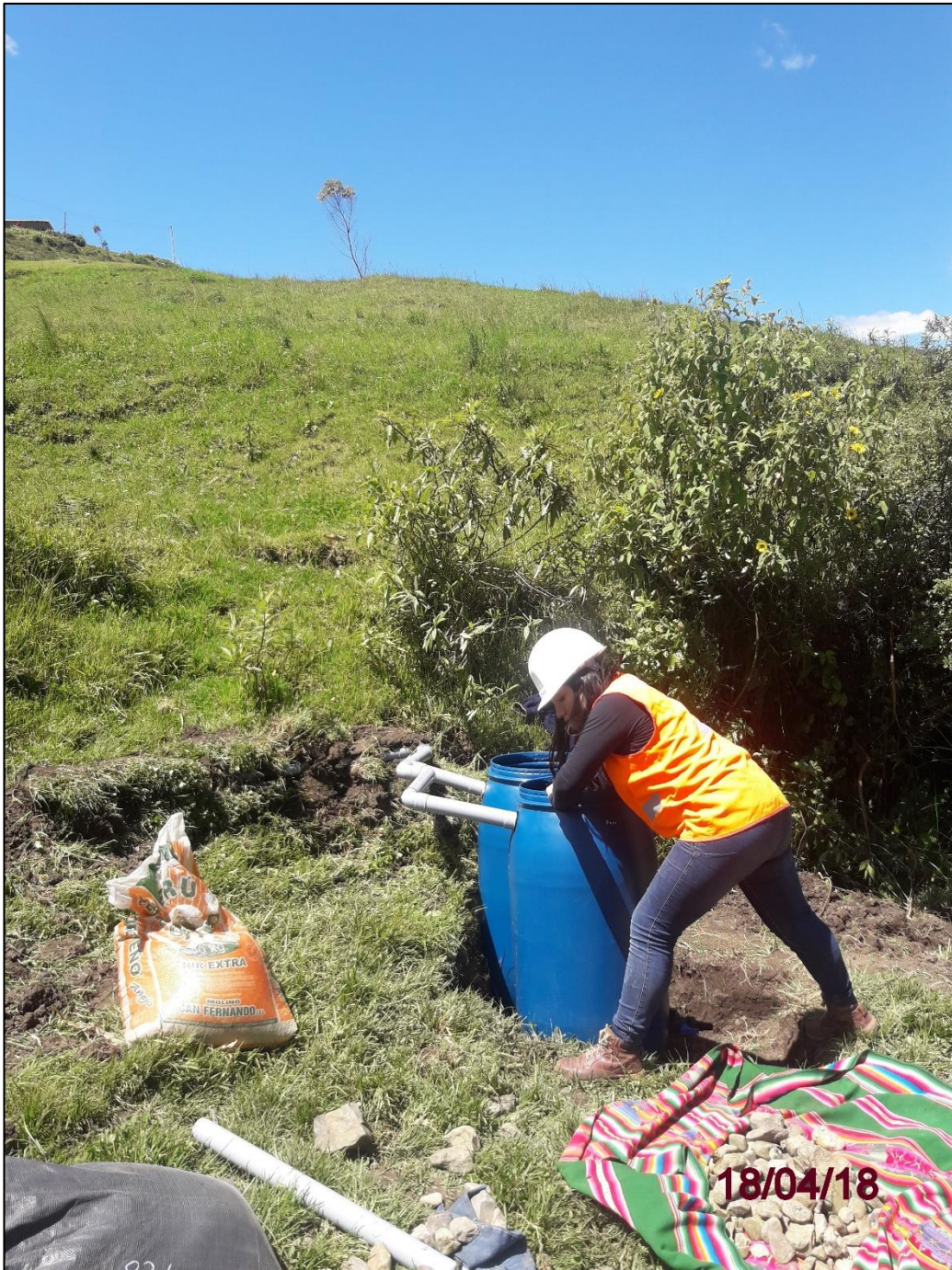
Fotografía N° 14: Colocación de Tubería agujereada para salida de agua
