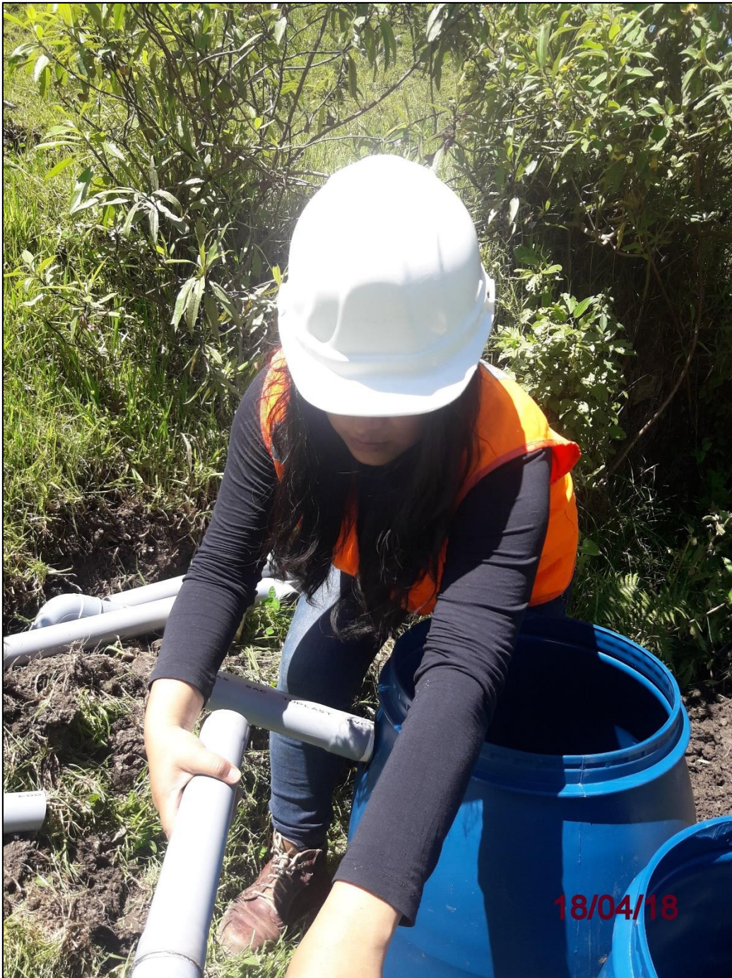
Fotografía N° 12: Ensamblado de tubería para alimentación de Filtros
