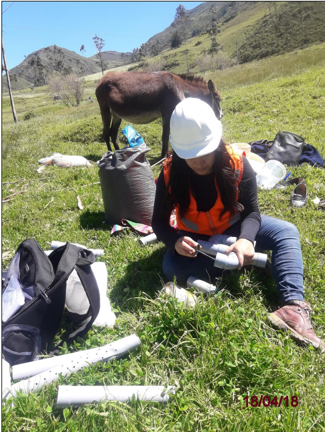
Fotografía N° 6: Ensamblado de tubería agujereada para caída de agua filtros
