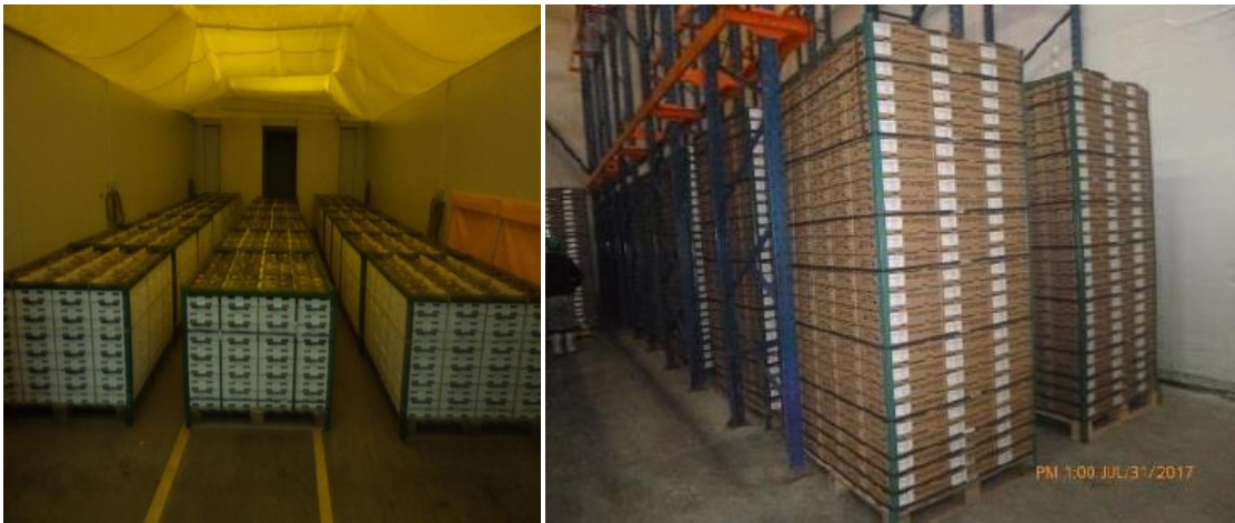
Figura 31. Fotografías del túnel de enfriamiento y del almacén del enfriado de los productos final Fuente: Área de sistema de gestión de la calidad de Camposol S.A.
