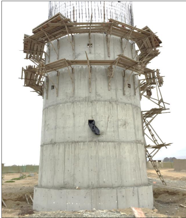
Figura 21: Reservorio de agua potable en el AA.HH Brisas del Mar - Huanchaco
