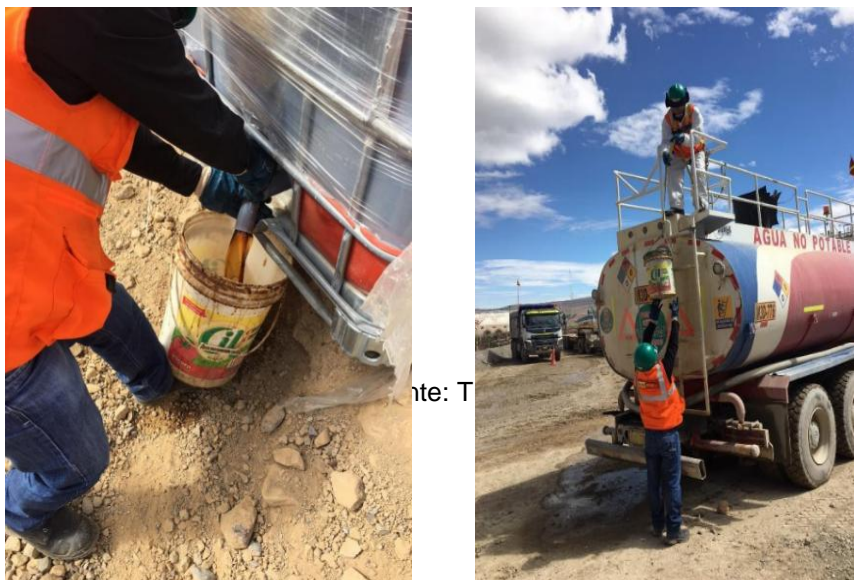
Figura n.º 3. 14. Aplicación de knockout dustply.
