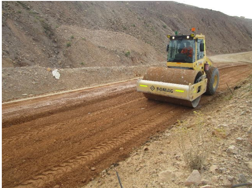
Figura n.º 3. 17. Compactación.
