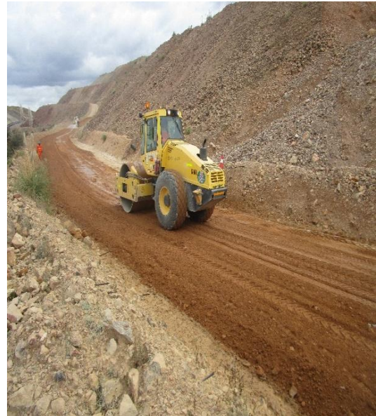
Figura n.º 4. 20. Mezclado y compactado.
