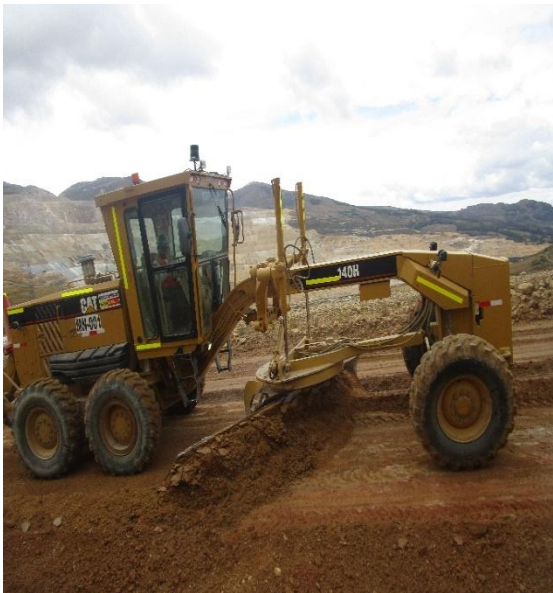
Figura n.º 4. 20. Mezclado y compactado.
