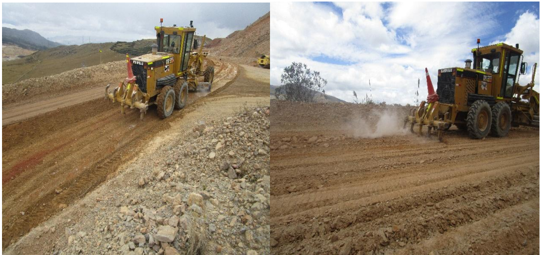
Figura n.º 4. 18. Escarificación de la vía con motoniveladora.
