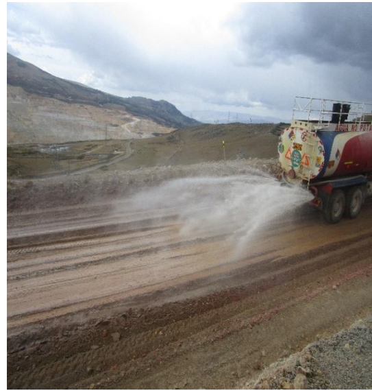
Figura n.º 4. 20. Mezclado y compactado.
