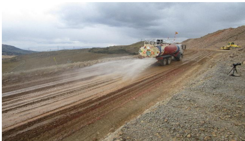
Figura n.º 3. 16. Riegos de la solución (knockout dustply – agua).
