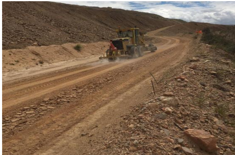
Figura n.º 3. 15. Escarificado y perfilado.
