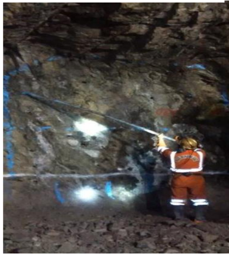
Fotografía 1: Pintado de la malla de perforación
