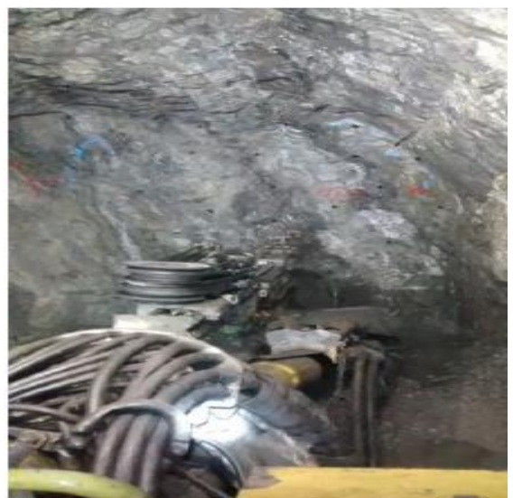
Fotografía 3: Perforando taladros rectos y evitando desviaciones, con ayuda del pintado de malla. Labor Zapatito (M684)
