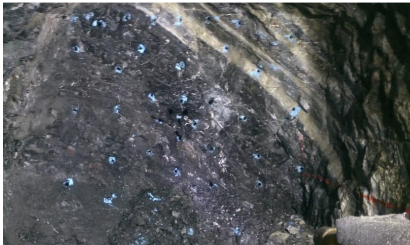
Fotografía 4: Taladros perforados con adecuados espaciamientos y burden. Labor K 1060
