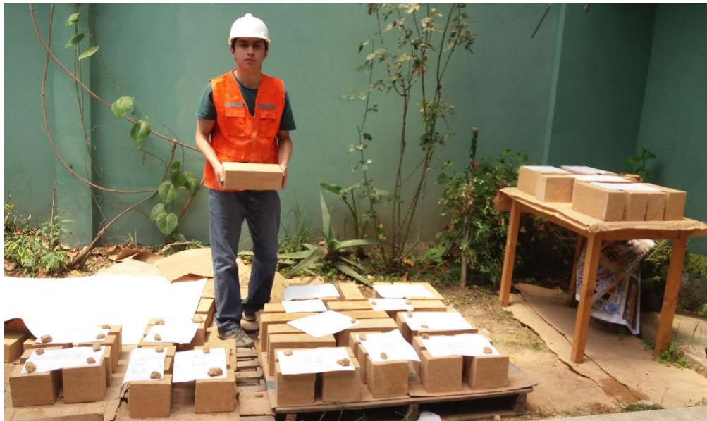
Figura 22: Acopio de adobes compactados
