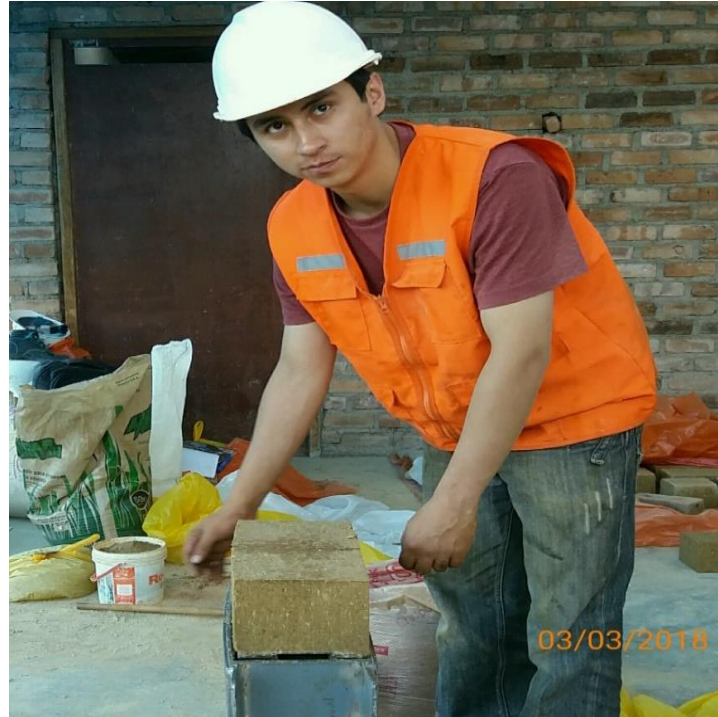
Figura 21: Fabricación de adobes compactados
