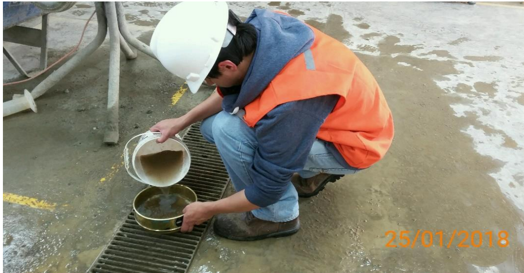
Figura 7: Realizando ensayo granulometría por lavado
