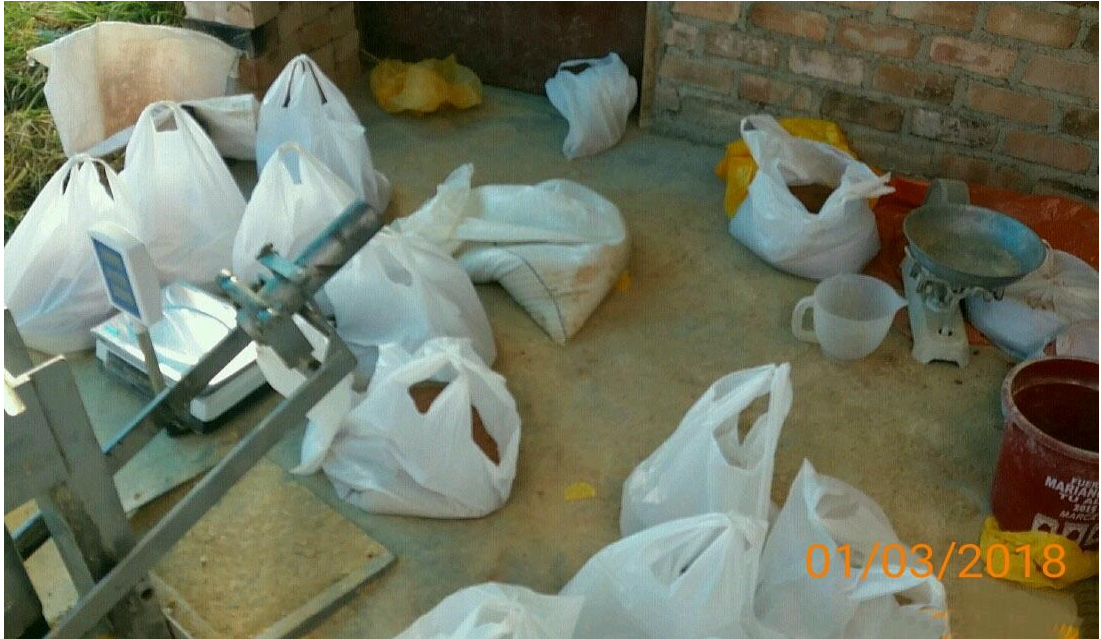
Figura 59: Preparación de mezclas para fabricación de cada adobe compactado
