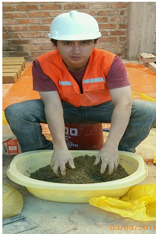
Figura 58: Realizando mezcla de tierra y cerámica triturada para la fabricación de adobes compactados
