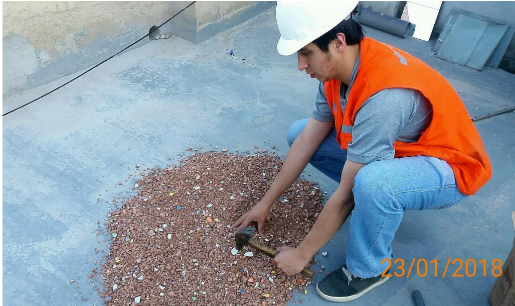
Figura 6: Proceso manual de trituración de cerámica
