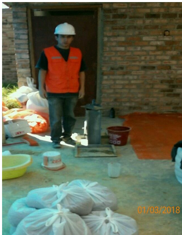
Figura 60: Mezclas de material para fabricación de adobes compactados dejadas en bolsas
