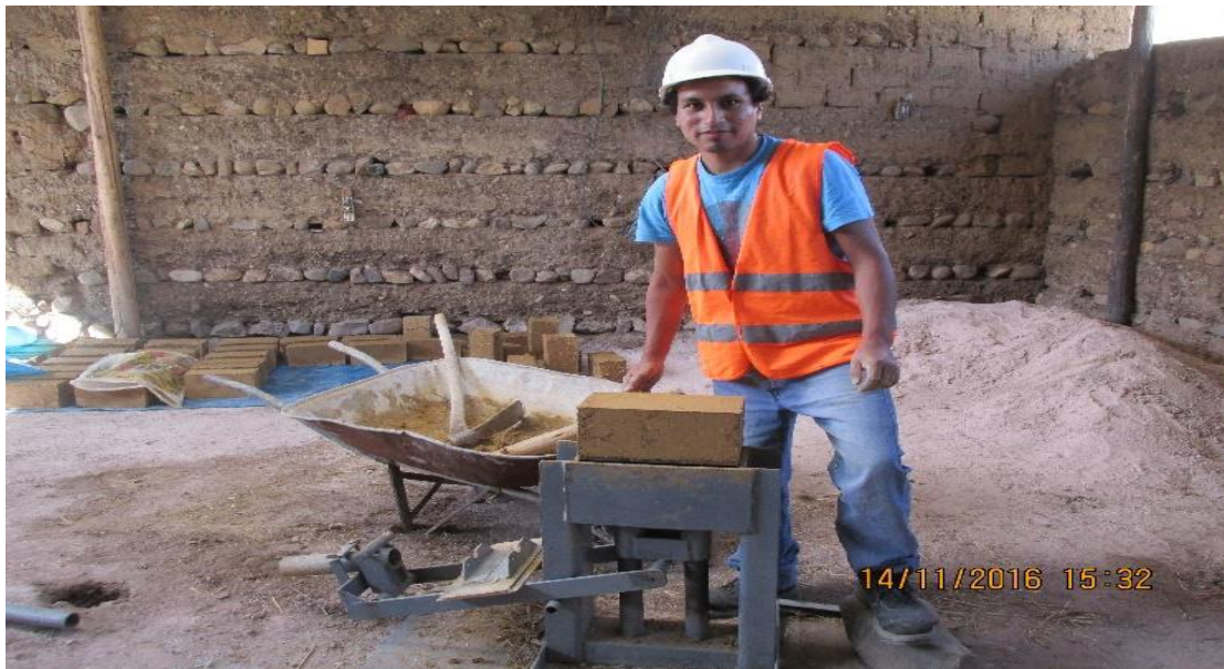
Fotografía N° 26: Extracción del adobe de la maquina CIVA RAM.
