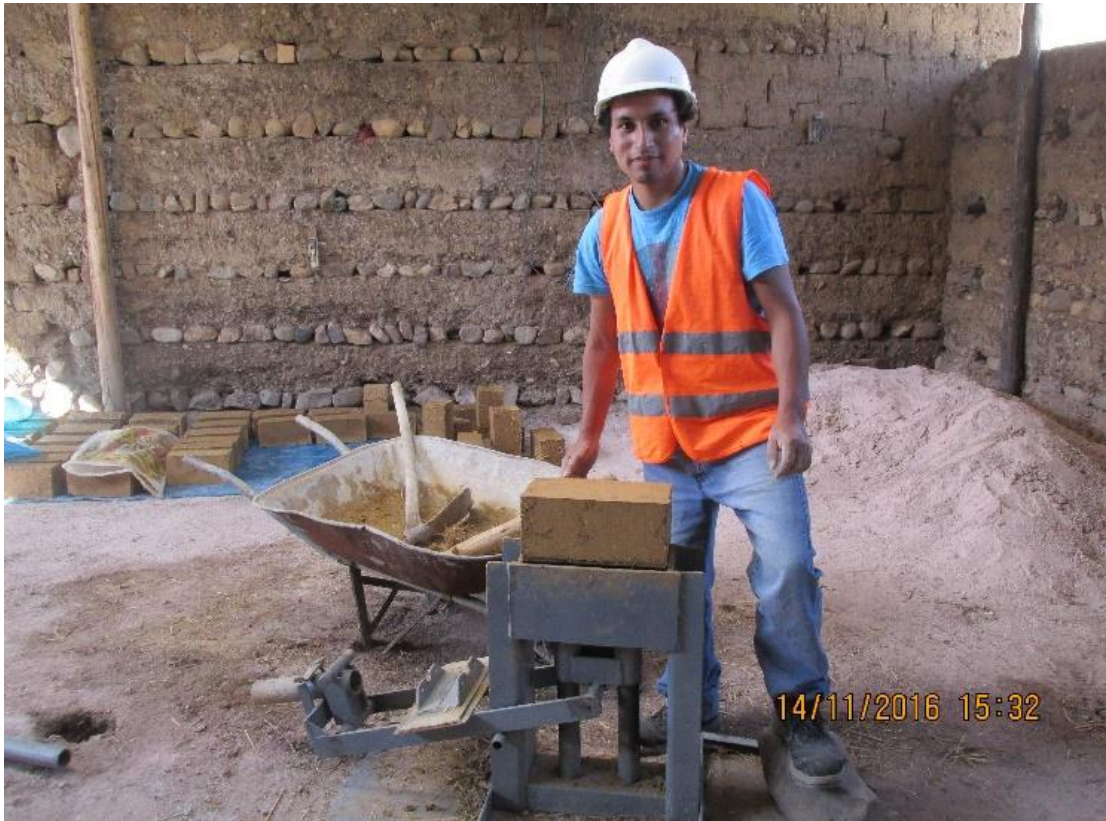
Fotografía N° 38: Elaboración de los adobes con los diferentes tipos de fibras.
