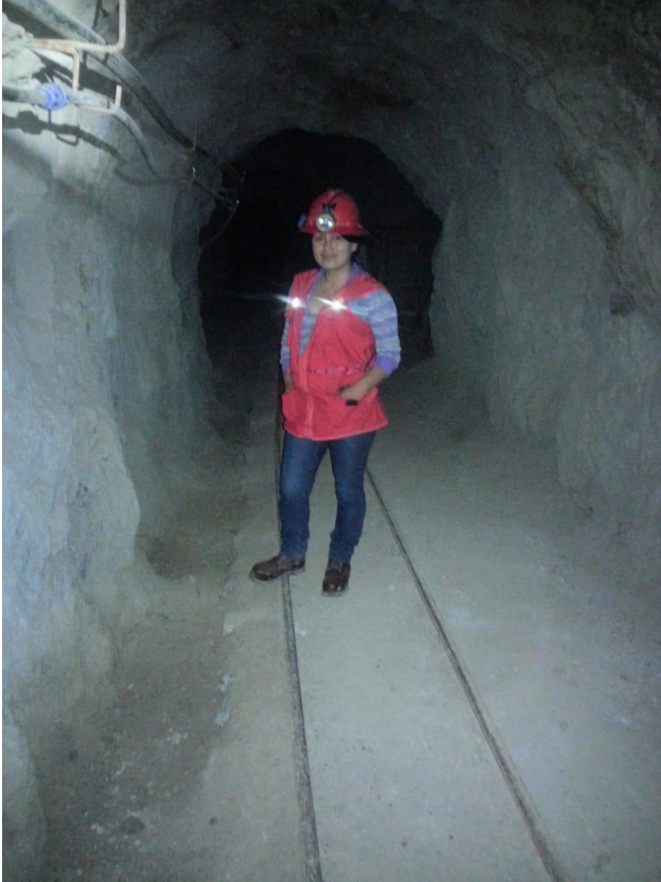
Anexo N° 06 Sección de Galería Nv. 2000, punto donde se va a realizar el pique
