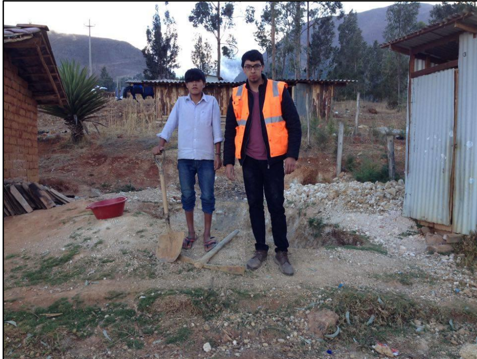
Fotografía N° 1. Extracción del material en el caserío Aylambo Bajo - distrito de Cajamarca
