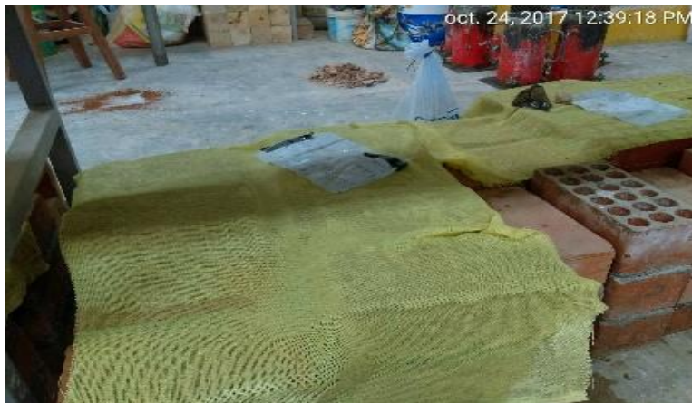
Figura 33. Curado por 28 días a pilas de ladrillos
