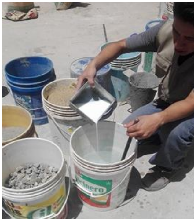
Ilustración 57: Mezcla de Aditivo para el Concreto
