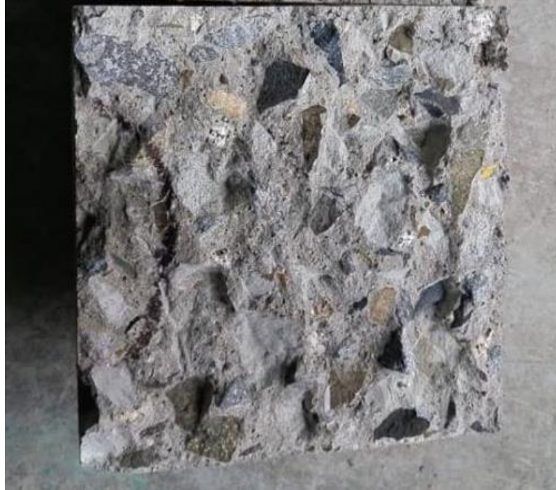
Ilustración 91: Penetración de agua en el Concreto con 3% de Aditivo Sika 1 Líquido
