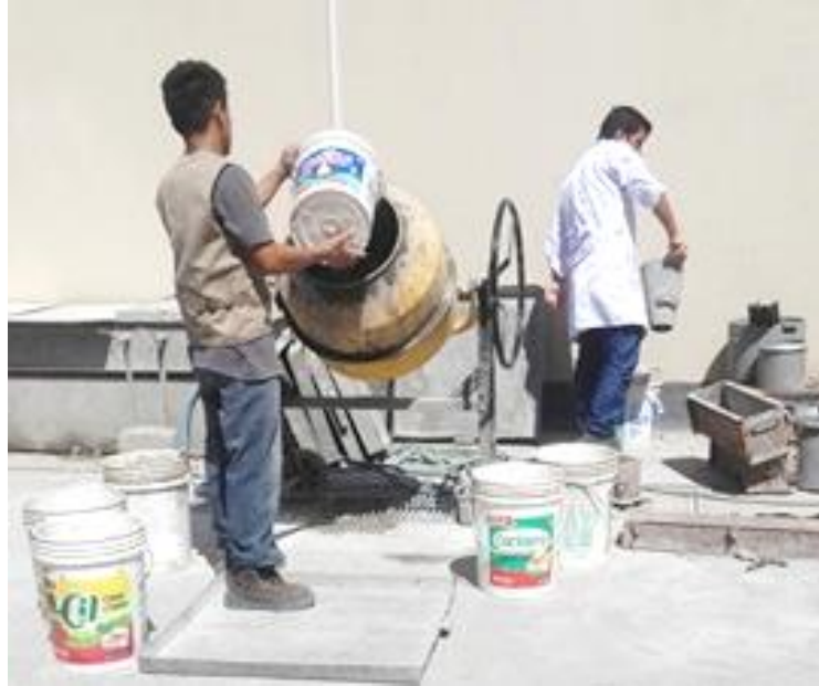
Ilustración 58: Preparación del Concreto
