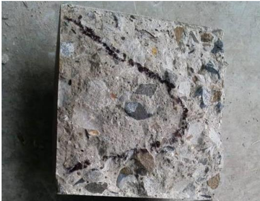
Ilustración 88: Penetración de agua en el Concreto Patrón
