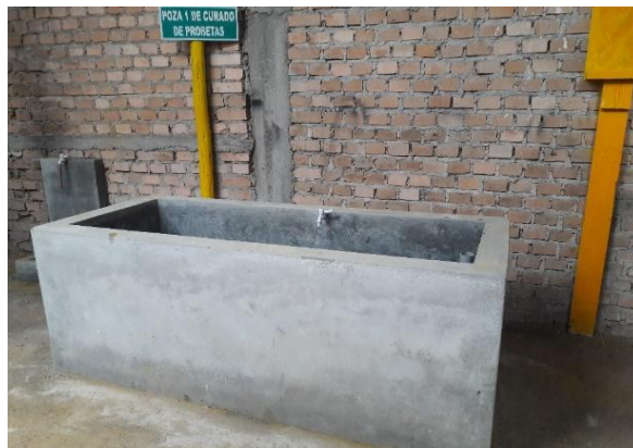
Figura 14 Tanque de concreto armado
