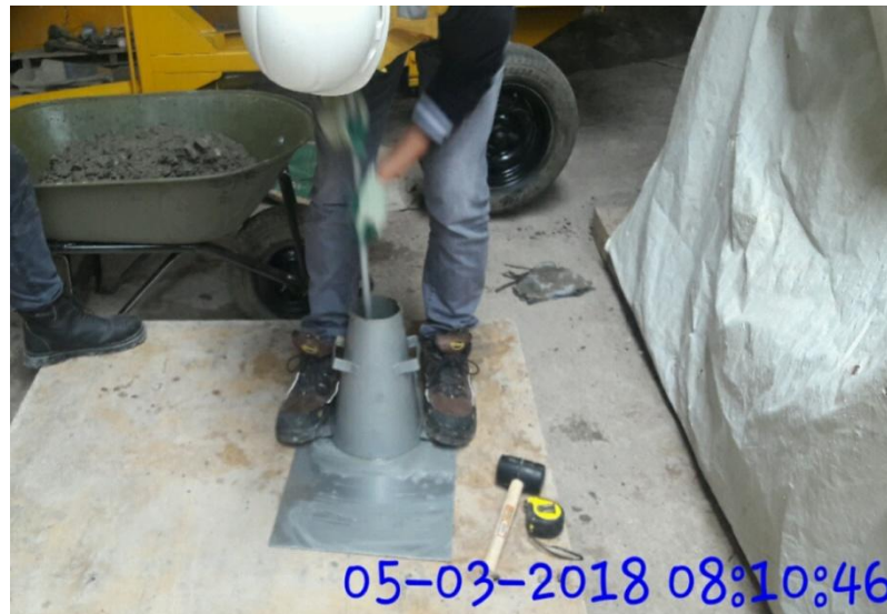
Figura 56 Verificando llenado del cono en la Tercera Capa.
