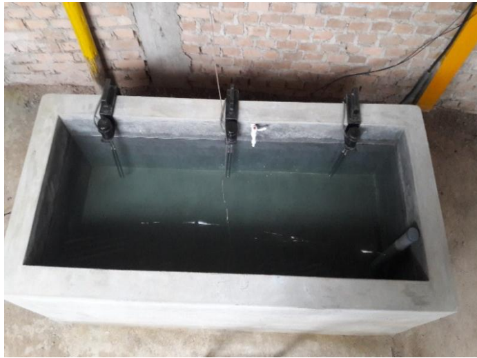
Figura 12 Tanque de curado acelerado con el panel de control.
