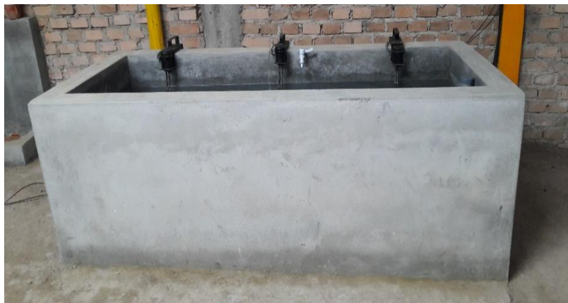
Figura 13 Tanque de concreto y distribución de los especímenes al interior del tanque
