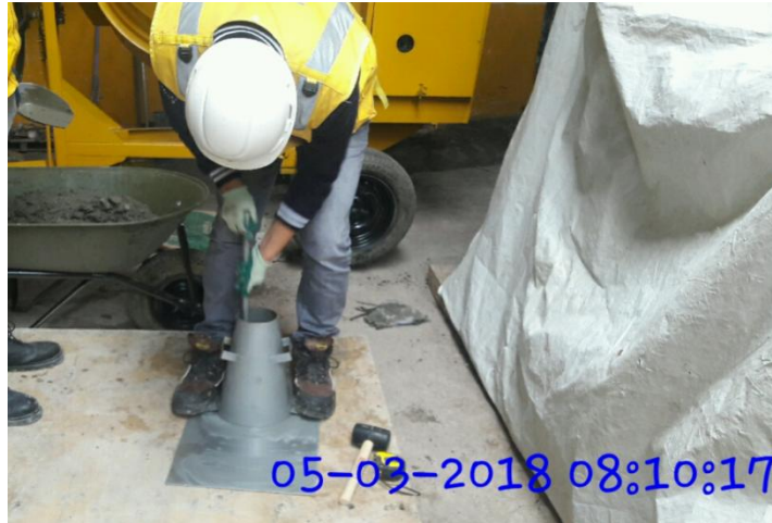
Figura 55 Pisoneando con la Varilla alrededor del perímetro hacia el centro
