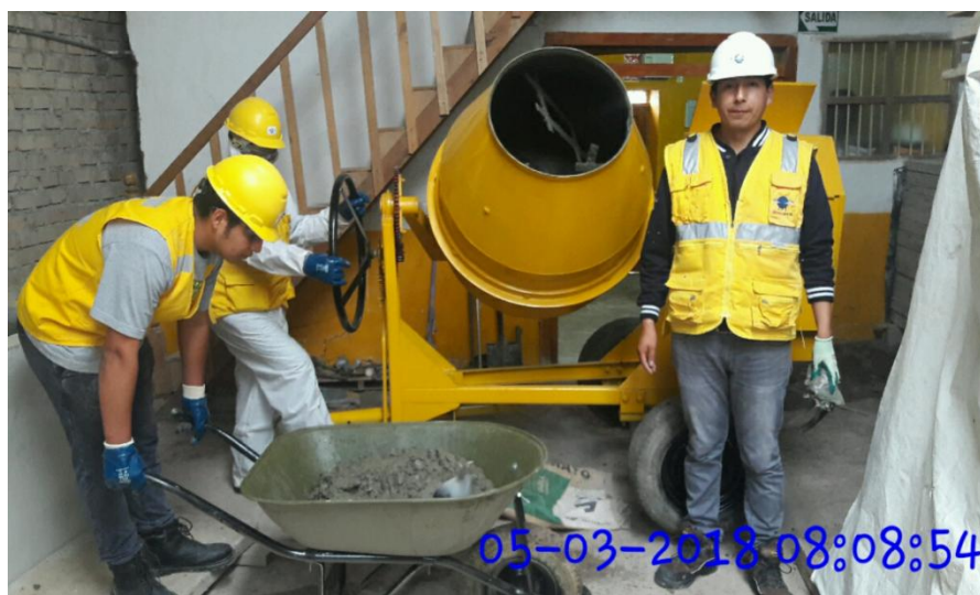
Figura 48 Mezcladora preparando concreto.
