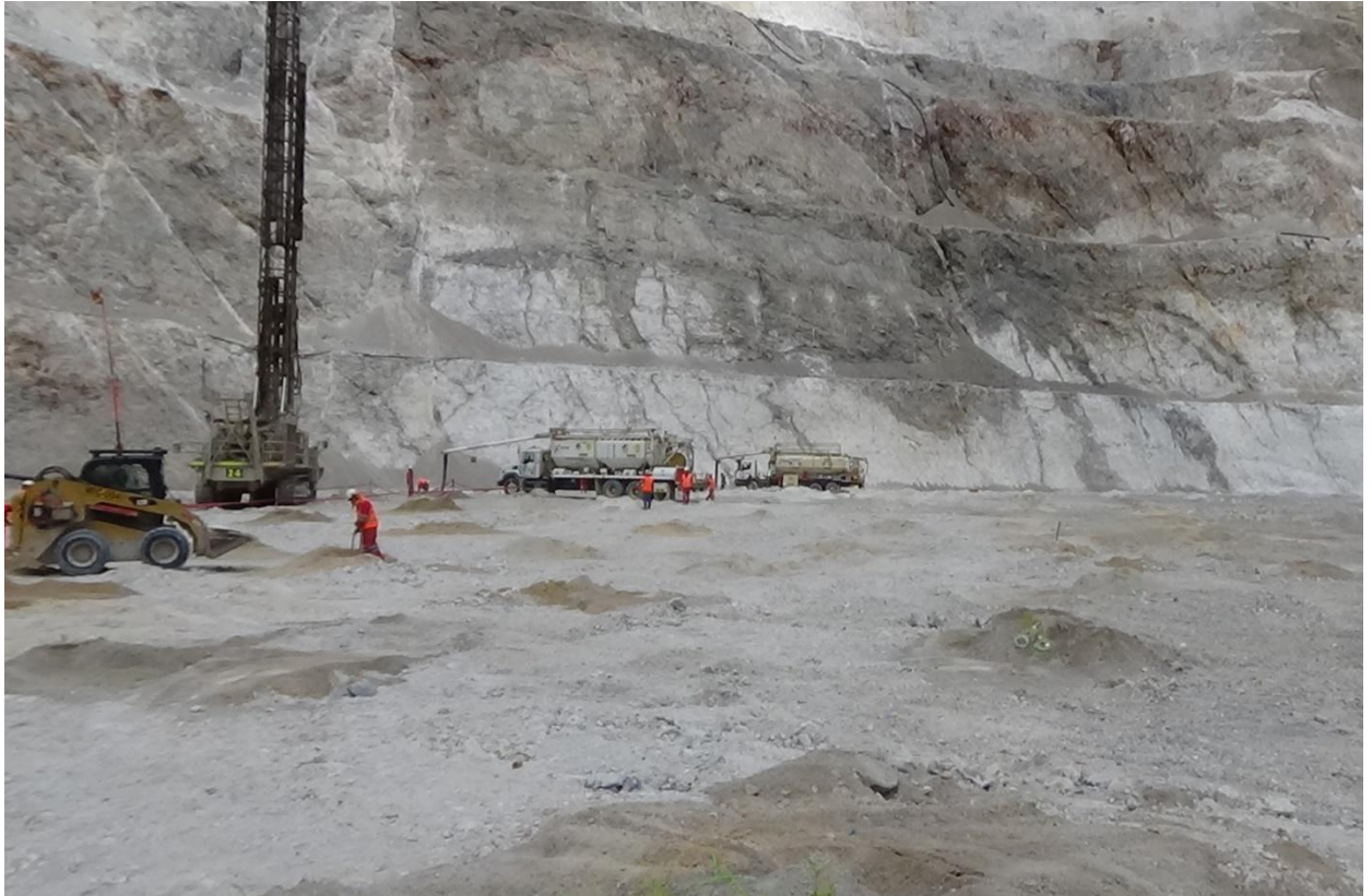
Figura 34. Iniciación de carguío de malla
