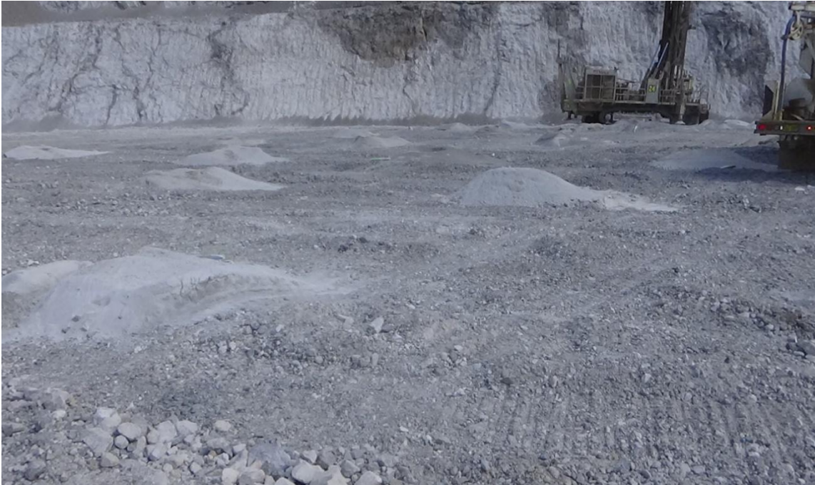
Figura 21. Imagen pre voladura.
