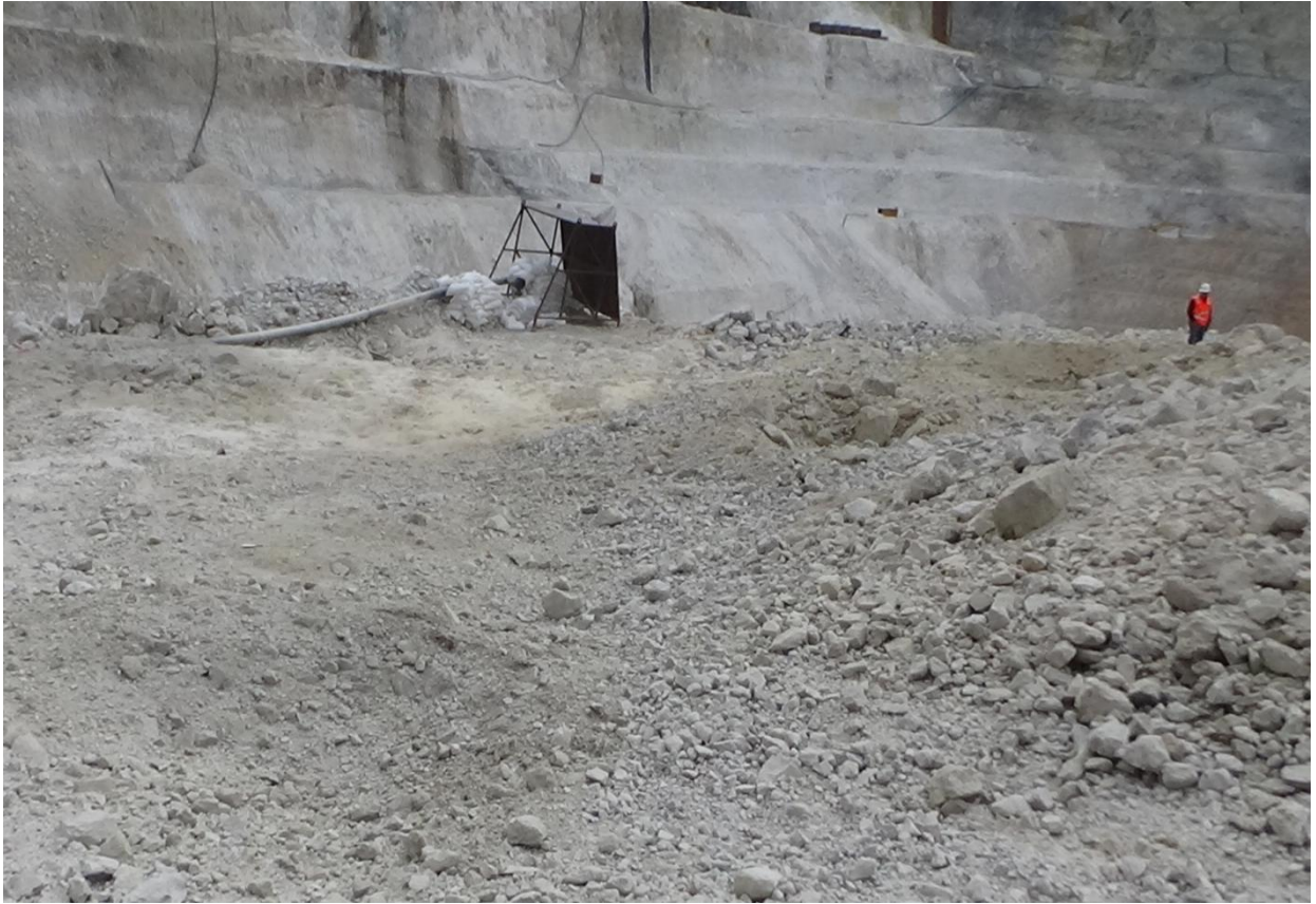
Figura 36. Imagen post voladura
