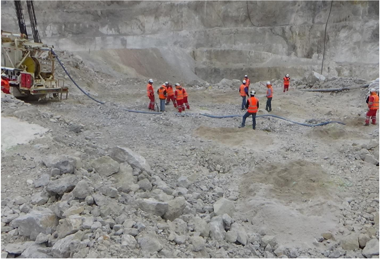
Figura 35. Imagen pre voladura
