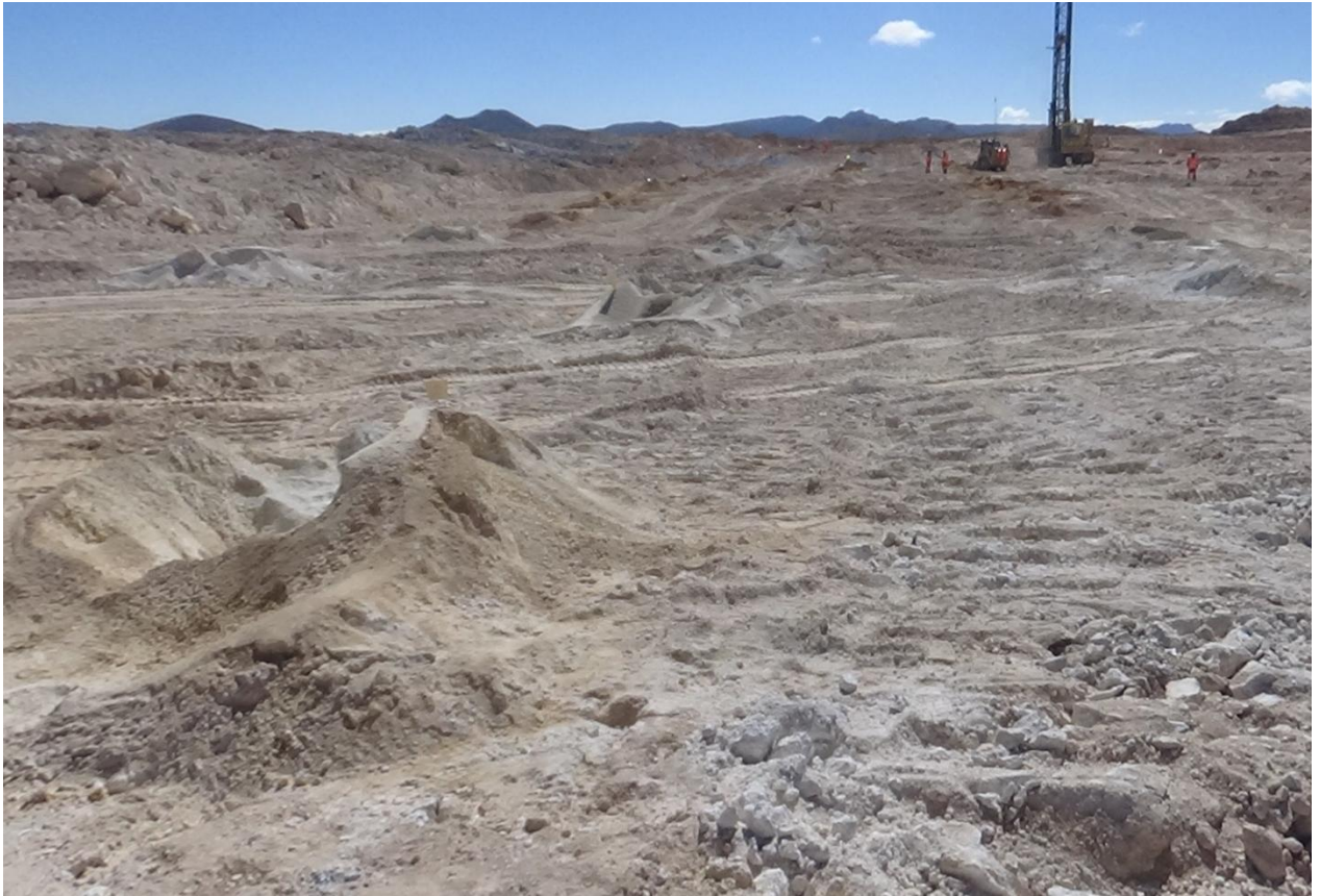
Figura 41. Imagen Pre voladura.
