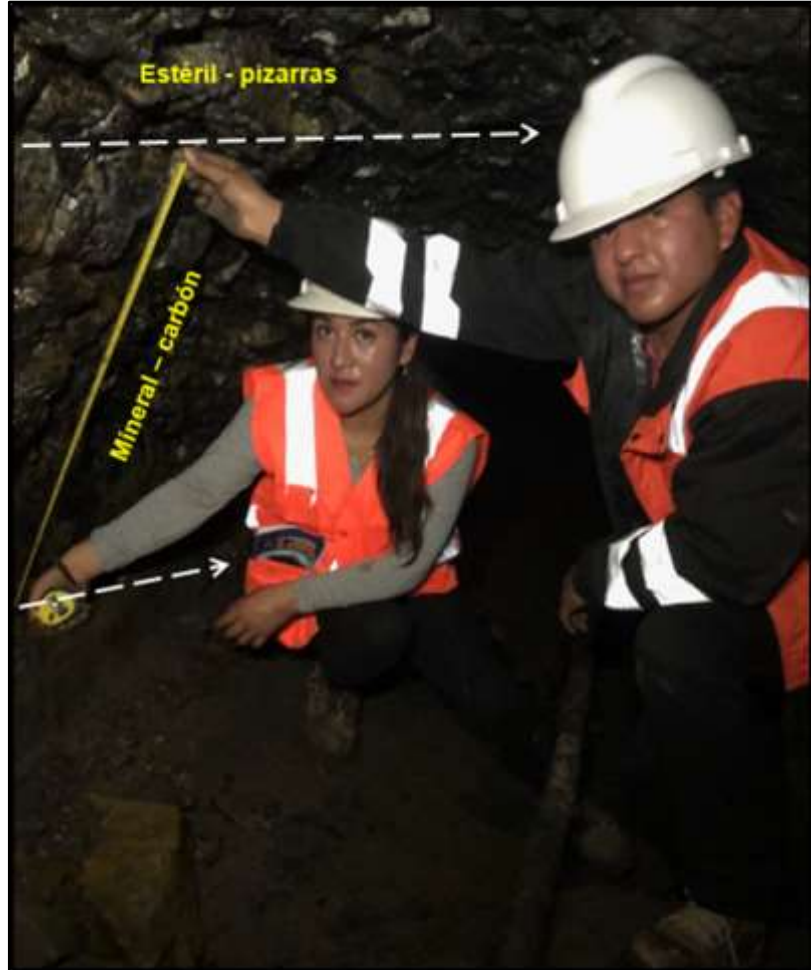
Figura 5. Toma de las medidas del espesor del manto.
