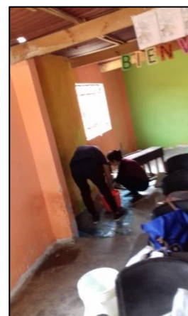
Figura N° 9. Pintado de los laterales de la parte interior de la escuelita
