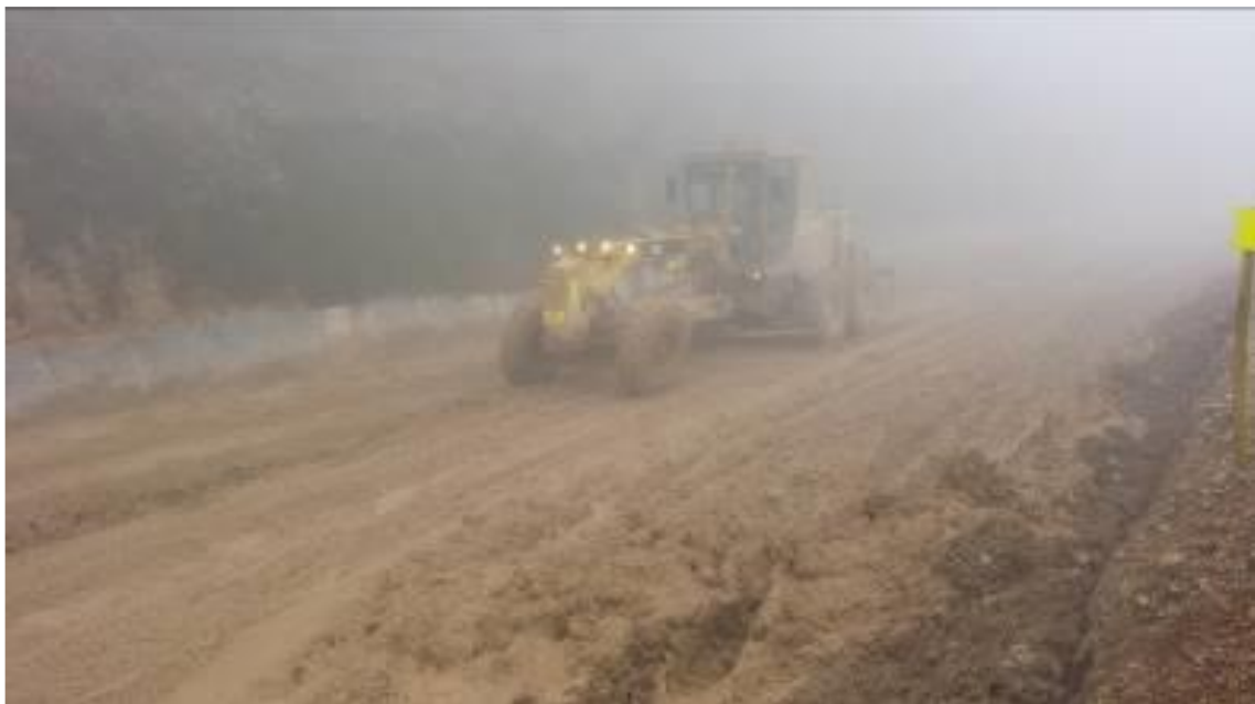
Motoniveladora haciendo corte De vía eliminando rebada
