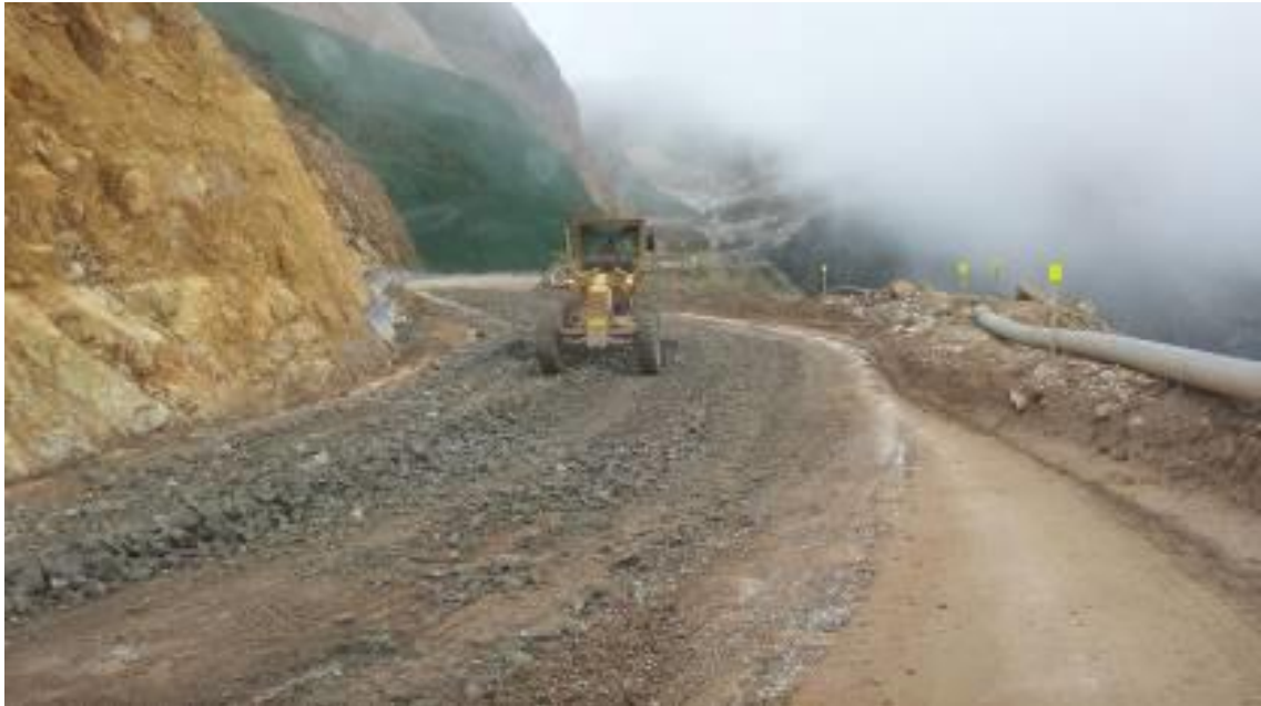
Motoniveladora realizando lastrado
