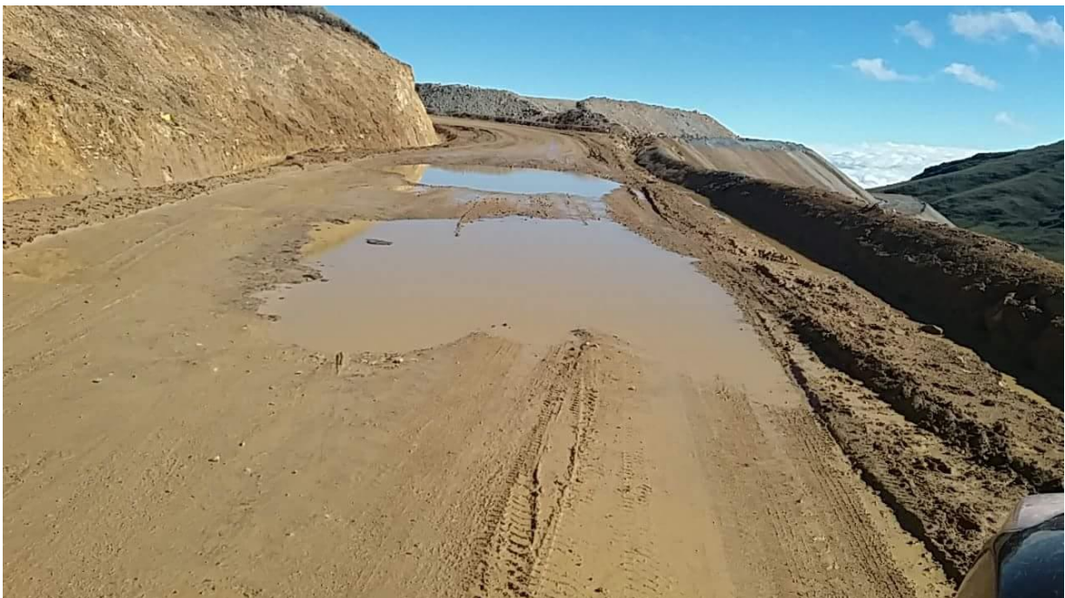
Vías en mal estado
