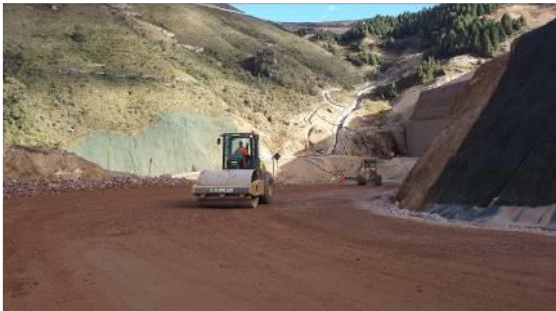
Rodillo compactando material de lastre
