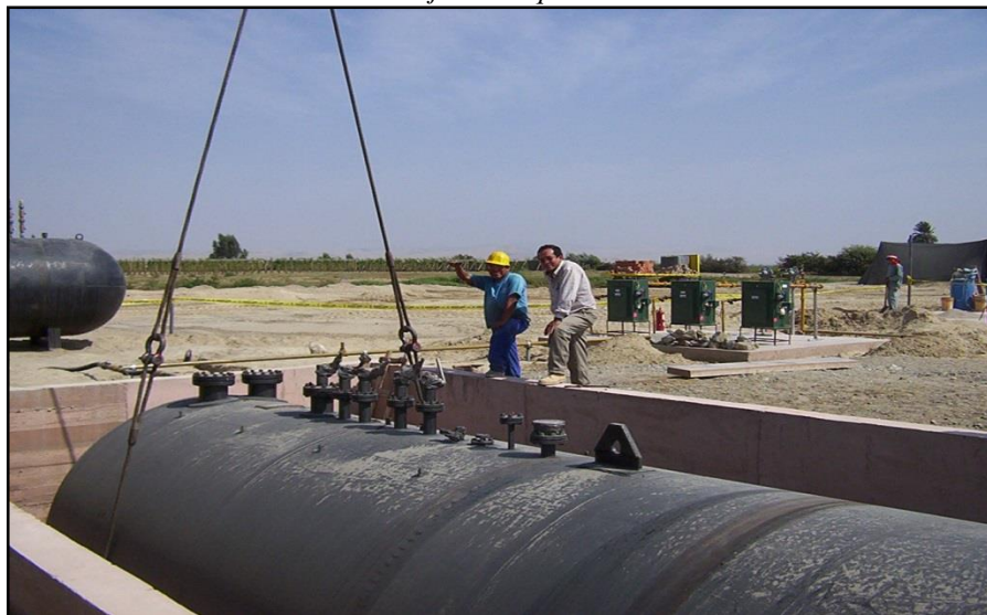
FIGURA 9. Montaje de tanque subterráneo
