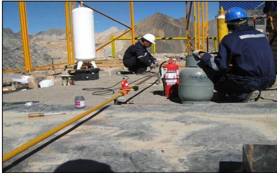
FIGURA 6. Conexión de tuberías de Cu (Soldadura – Capilaridad)
