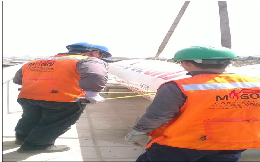
FIGURA 8. Montaje de tanque aéreo.
