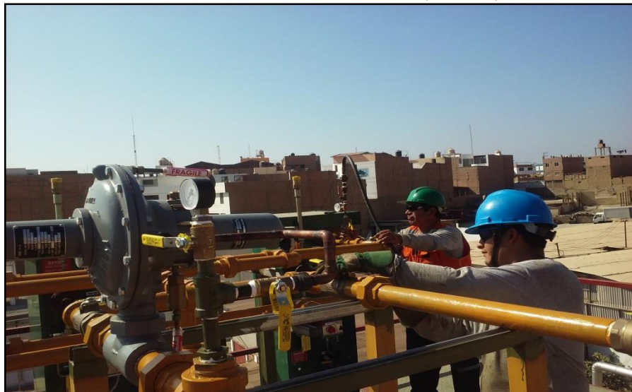
FIGURA 5. Conexión de tuberías de acero (Rosgado)
