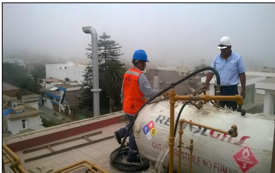
FIGURA 11. Tanque aéreo montado
