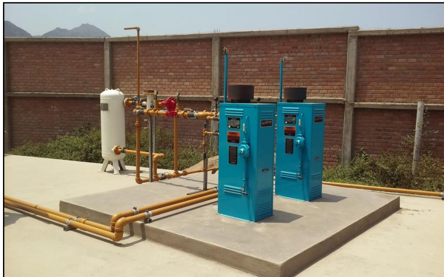
FIGURA 10. Montaje de equipos
