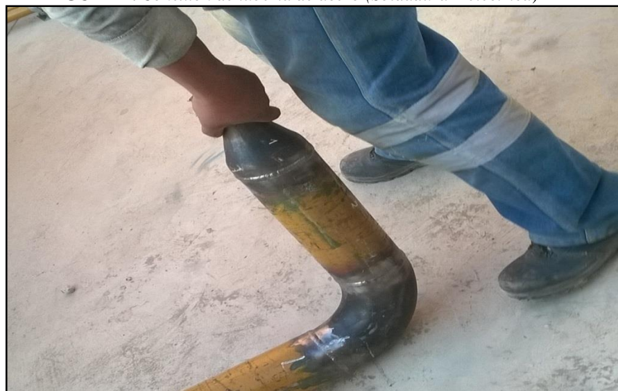
FIGURA 7. Conexión de tubería de acero (Soldadura – eléctrica)
