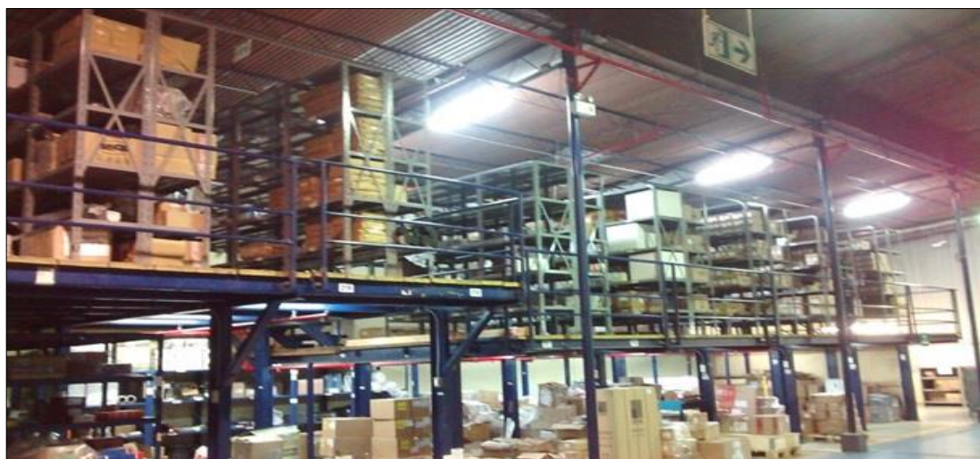
Figura 7 Estantería metálica Fuente: Foto tomada en el almacén
