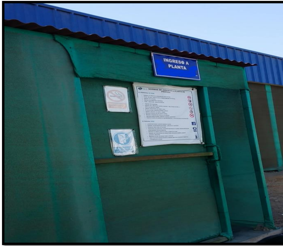
Imagen 02. Ingreso a la planta de operaciones - Huaral
