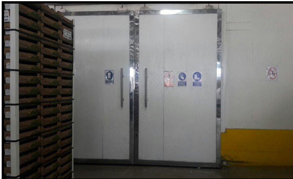
Imagen 27. Cámara de almacenamiento, también llamado Túnel de pre- enfriamiento, la temperatura es de 5°C a 7°C.
