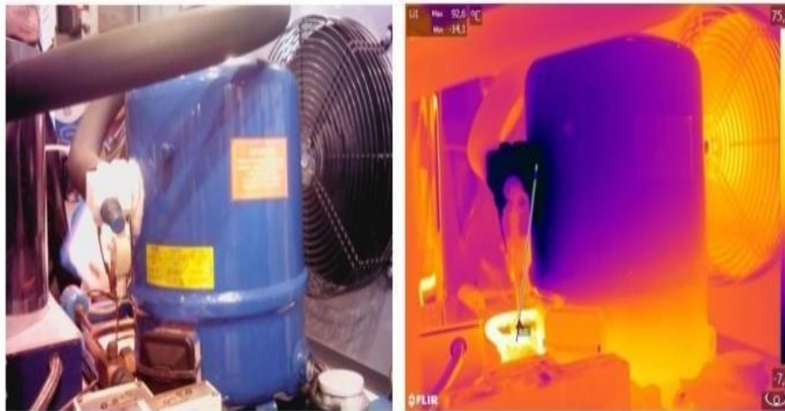
Figura n.º 37. Imagen de Compresor con cámara termográfica
