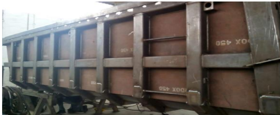
Figura n.º 3.8. Estructura en preparación para pintar base
