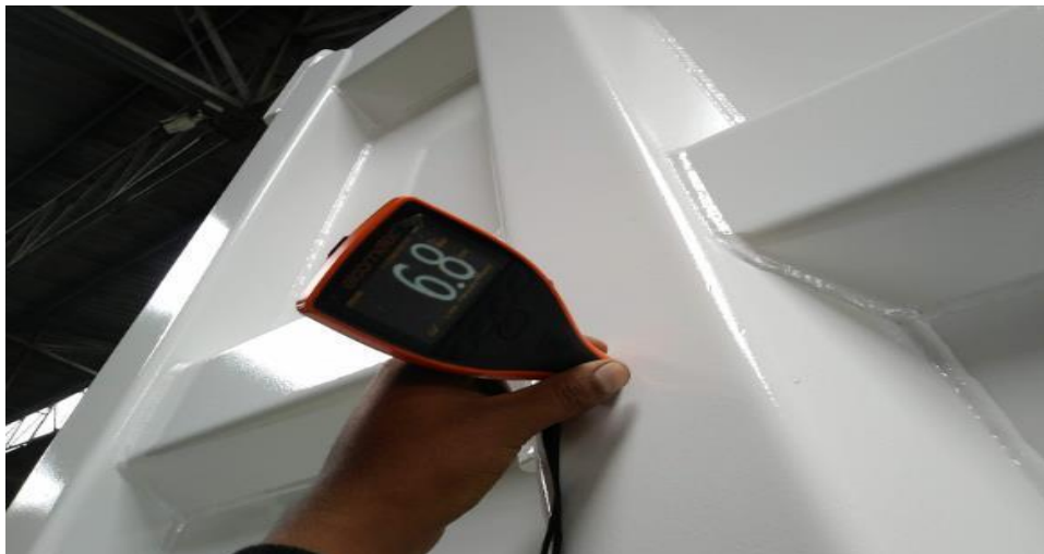
Figura n.º 3.12. Control de espesor de pintura
