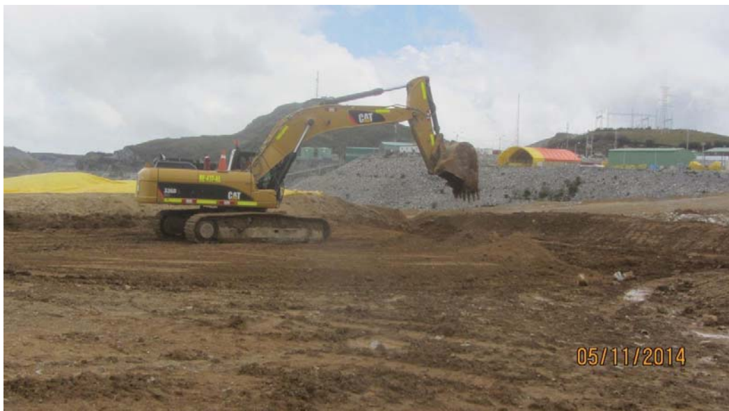
Foto 2: Reemplazo de materiales para fundación. Panel Test N° 3 – Fecha 05-11-14
