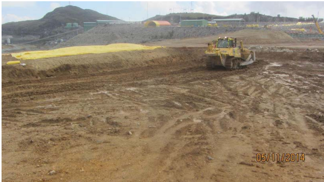
Foto 1: Limpieza de área de fundación. Panel Test N° 3 - Fecha 05-11-14.
