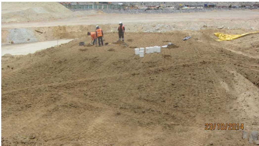
Foto 12: Vista panorámica de instalación de anillos en las áreas de 8, 9 y 10 ciclos de rodillo pata de cabra Panel Test N° 1 - Fecha 23-10-14
