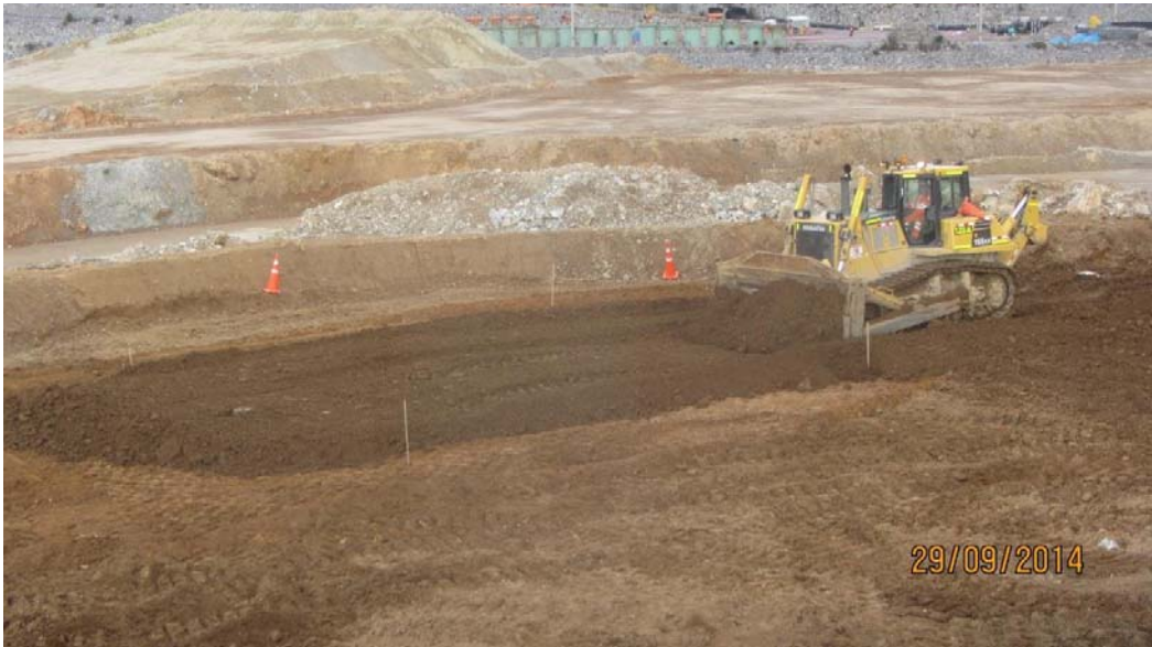
Foto 11: Conformación de capas, Panel Test N° 1 - Fecha 29-09-14
