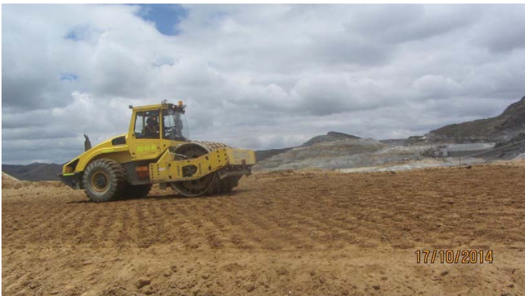
Foto 6: Compactación de capas, Panel Test 2 - Fecha 17-10-14.
