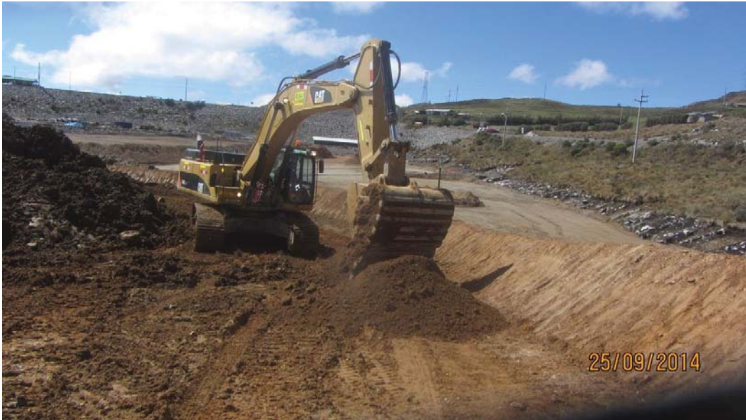
Foto 3: Muestreo de material Limox, para ensayos de macro granulometría, Panel Test N° 1 - Fecha 25-09-14.
