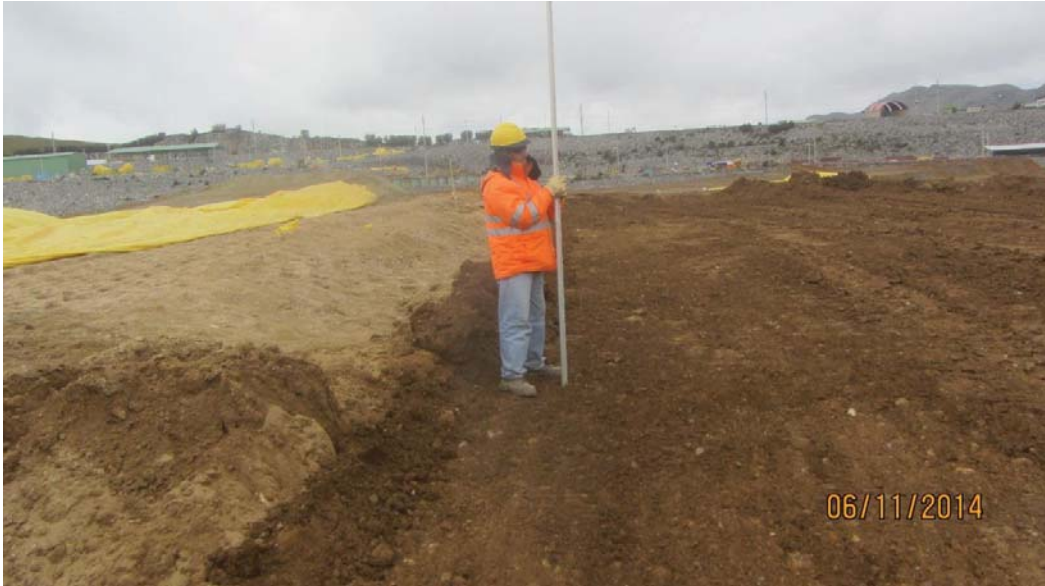
Foto 7: Control de espesores de capa, Panel Test N° 3 – Fecha 06-11-14.
