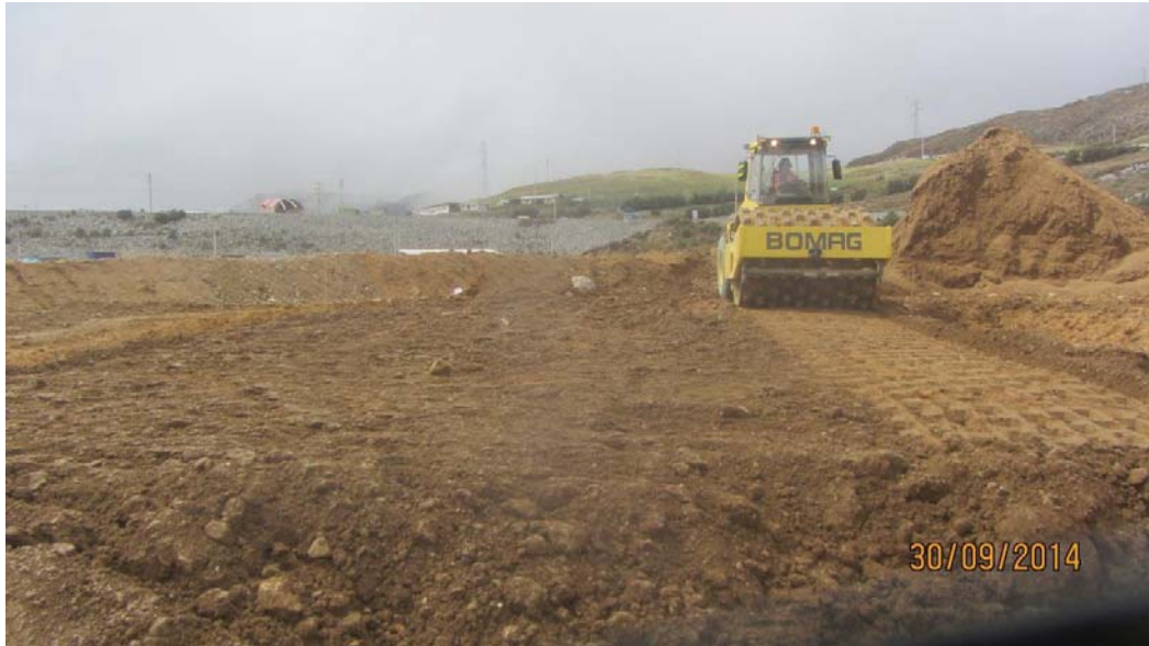
Foto 13: Compactación de capas, Panel Test N° 1 - Fecha 30-09-14
