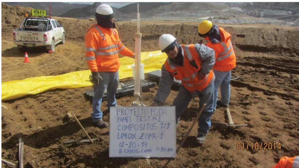
Foto 14: Ejecución del ensayo de permeabilidad con Guelph, Panel Test N° 1 - Fecha 01-10-14.
