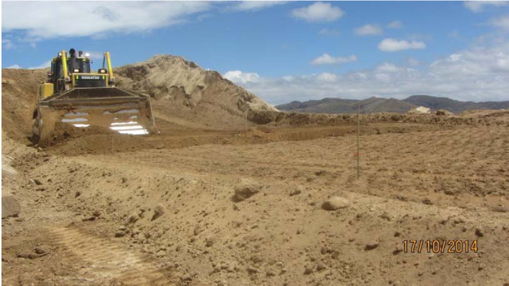
Foto 1: Preparación de fundación, Panel Test N° 2 - Fecha 17-10-14.
