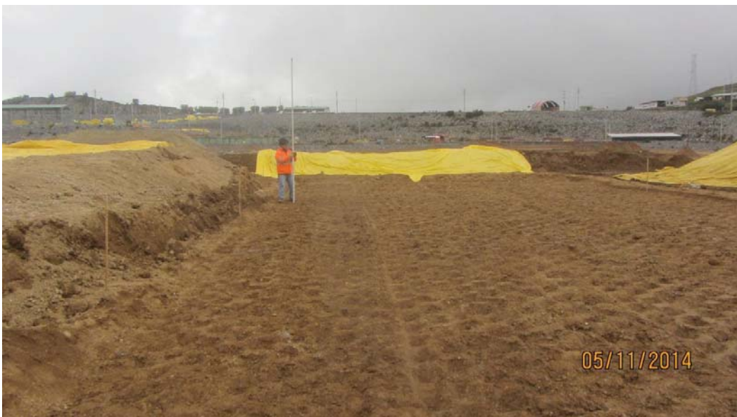
Foto 4: Control de niveles de fundación
