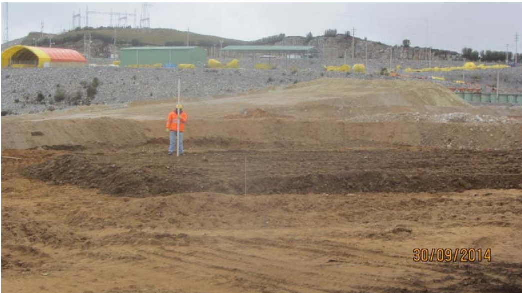
Foto 12: Control de espesores de capa, Panel Test N° 1 - Fecha 30-09-14
