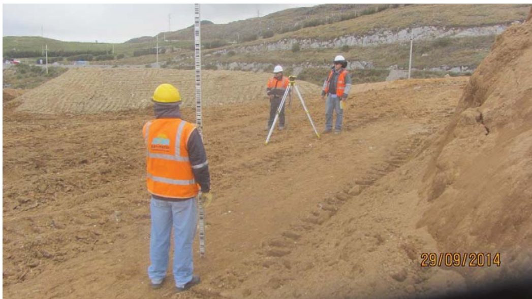
Foto 8: Control topográfico de fundación para ejecución de Panel Test N° 1 – Fecha 29-09-14.
