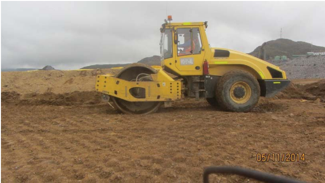
Foto 3: Compactación de piso de fundación, Panel Test N°3- Fecha 05-11-14.
