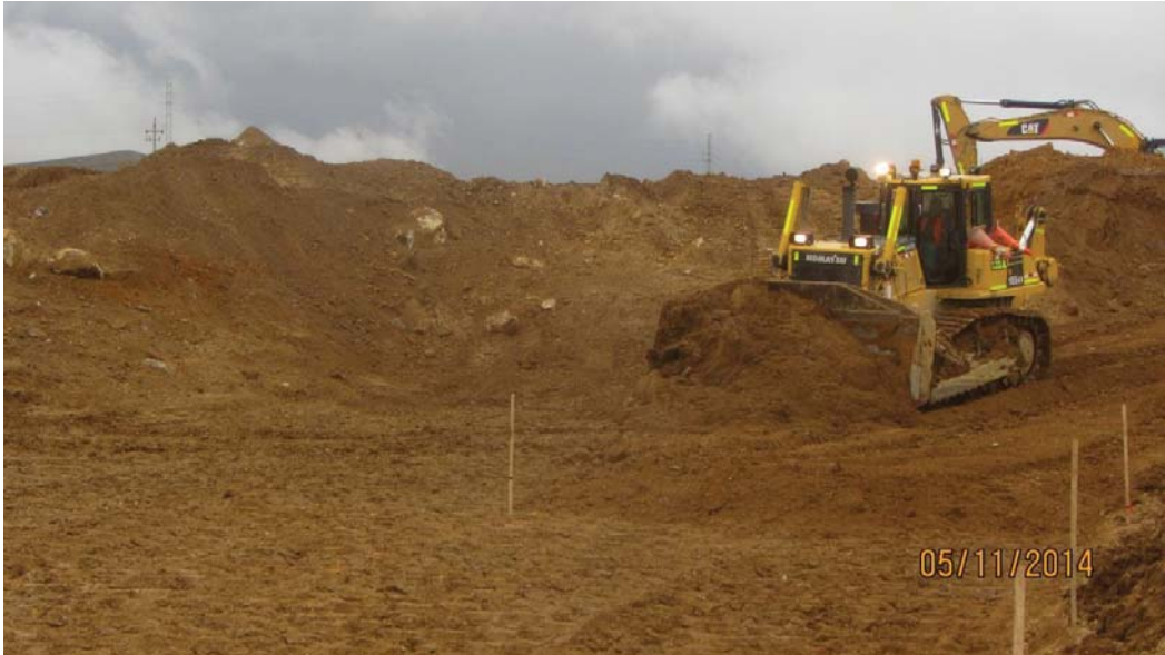
Foto 5: Acondicionamiento de área para confinamiento de material procesado, Panel Test N°3 - Fecha 05-11-14
