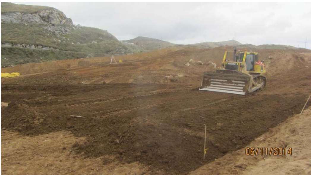
Foto 6: Conformación de capas, Panel Test 2 - Fecha 06-11-14.
