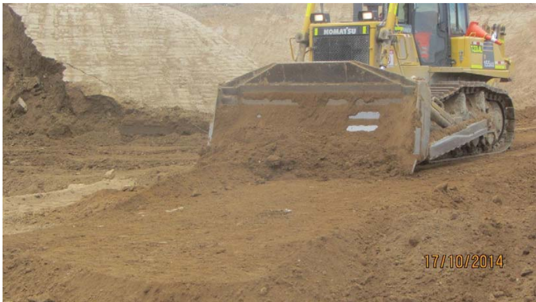
Foto 4: Conformación de capas, Panel Test N° 2 - Fecha 17-10-14.
