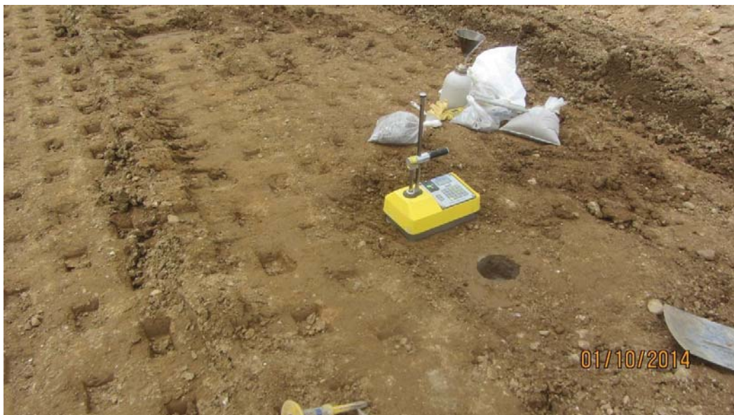
Foto 16: Ejecución de ensayo de densidad en campo, método nuclear, Panel Test N° 1 - Fecha 01-10-14.
