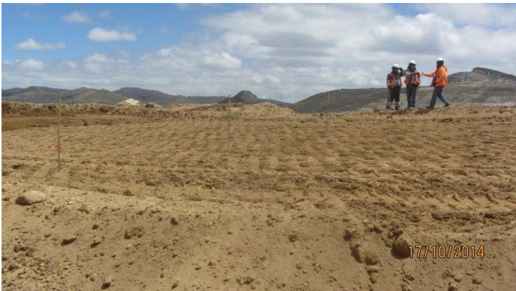
Foto 2: Fundación compactada para ejecución de Panel Test N° 2 – Fecha 17-10-14.
