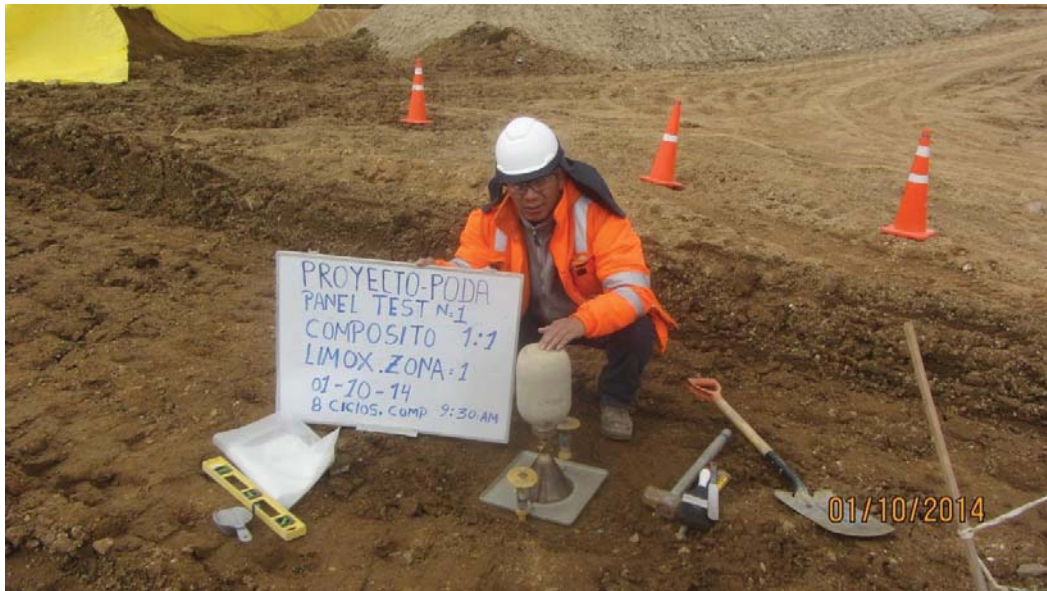
Foto 15: Ejecución de ensayo de densidad en campo, método de cono de arena, Panel Test N° 1 - Fecha 01-10-14.
