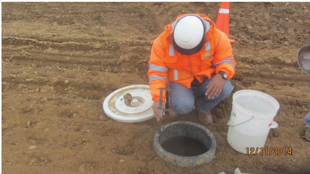
Foto 12: Permeabilidad con anillo capa N° 4, Panel Test N° 1 - Fecha 12-11-14
