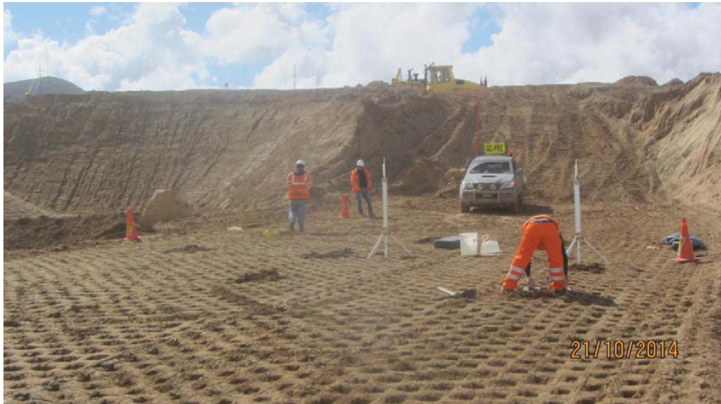
Foto 7: Permeabilidad con Guelph, instalación de equipos, Panel Test N° 2 – Fecha 21-10-14.
