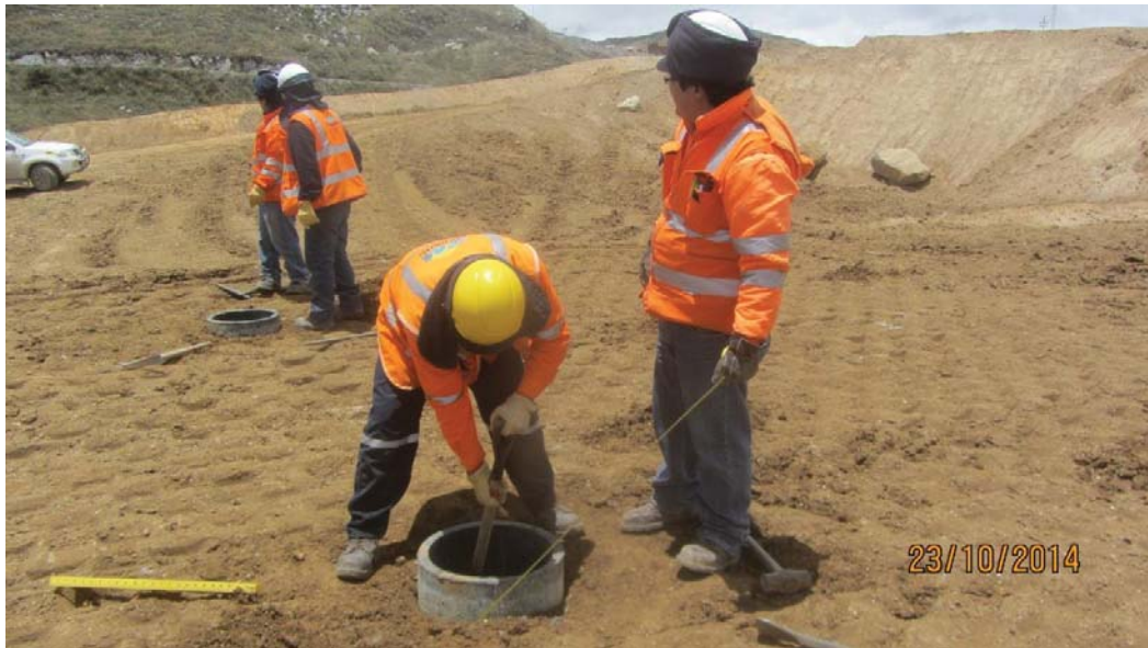
Foto 11: Permeabilidad con anillo, instalación, Panel Test N° 2 - Fecha 23-10-14
