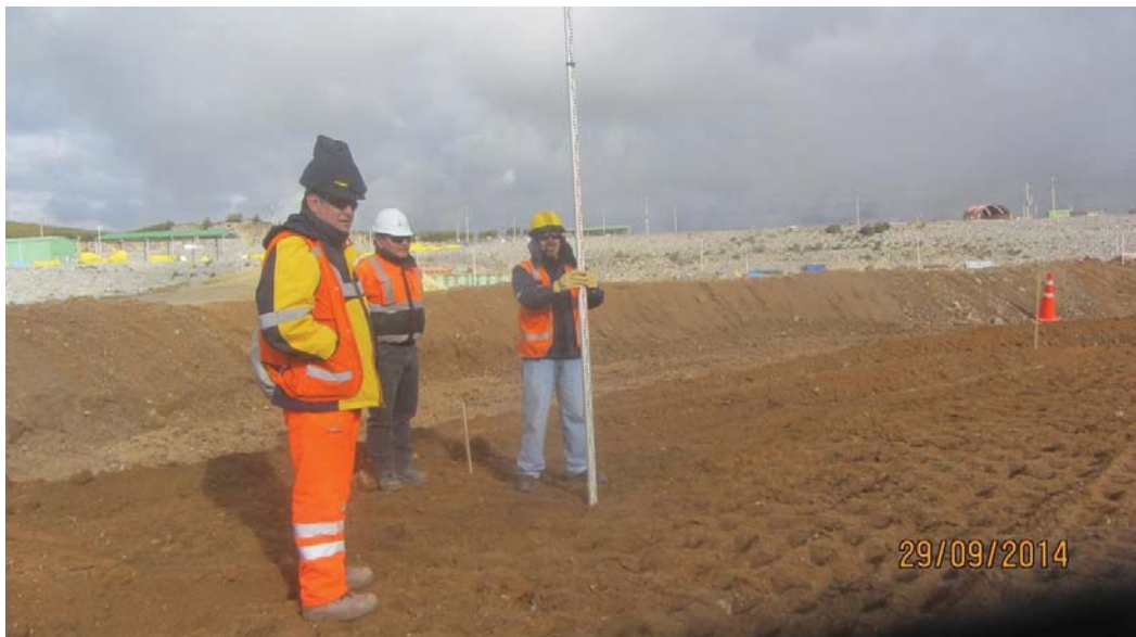
Foto 10: Control de niveles de fundación, Panel Test N° 1 - Fecha 29-09-14
