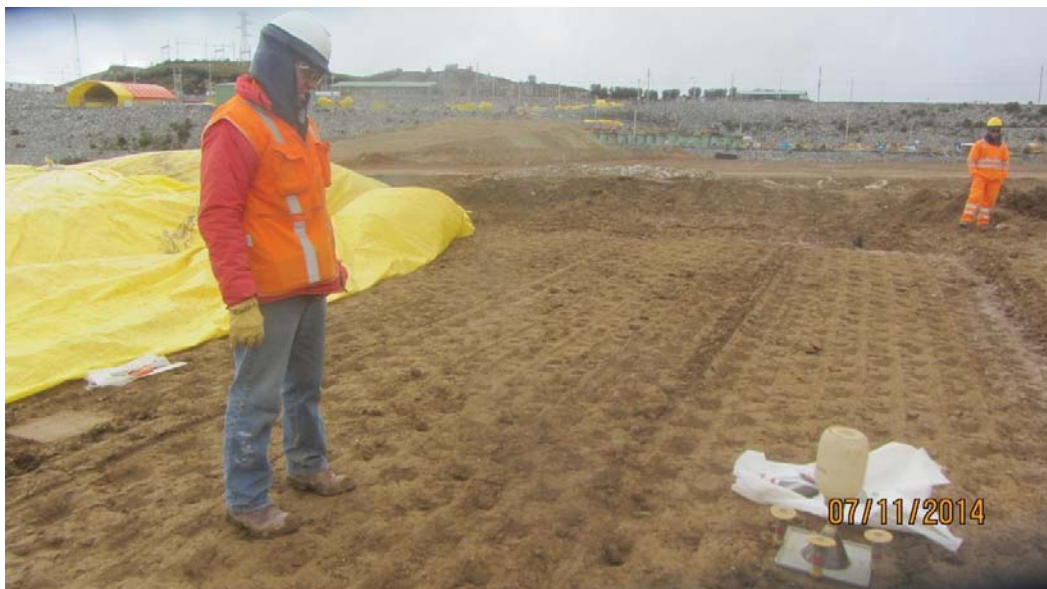
Foto 10: Densidad de Campo, método cono de arena área evaluada a 8 ciclos de rodillo pata de cabra, Panel Test N°3- Fecha 22-10-14
