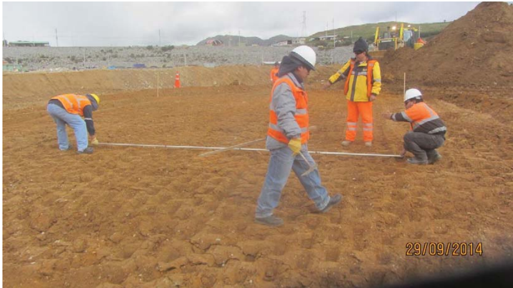
Foto 9: Compactación y habilitación de fundación para ejecución del Panel Test N° 1 , con rodillo pata de cabra Bomag de 19 Tn - Fecha 29-09-14
