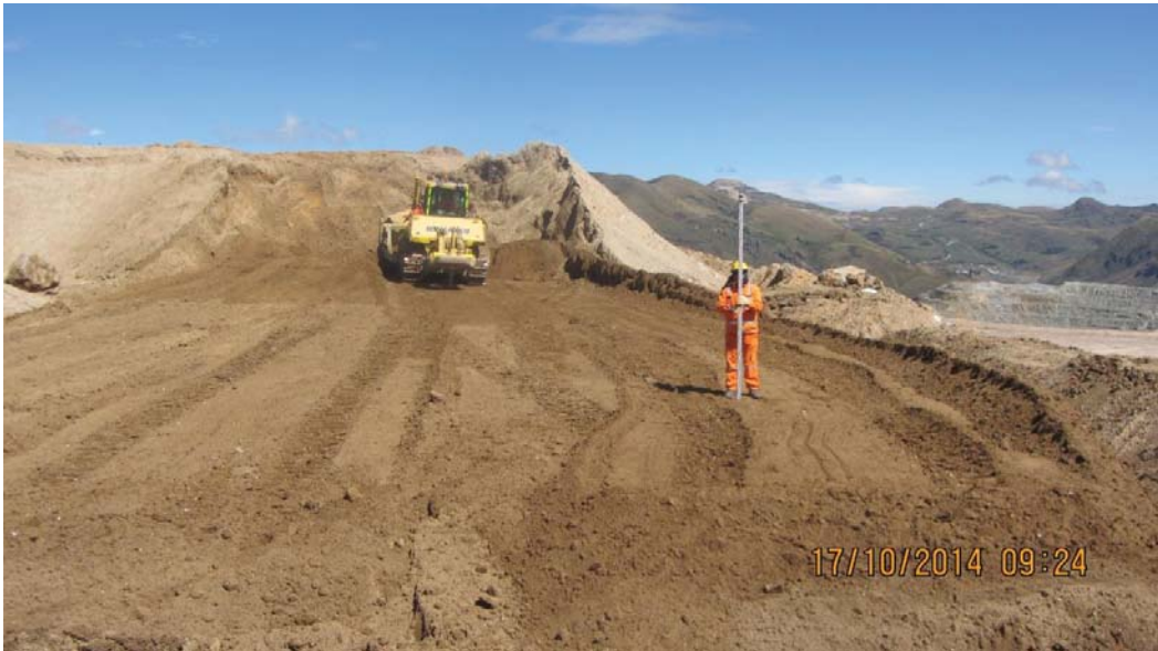
Foto 5: Control de niveles de capas, Panel Test N° 1 - Fecha 25-09-14.
