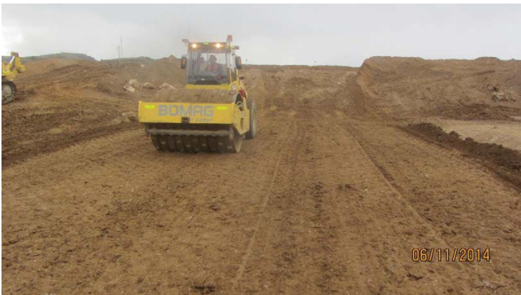
Foto 8: Compactación de capas, Panel Test N° 3 – Fecha 06-11-14.
