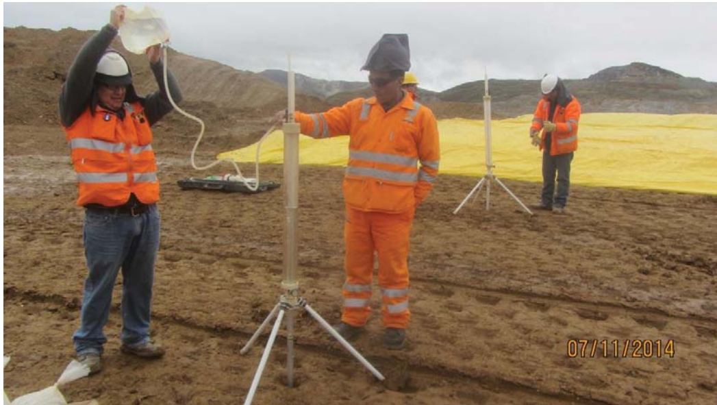
Foto 9: Permeabilidad con Guelph, áreas evaluadas a 8 y 10 ciclos de rodillo pata de cabra Panel Test N° 3 – Fecha 07-11-14.
