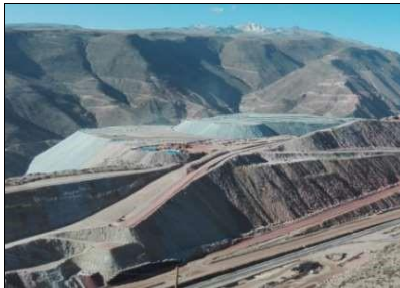
Figura 1: Botadero de una mina open pit. Fuente: (Ortíz, 2014).
