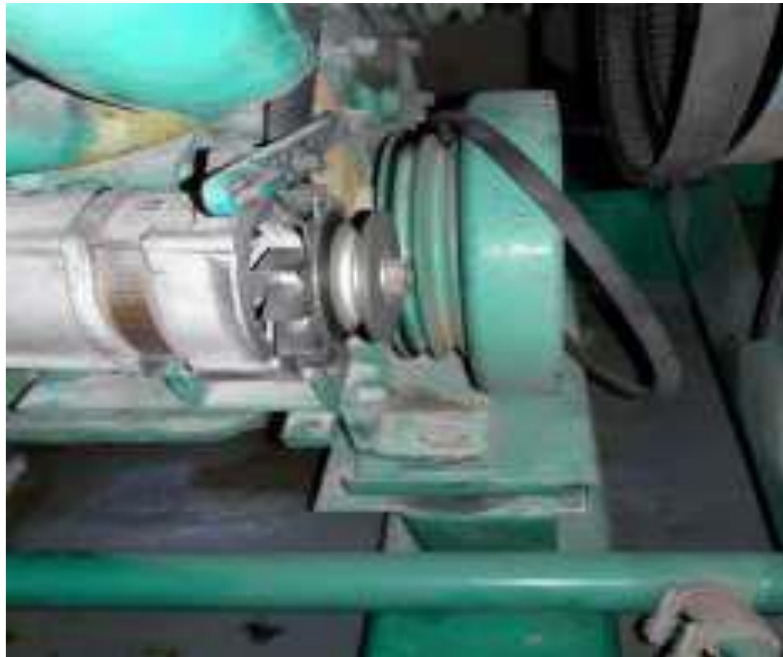
Figura n.º III-27 Inspección de alineamiento de ejes y funcionamiento de rodamientos Fuente: Informes de mantenimiento de DAT Ingeniería SAC
