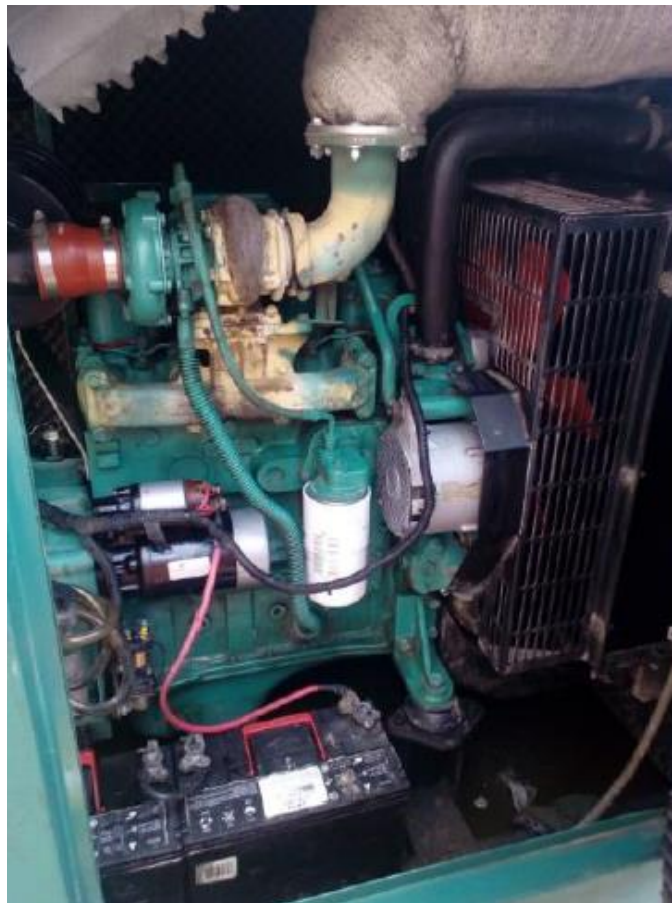
Figura n.º III-11 Radiador después de mantenimiento y limpieza con solvente Fuente: Informes de mantenimiento de DAT Ingeniería SAC
