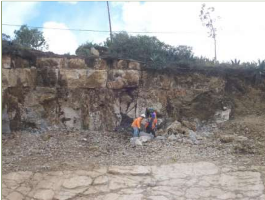
Fotografía Desatado y desquinche en la cantera
