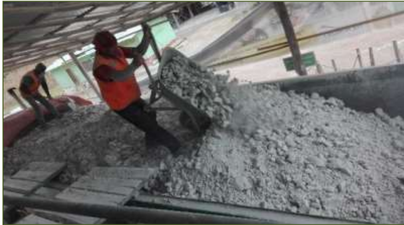
Fotografía Carguío de cal a volqueton para su transporte al destino final
