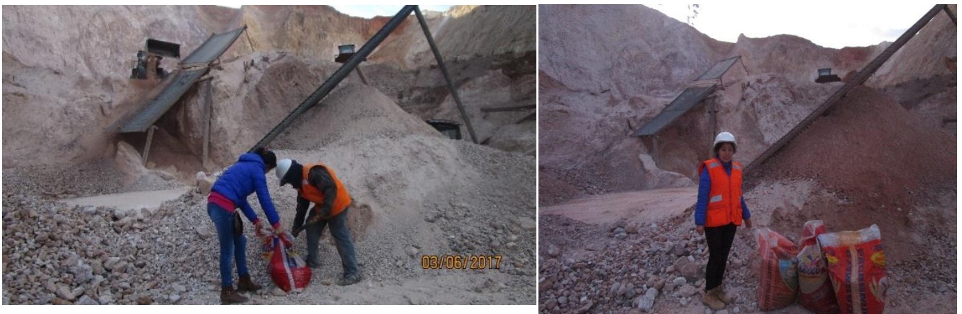
Foto N° 05: Obtención del material de afirmado de la cantera el Gavilán.
