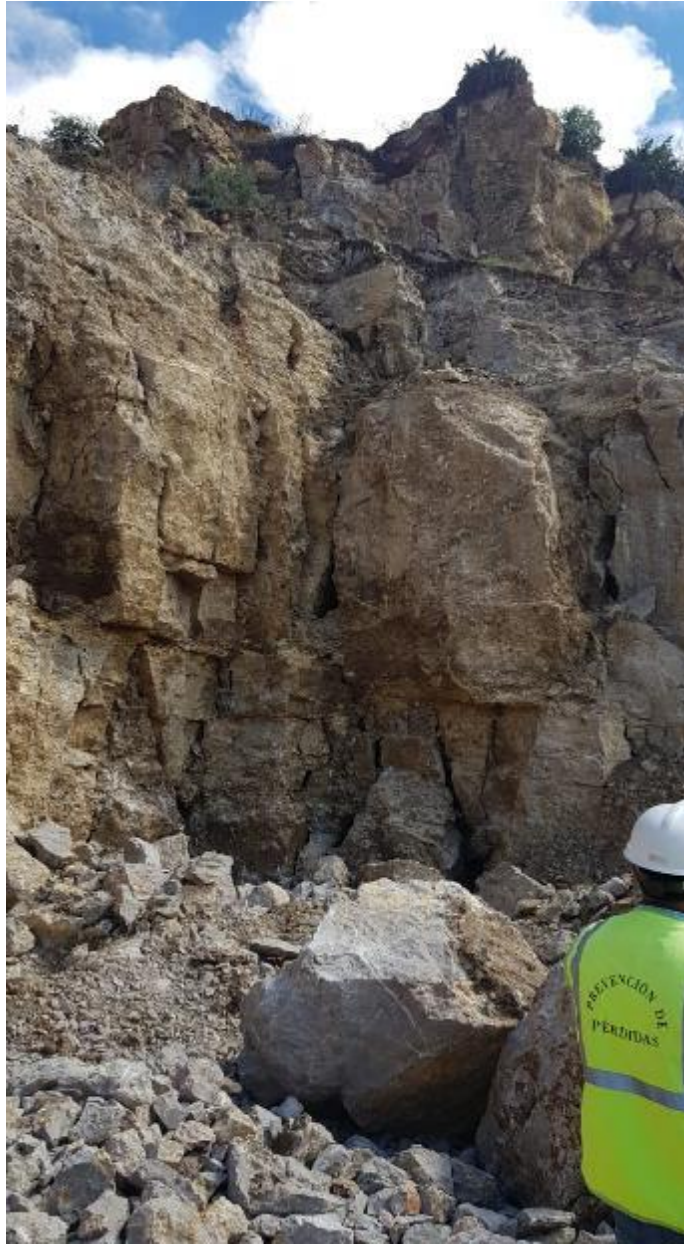
Foto 4 Frente de explotación con ángulo de talud inapropiado
