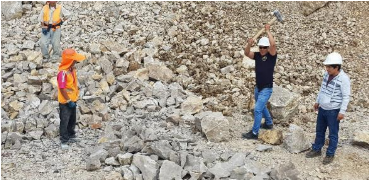
Foto 9 Realizando fracturamiento del macizo rocoso
