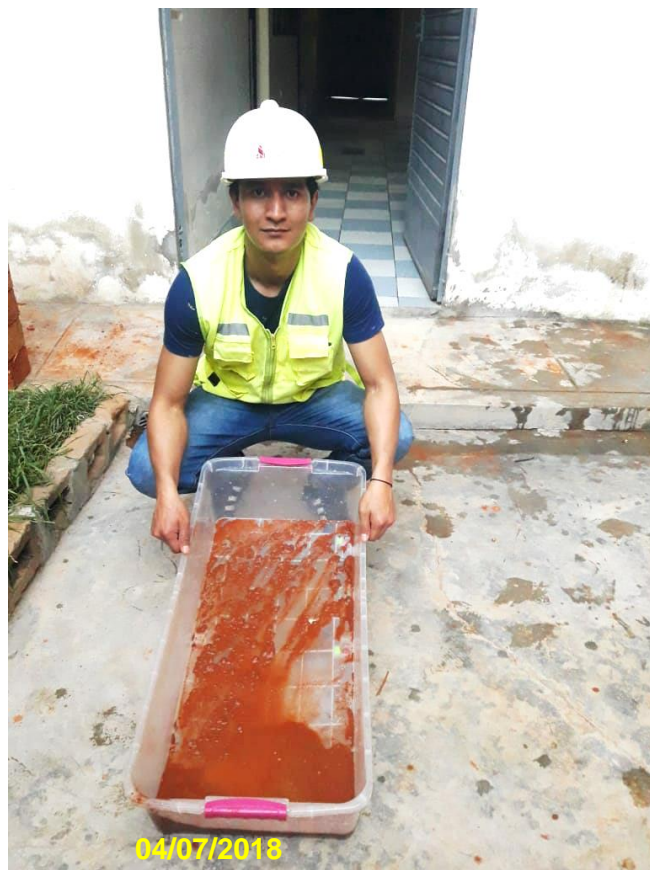
Figura 43 Resto de Adobes por haber estado sumergido en agua
