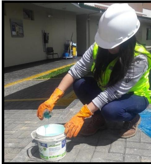
**Figura 10** Dosificación del aditivo para elaboración del concreto
