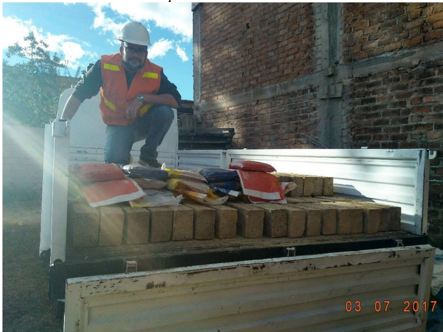
Foto 15: Transporte de los adobes hacia la universidad
