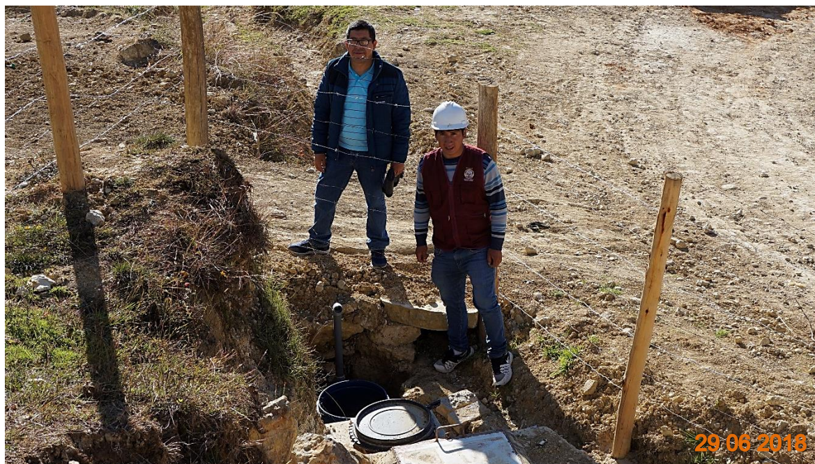
Figura 76. Inspección de filtro de la captación 1 por parte del Dr. Ingeniero Orlando Aguilar
