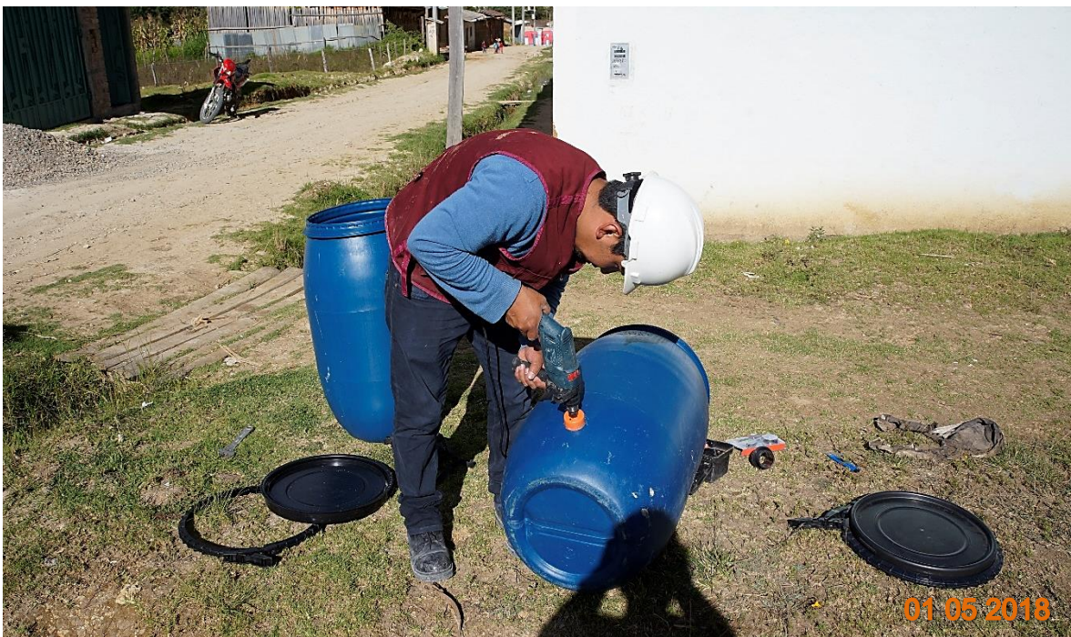
Figura 55. Perforación de tanque
