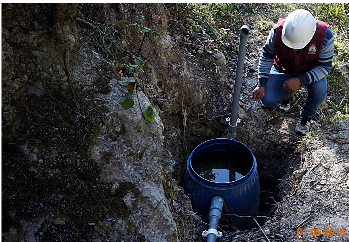
Figura 59. Realización de la instalación del tanque.
