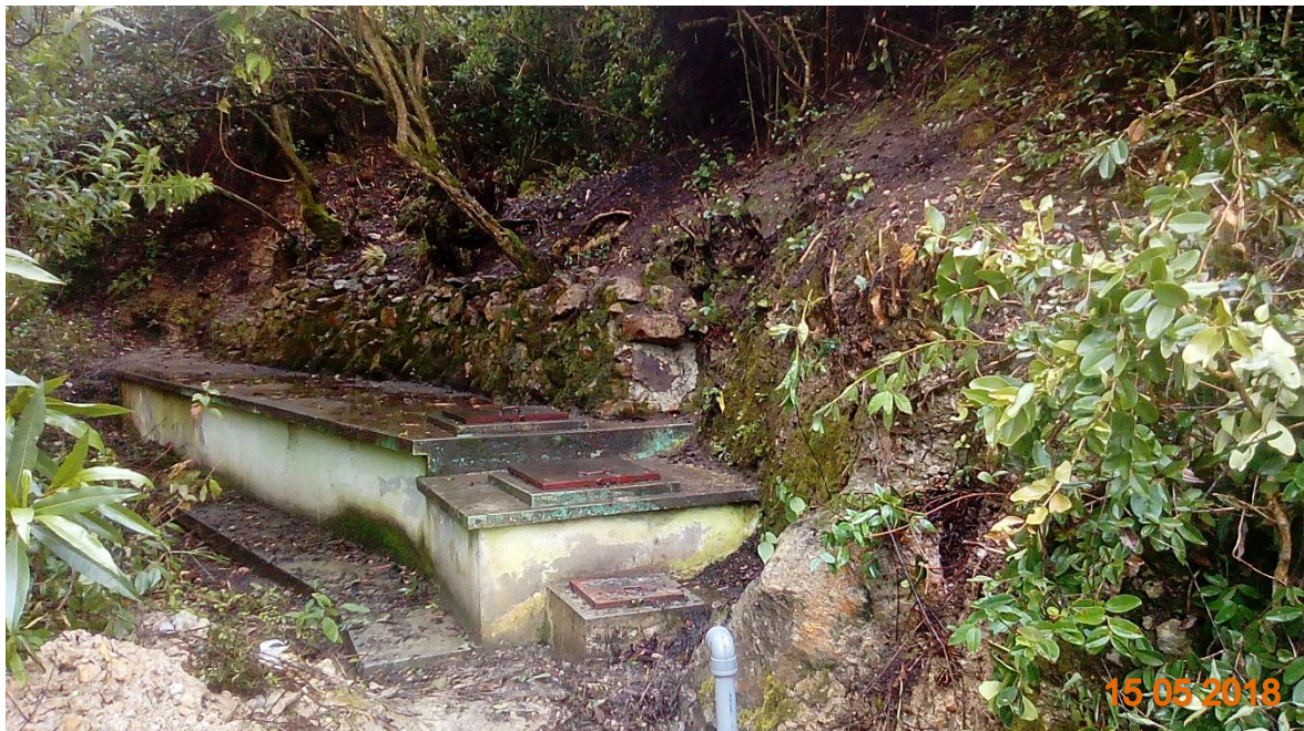
Figura 71. Talado de árboles - Captación 2.
