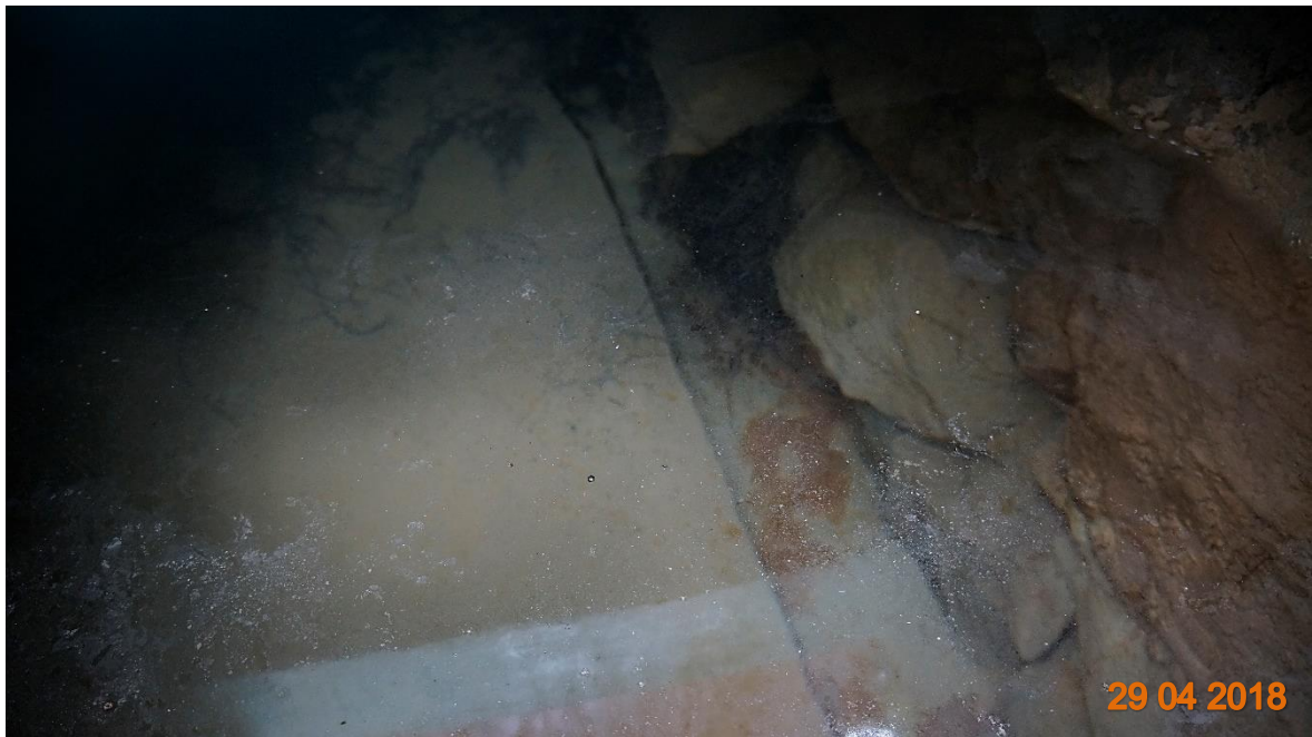
Figura 46. Estado actual de la captación 2.
