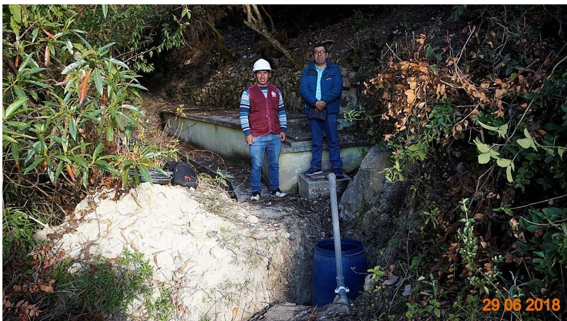
Figura 79. Inspección de la captación 2.
