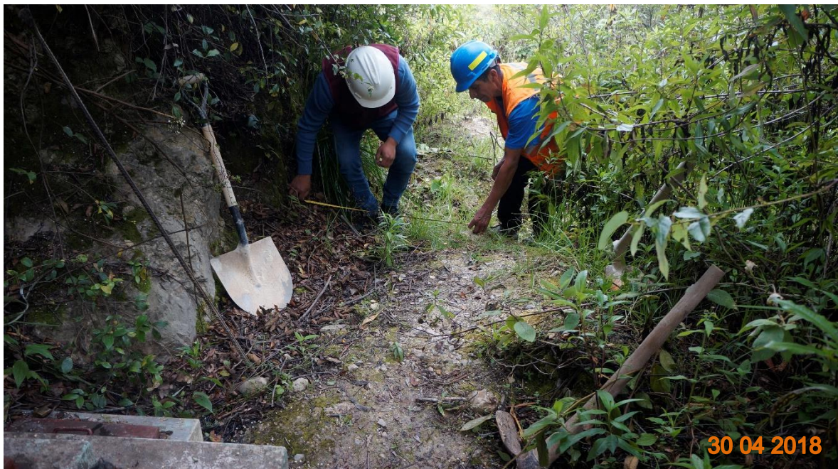
Figura 51. Trazo para excavación - captación 2.
