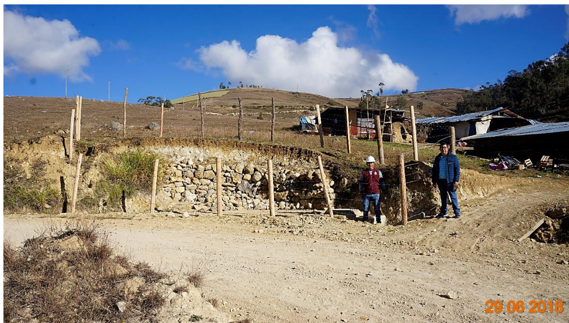
Figura 77. Inspección de la captación 1.
