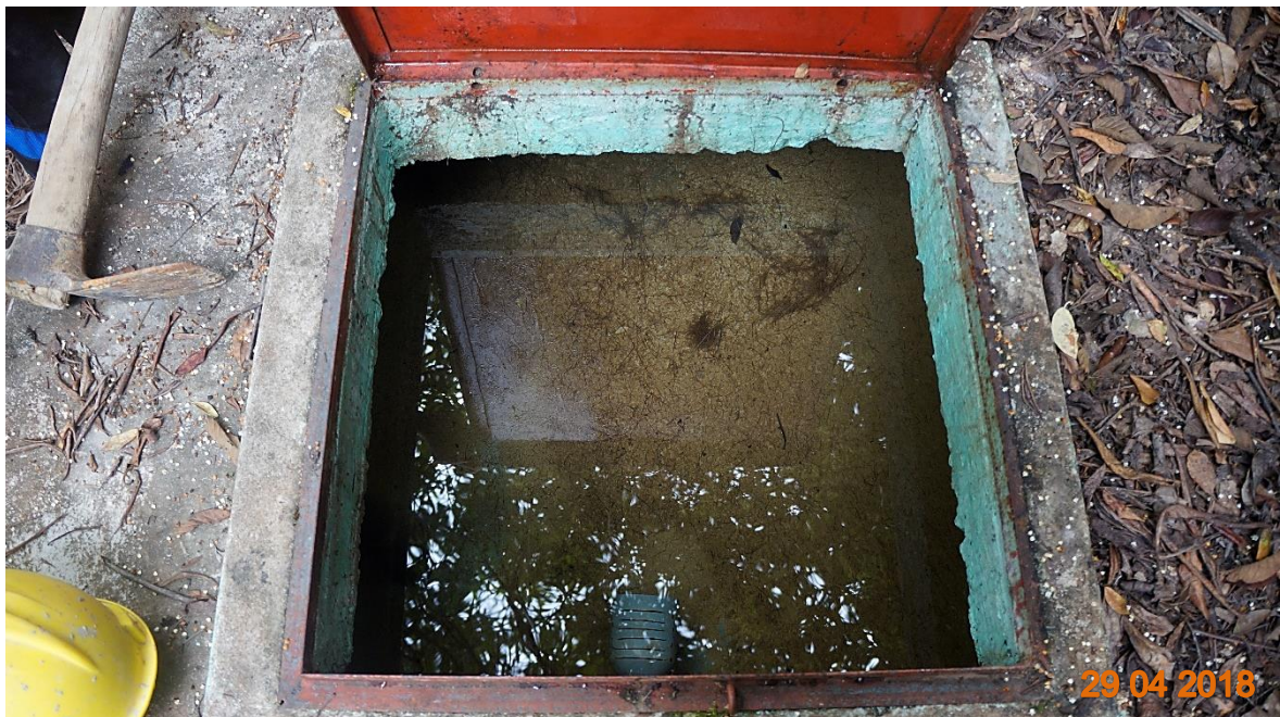
Figura 47. Estado actual de la cámara húmeda captación 2.
