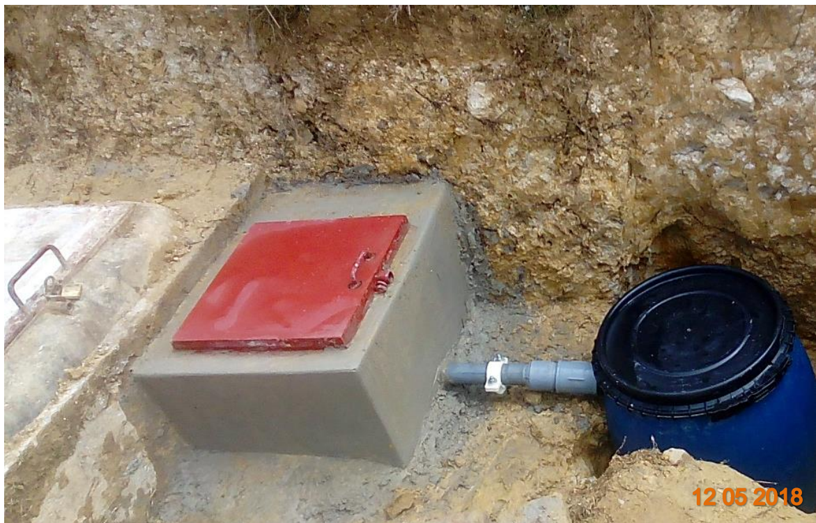
Figura 67. Construcción de caja de válvulas - Captación 1.
