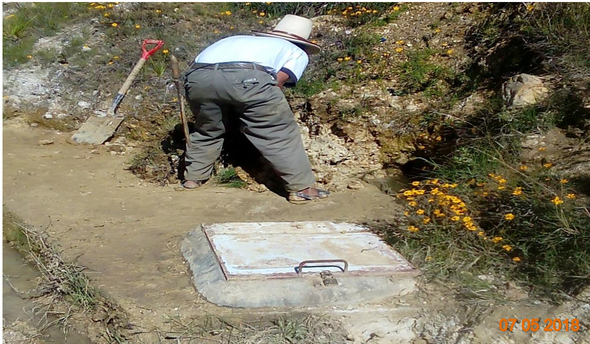
Figura 66. Mejoramiento de la Captación 1.
