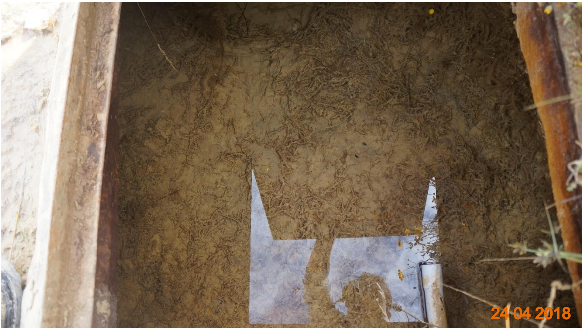
Figura 44. Estado actual de la captación 1.
