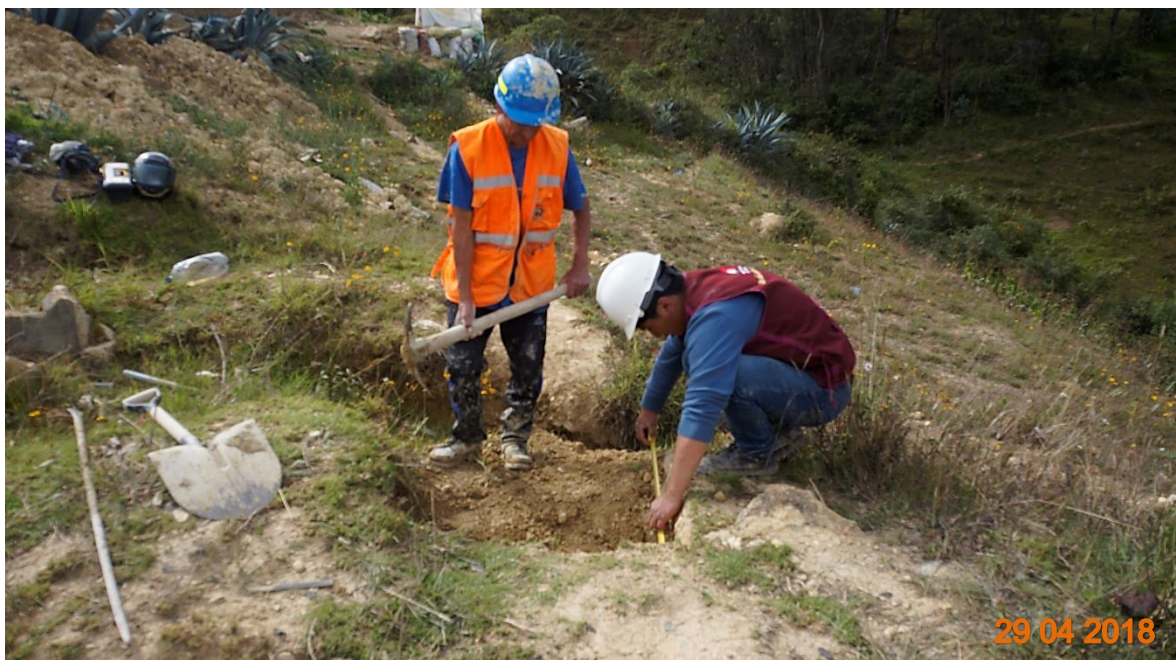
Figura 49. Realizando el trazo para excavación - captación 1.
