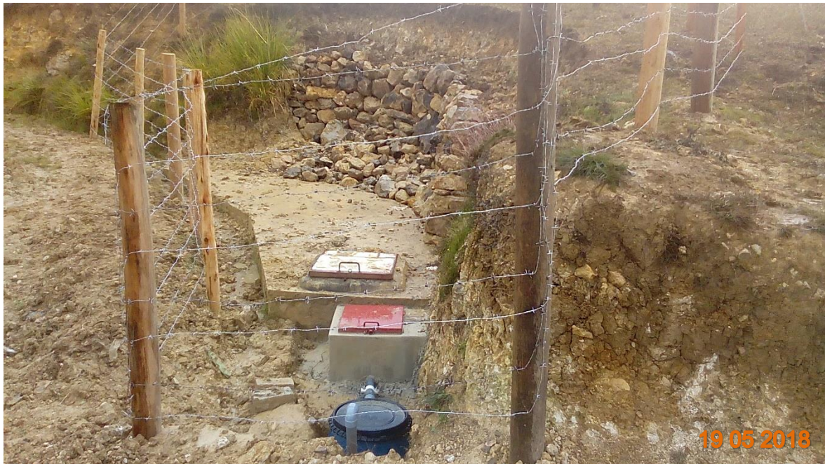
Figura 70. Colocación de cerco perimétrico- Captación 1.
