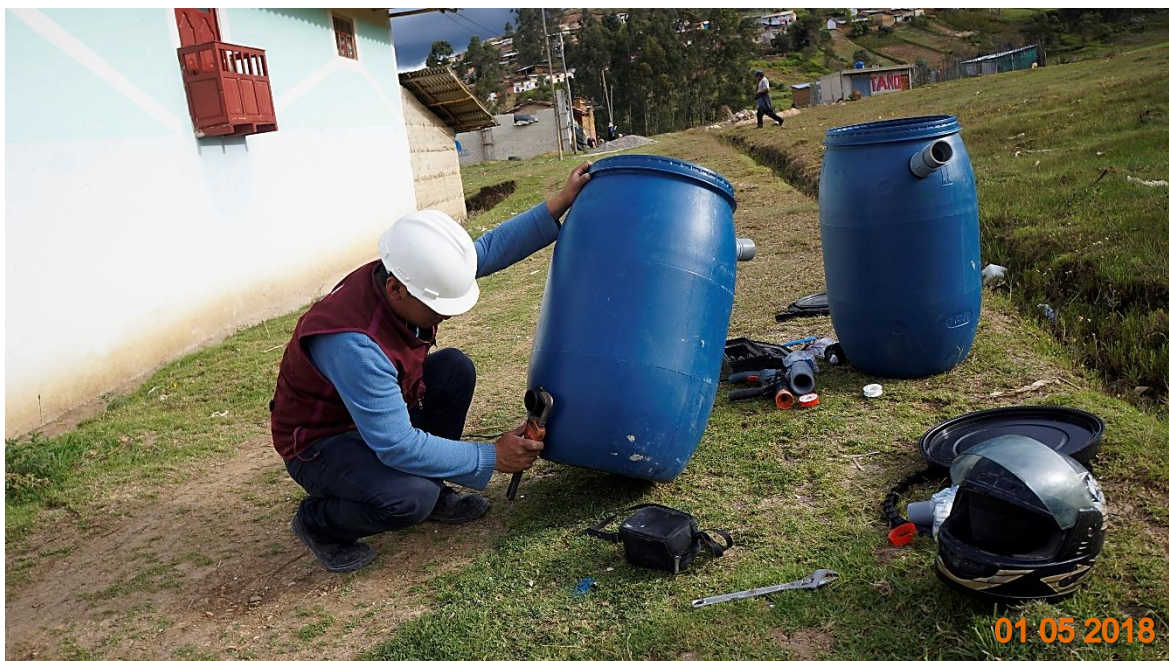
Figura 56. Instalación de kit de rebose para tanque
