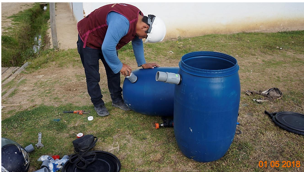
Figura 57. Colocación de unión y adaptador PVC Ø 2"
