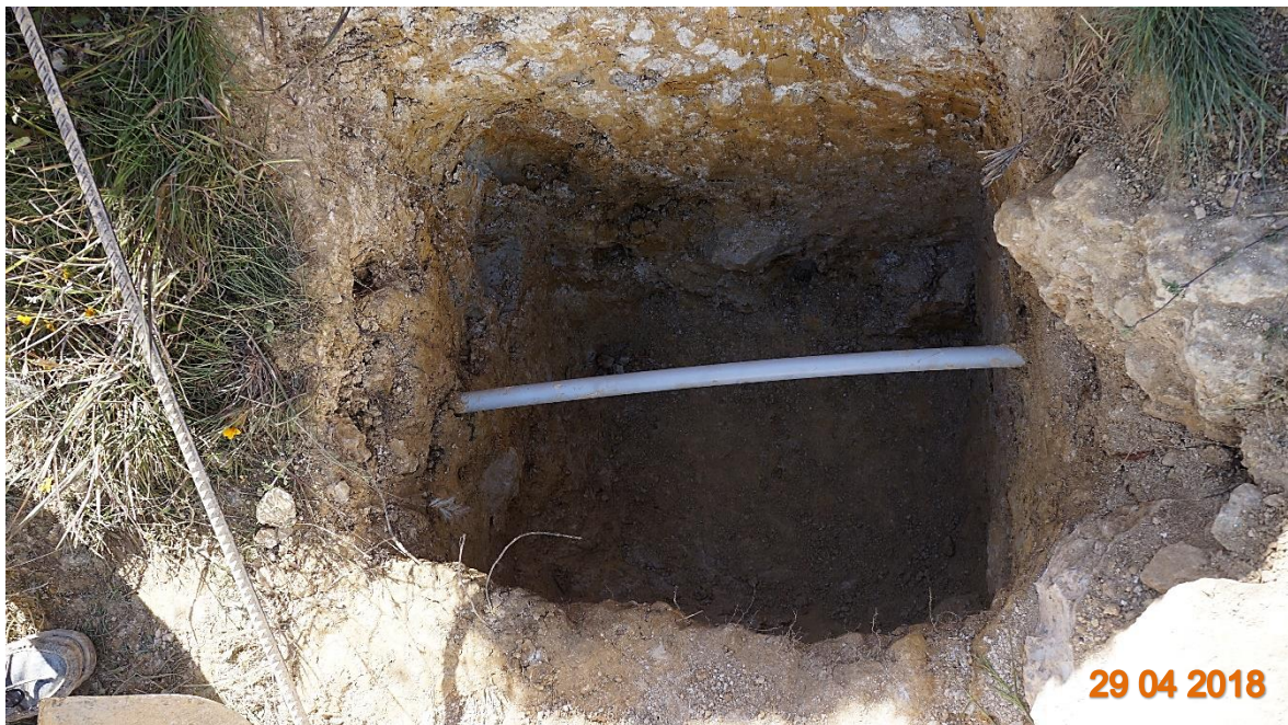
Figura 53. Corte de tubería existente - captación 1.
