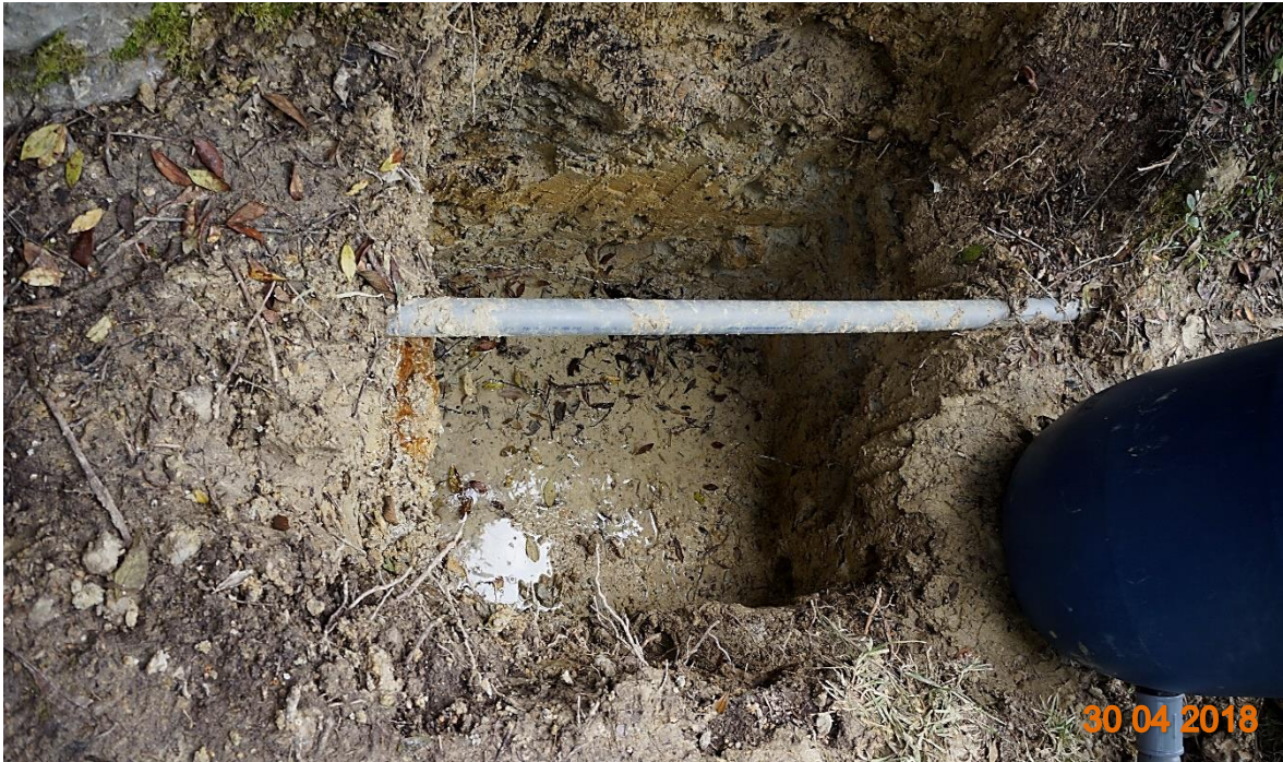
Figura 54. Corte de tubería existente – captación 2.
