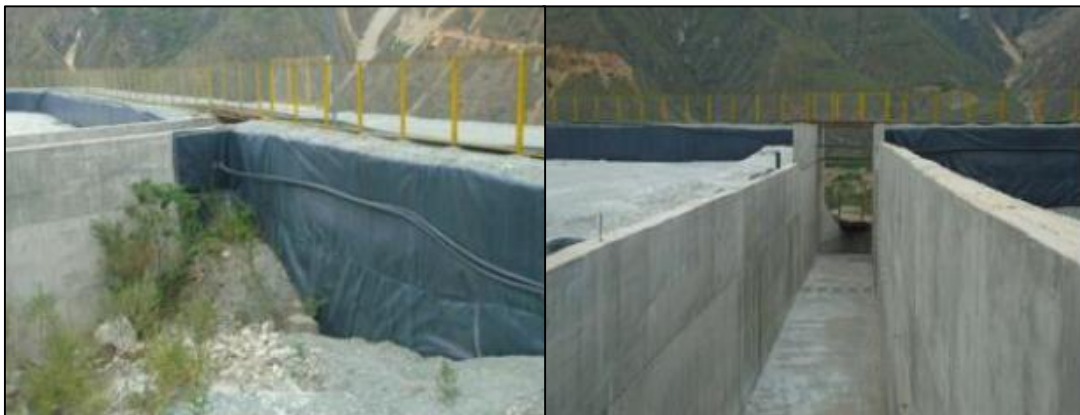
Figura 5.4. Estructura Hidráulicas de Alpamarca
