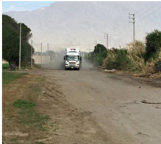
Figura n°. 14: Inspección visual de la vía
