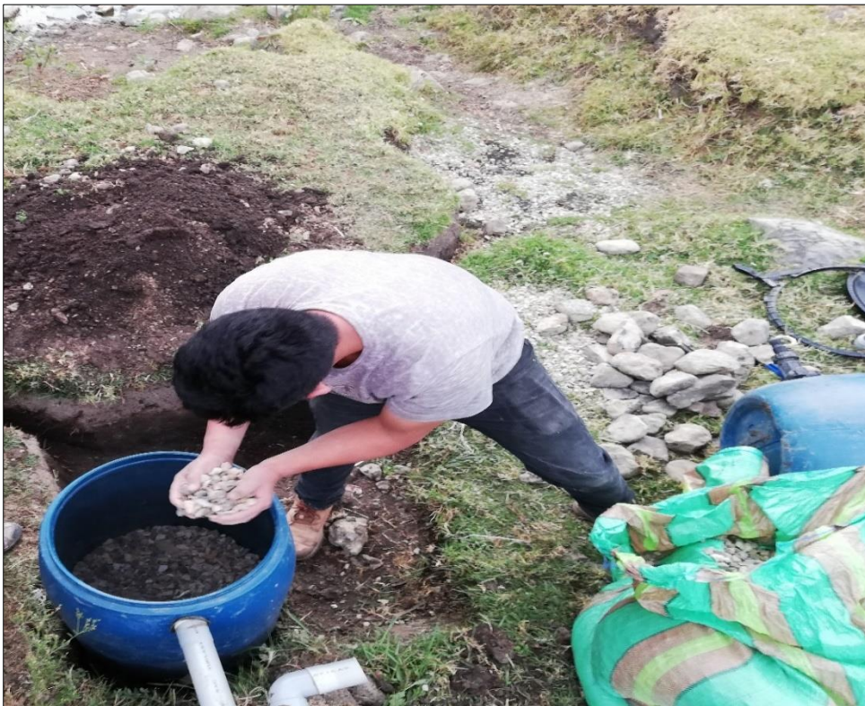
Fotografía N° 11: Colocación de segunda capa de gravilla a filtro de carbón activado
