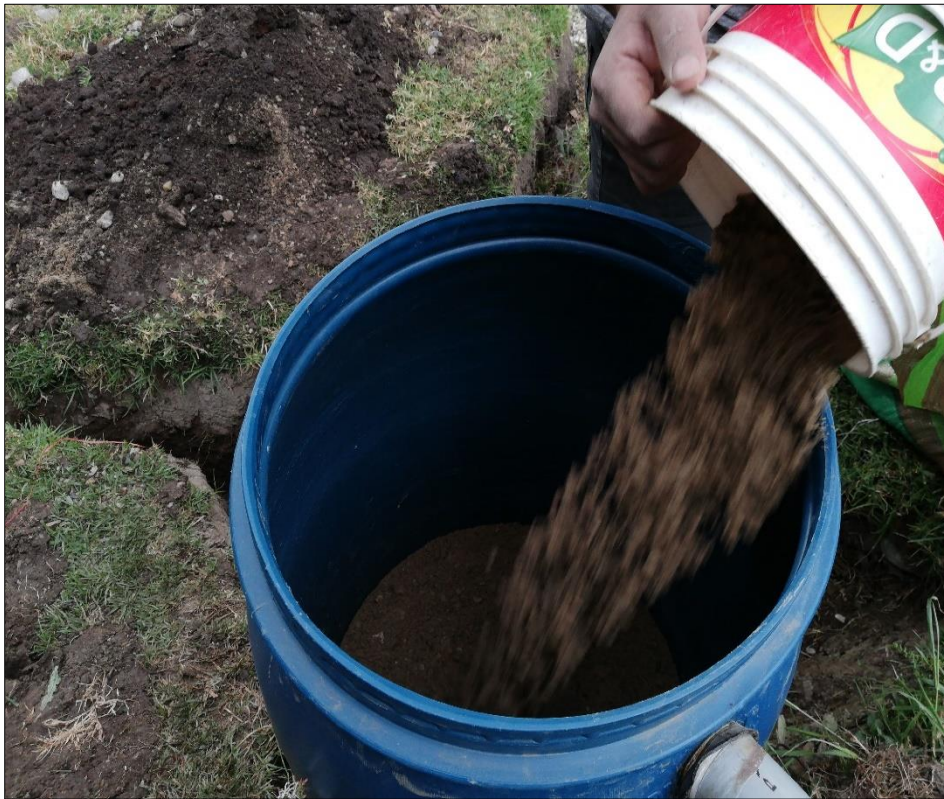
Fotografía N° 12: Colocación de tercera capa de arena gruesa a filtro de carbón activado
