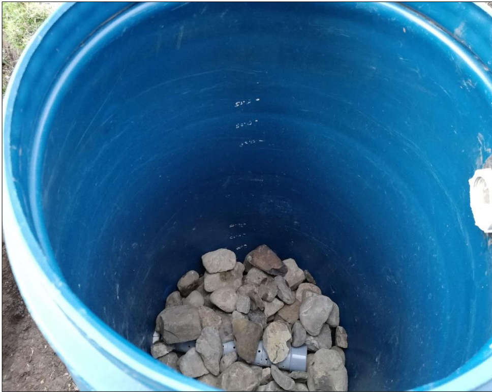
Fotografía N° 10: Colocación de primera capa de piedra grande a filtro de carbón activado.
