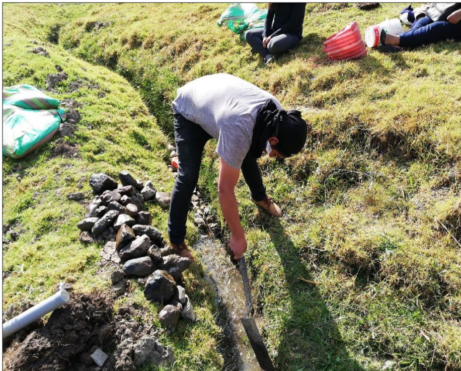
Fotografía N° 3: Excavación de zanja para filtro francés.
