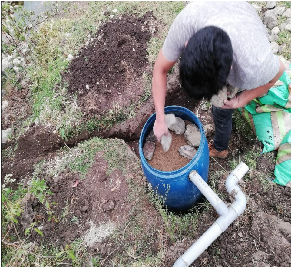
Fotografía N° 16: Colocación de séptima capa de piedra grande a filtro de carbón activado
