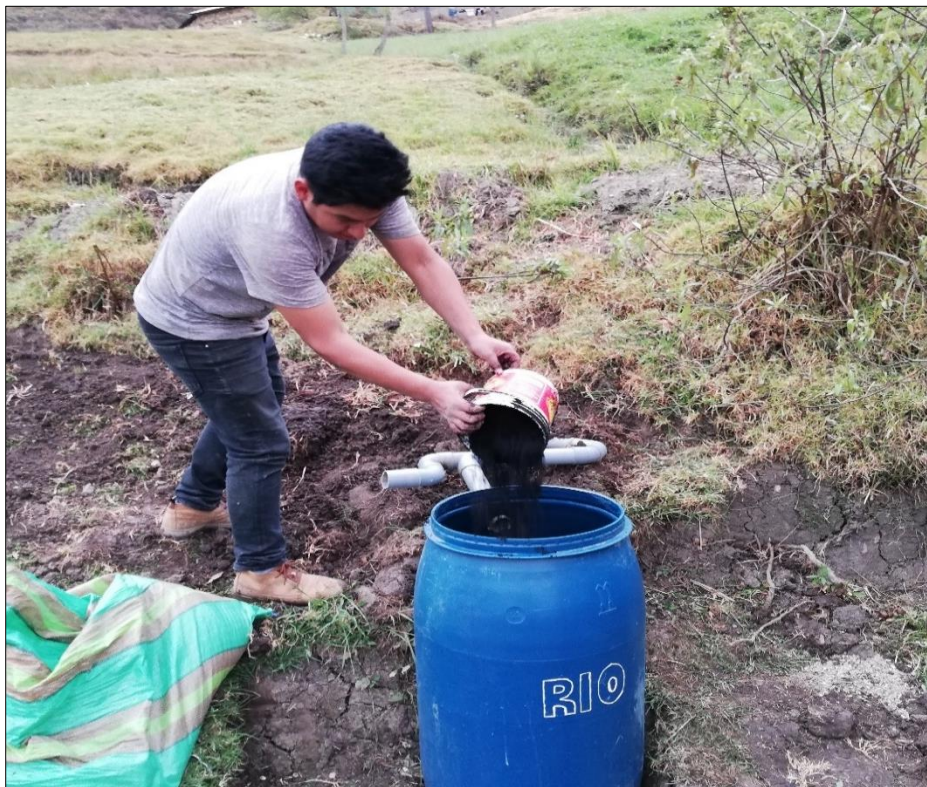
Fotografía N° 13: Colocación de cuarta capa de carbón activado a filtro
