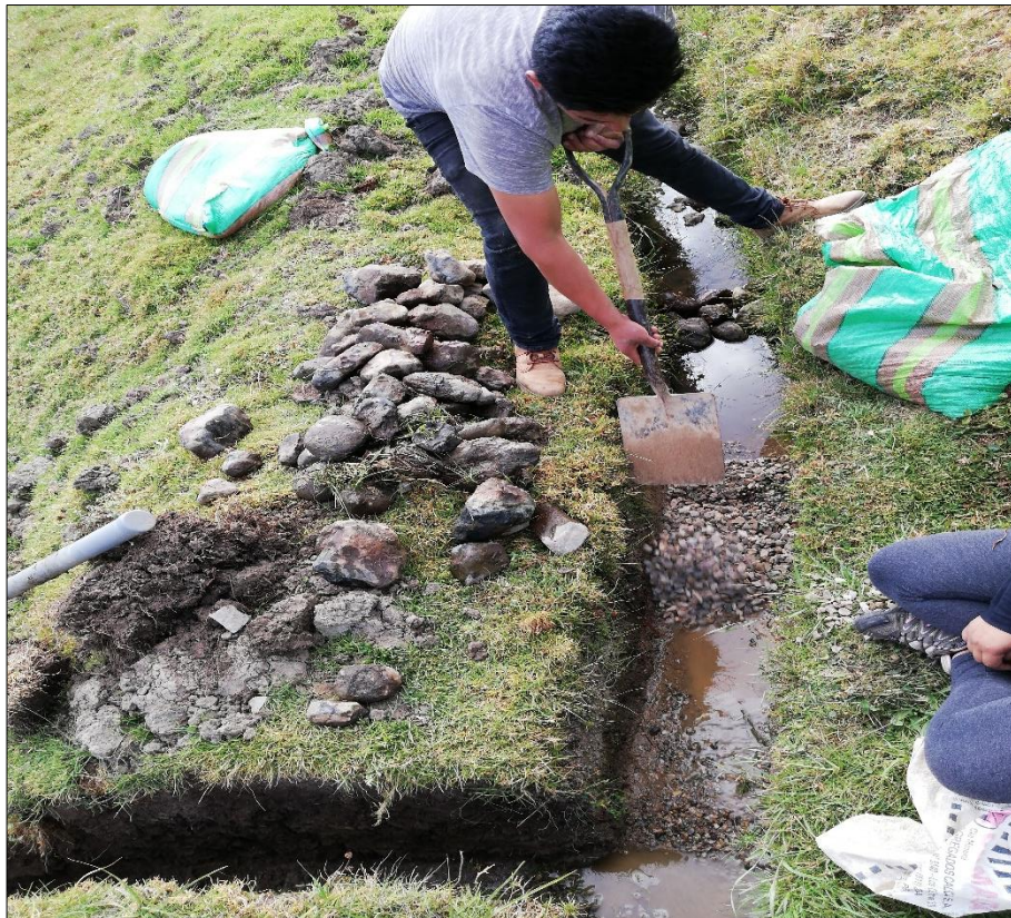
Fotografía N° 6: Colocación de capas de arena gruesa y gravilla al filtro francés
