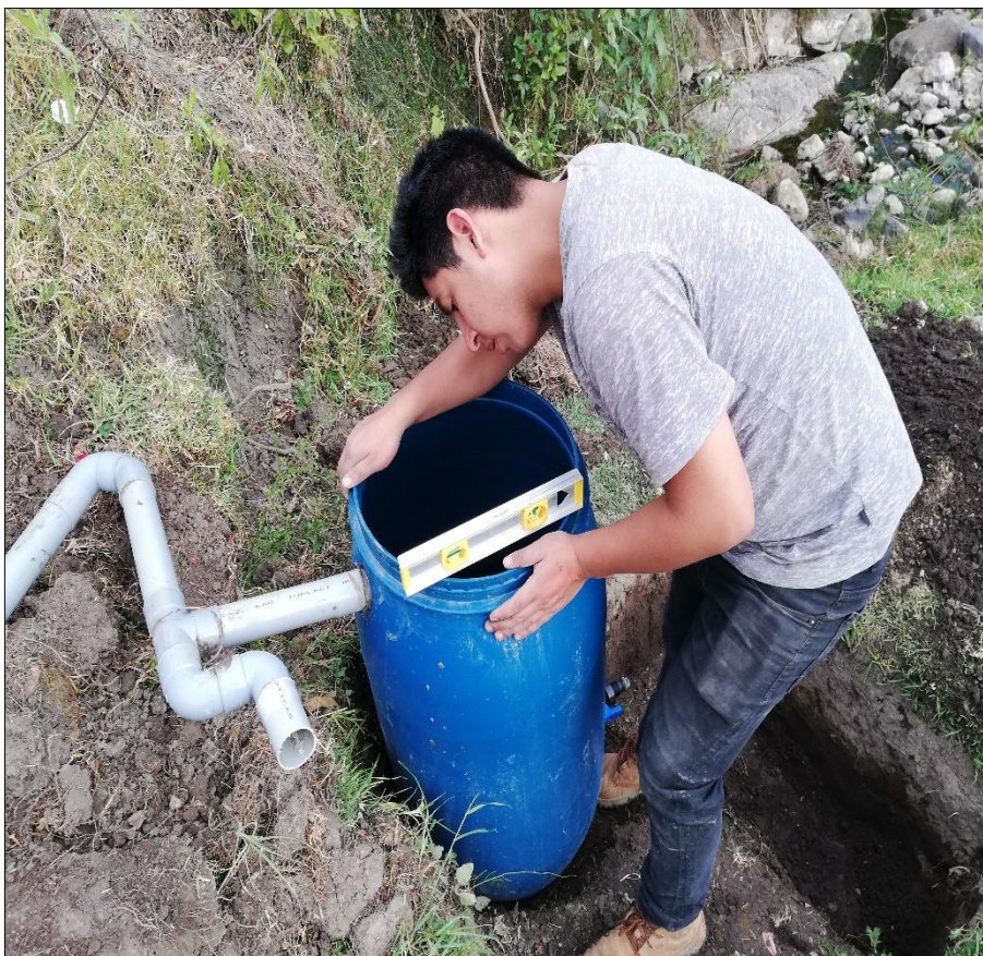
Fotografía N° 5: Nivelación de filtro de carbón activado
