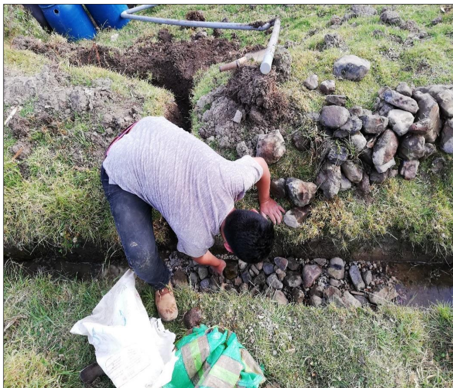
Fotografía N° 7: Colocación de capa de piedra grande a filtro francés
