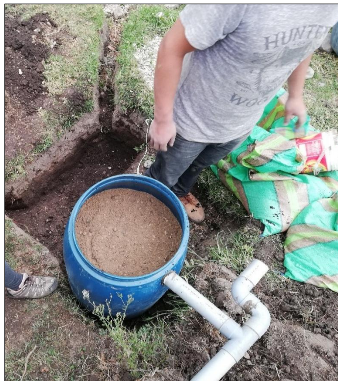
Fotografía N° 15: Colocación de sexta capa de arena gruesa a filtro de carbón activado
