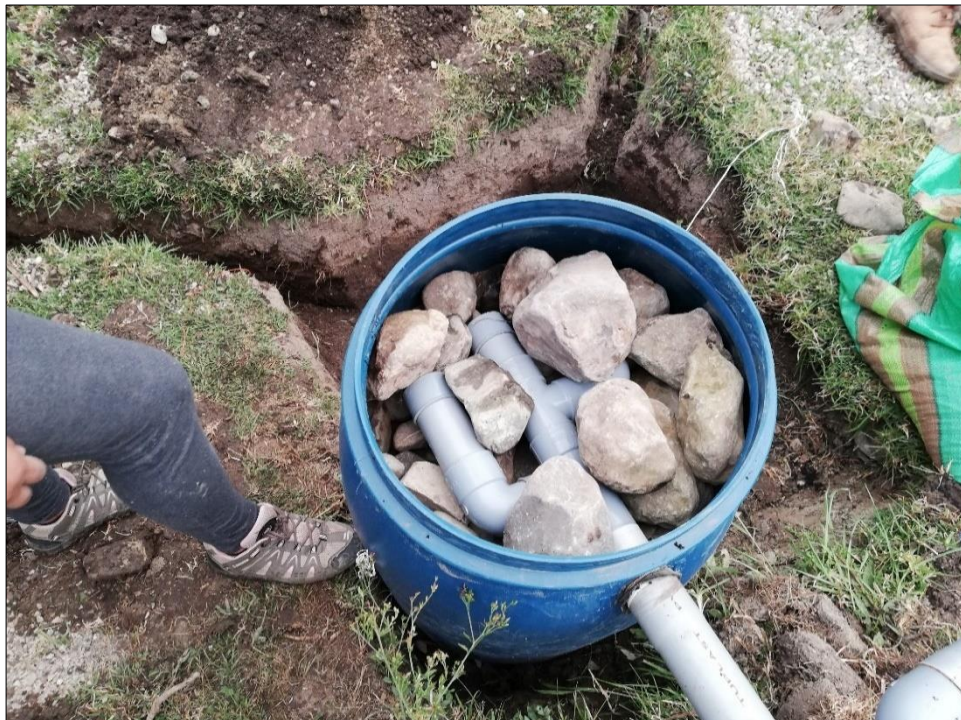
Fotografía N° 17: Colocación de tubería agujereada para caída de agua a filtro de carbón activado
