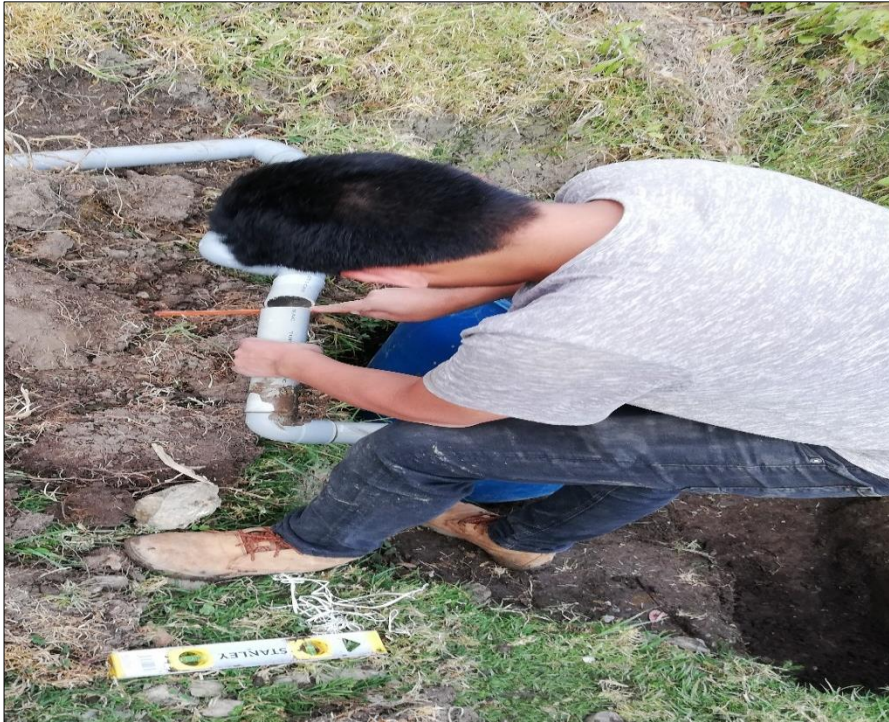
Fotografía N° 4: Instalación de tubería para filtro de carbón activado
