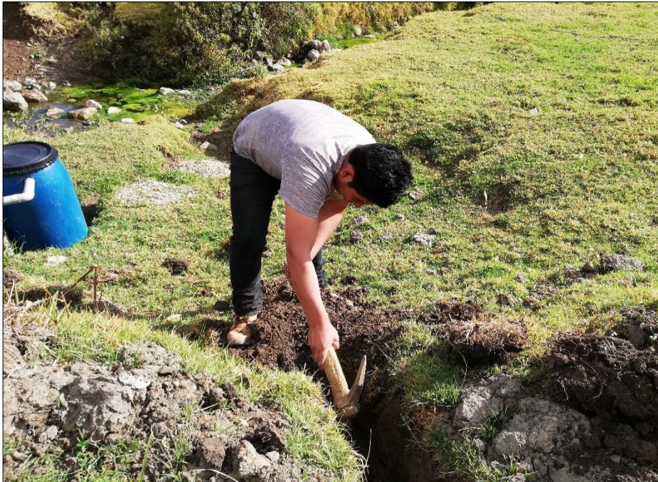
Fotografía N° 2: Excavación de zanja para filtro de carbón activado
