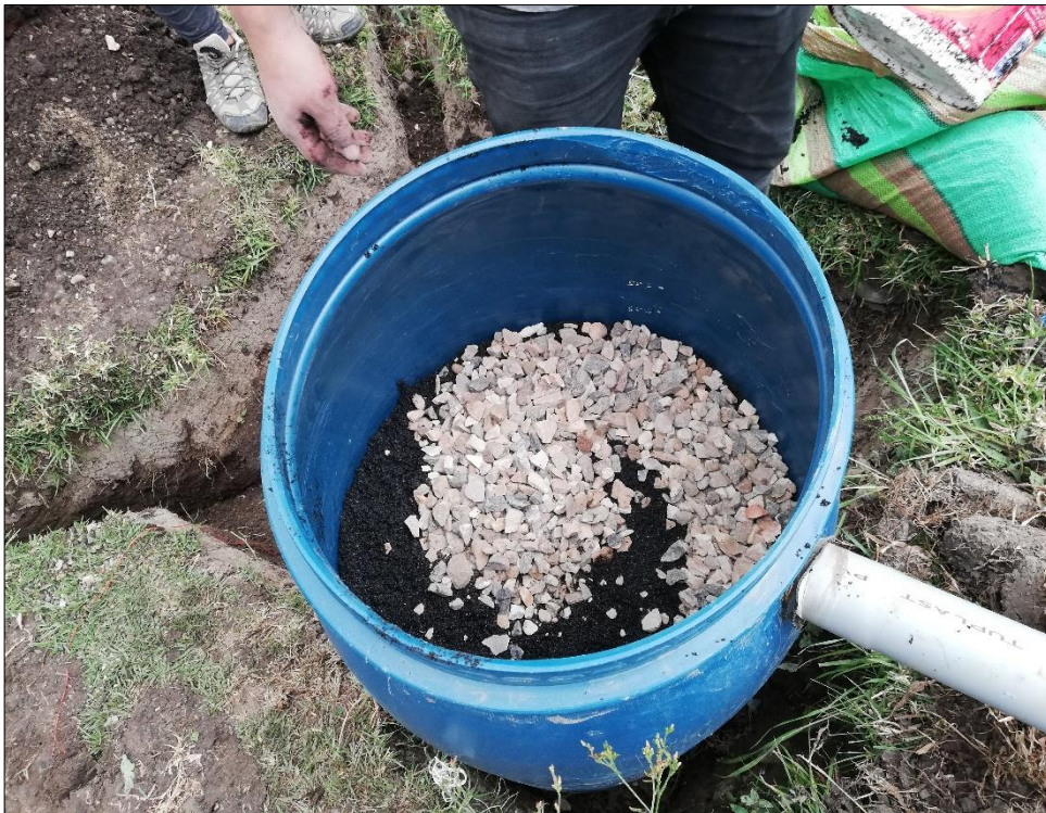
Fotografía N° 14: Colocación de quinta capa de gravilla a filtro de carbon activado
