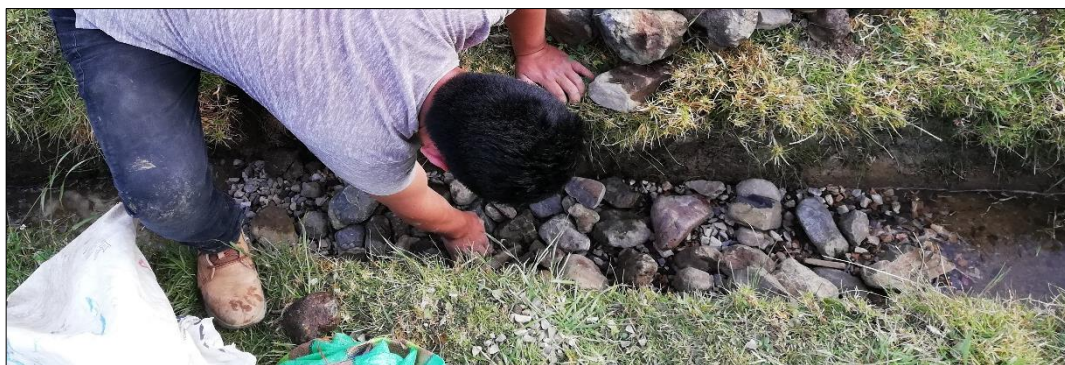
Fotografía N° 1: Ubicación de filtro francés.
