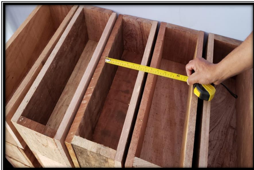
Figura 75. Moldes de especímenes viga. Fuente Propia
