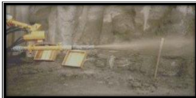
Figura 15. Concreto Proyectado (2016). MACCAFERRI. Reimpreso con permiso.
