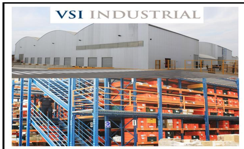
Figura n. ° 2-2 Almacén de la empresa Vsi-Industrial.
