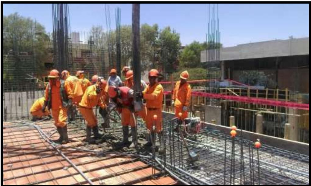
Fotografía 1: Personal de la obra vertiendo concreto en losa. Todos los trabajadores se encuentran con EPP, las zonas se encuentran delimitadas (PELIGRO).
