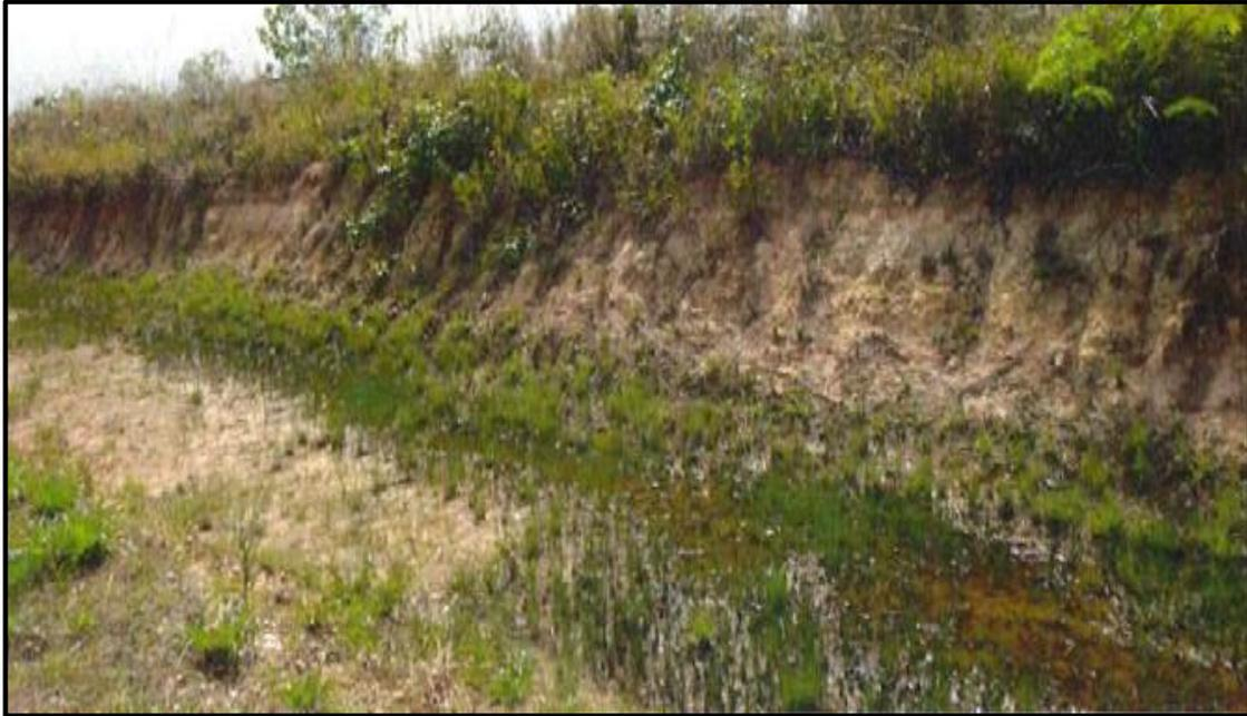
*Fotografía N° 2: Vista de Dren de lado derecho y erosión de talud*
