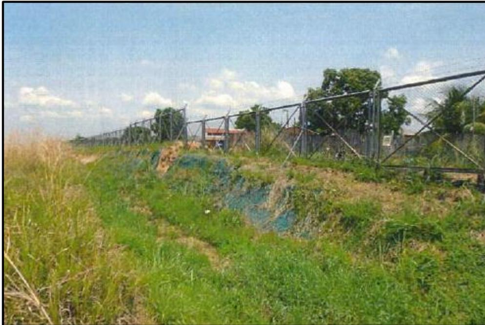
*Fotografía N° 4: Vista de Geomanta dañada y perdida de material de talud*
