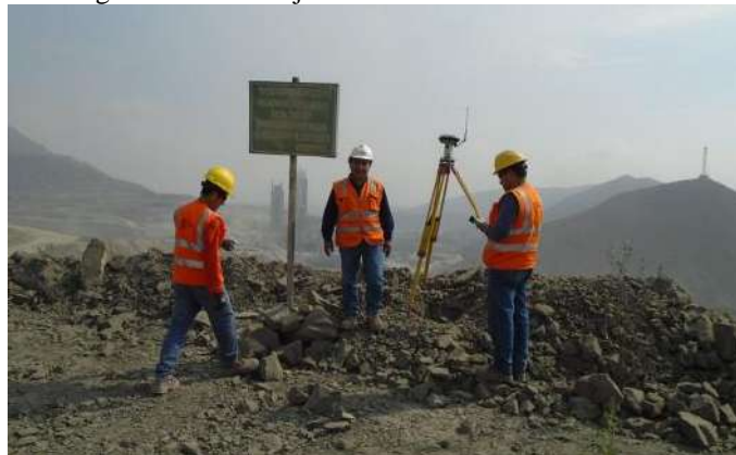
Figura III.20 Trabajadores en la toma de mediciones
