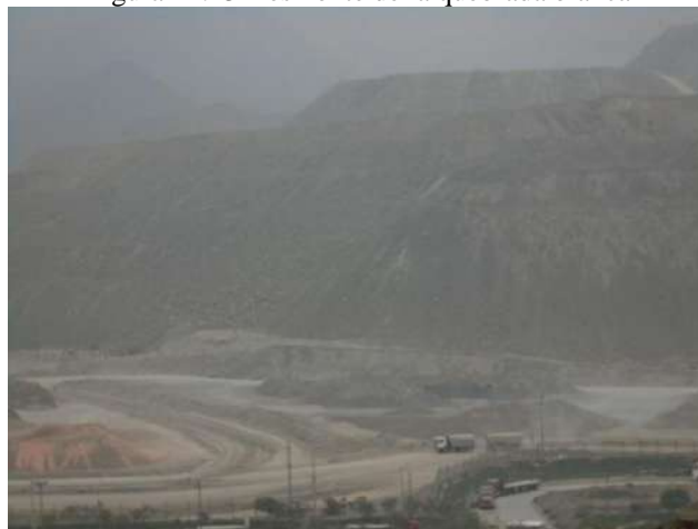
Figura III.23 Desmonte de la quebrada blanca
