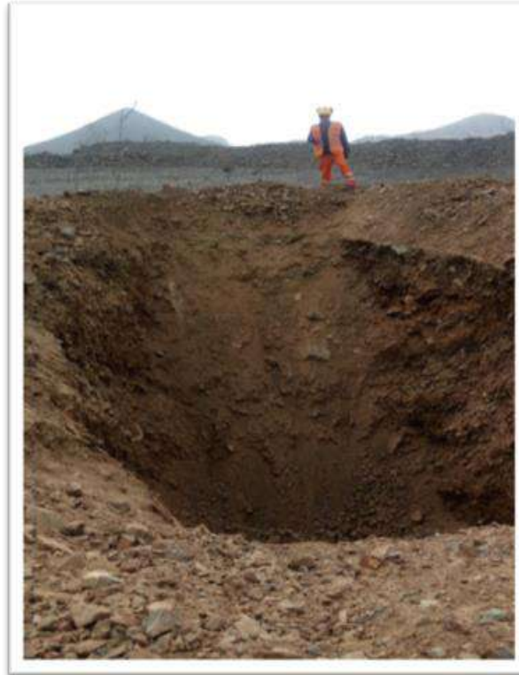
Figura III.2 Ejecución de la calicata C-2, en desmontera Quebrada Blanca
