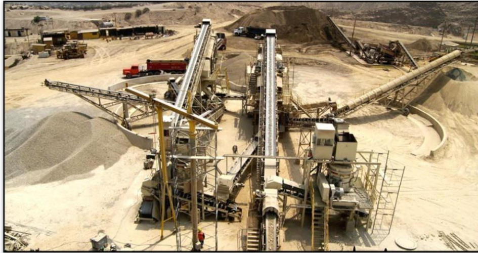
Figura N° 6. Imagen empresa Química Suiza Fuente: Empresa del proveedor de agregados.
