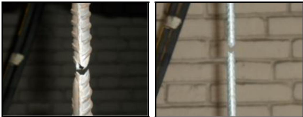
Figura n.º 41. Rotura en barras corrugas negra y galvanizada.
