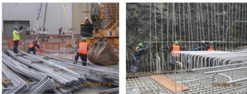
Figura n.º 5. Uso de barras galvanizadas, en obras, en Chile.
