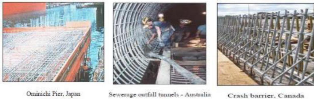
Figura n.º 4. Uso de barras corrugadas galvanizadas, en obras, en Japón, Australia y Canadá.
