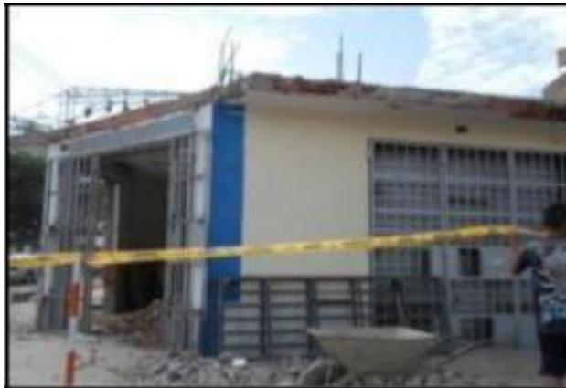
Figura n.º 9. Casa en demolición
